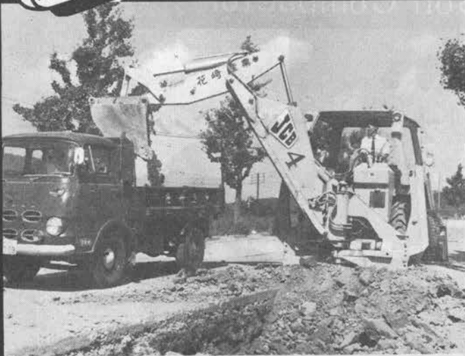
水道管敷設工事に活躍中の JCB-4 (花崎産業殿納入)
