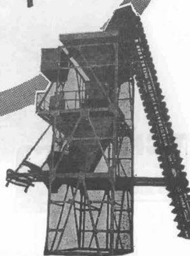
バッチャープラント
