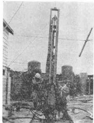
写真-10 ザルツギッタ社のシャフト用さく孔機
