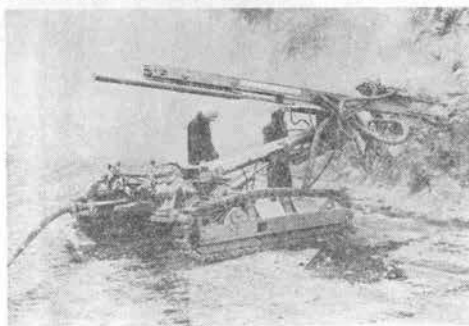
写真-7 鶴田ダムでせん孔中の PR 123 型
