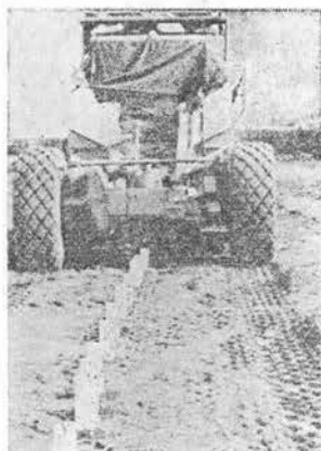
写真-3 ペーパードレーン施工中
