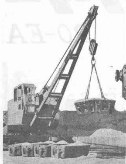
Z312型機関及びSCA 0.85型トルクコンバータ搭載の5トン トンボクレーン
