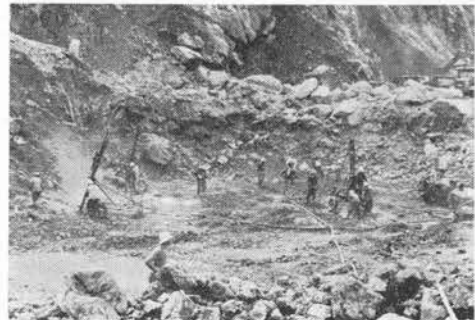
写真—1 田子倉ダムの岩盤掘削に活躍するワゴンドリル
