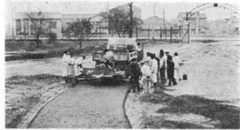
写真-1 304形スプレッドフィニッシャの舗設試験中
