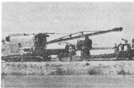
写真-2 KoehringのトリバッチミキサとRexのスリップフォームペーパーがDenverの近くで作業しているところを示す。
