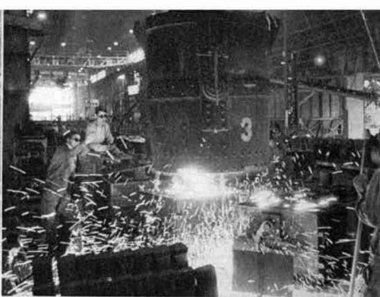
↑伝統ある精錬技術によって生みだされた湯は、鑄型ラインにそって鑄込まれ、優秀な鑄造技術によって製品化される。
