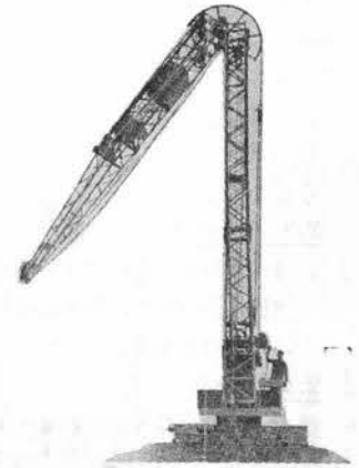
写真-8 自立形タワークレーン (起立途中の状態)
