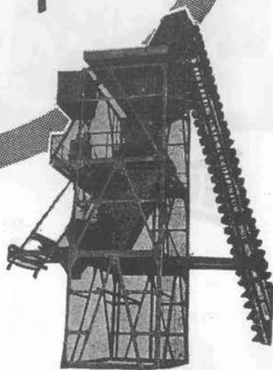
バッチャープラント
