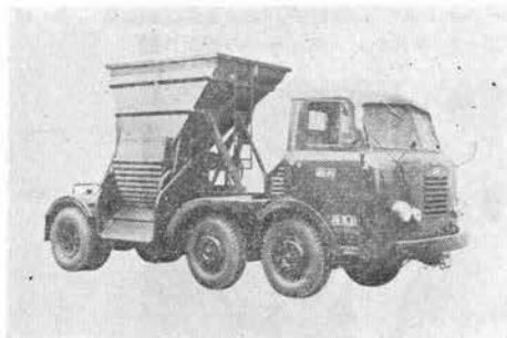
写真-1 生コンクリート運搬車
