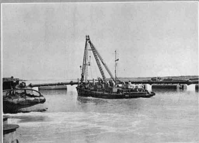
↑作業中のアンカーバージ
