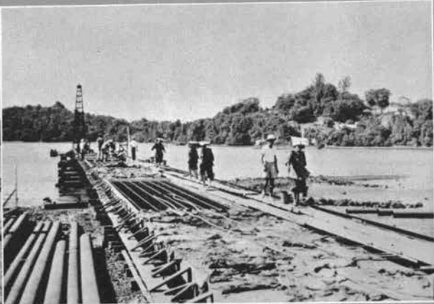
↑ Jetty歩道のコンクリート打設中
