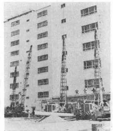
写真-1 ビルの基礎工事に稼働中のアースドリル
