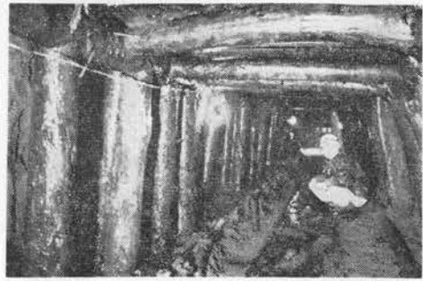
写真-3 東口中割導坑ウェルポイント設置後の状況
