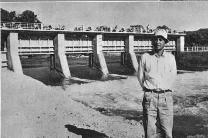
← 取入堰 溢流型コンクリートダム 長さ 164 ft 水門 6個 越流量 15,000 ft 3 /sec 取入口 ゲート 15 ft x 10 ft 6 in 溝水路 コンクリート水路 長さ 10,777 ft 断面 15 ft x 10 ft 6 in
