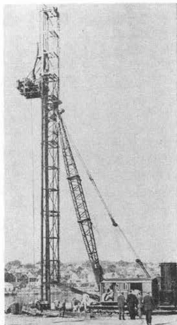
写真-1 くい打機の作業状況
