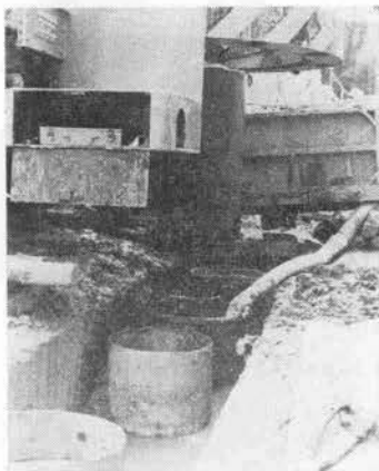
写真-4 土留くいの施工(ベントナイト液の溝を作って施工)
