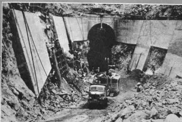
↑排水トンネル上口で活躍する重機
