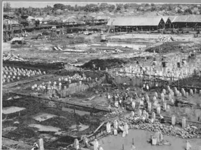
↑基礎くい打状況 (1960年2月)
