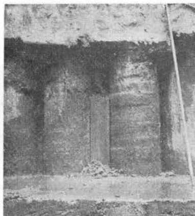
写真-5 土留くい
