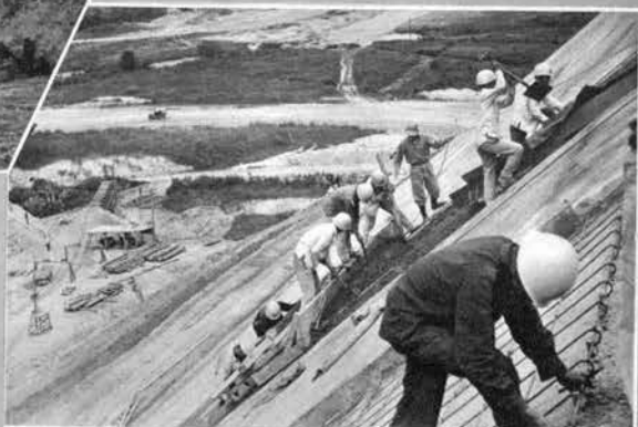
→余水路法面保護コンクリートの打設作業
