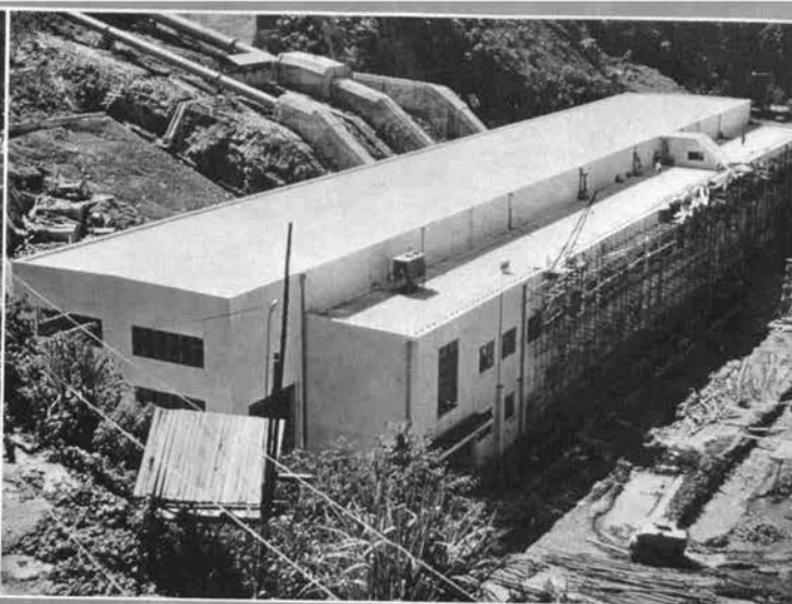
↑発電所建物(鉄骨コンクリート造り)
