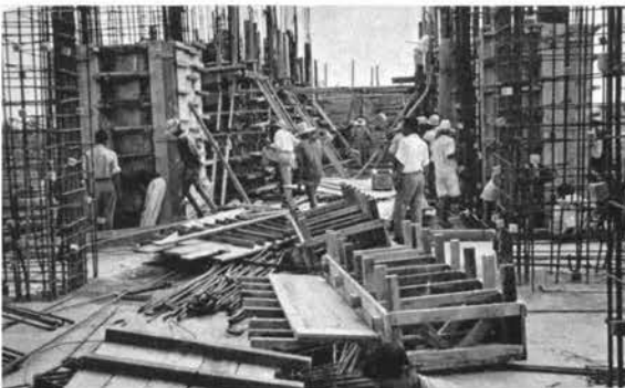
↑ノース・ウイング1階柱型わく 取付 (1960年7月)
