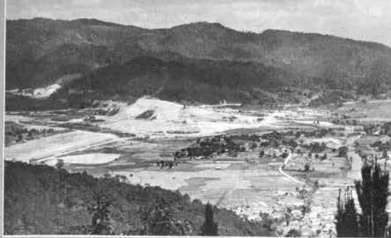
↑ダム現場付近全景
