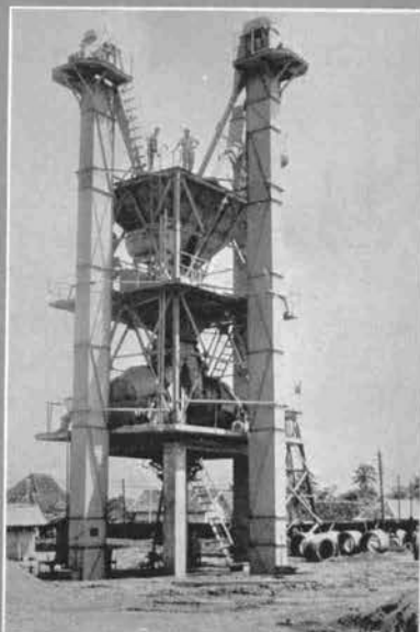
← バッチャプラント 組立完了
