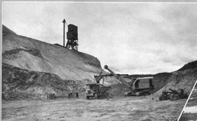
↑余水路上流側岩掘削 (1962-1-13)
