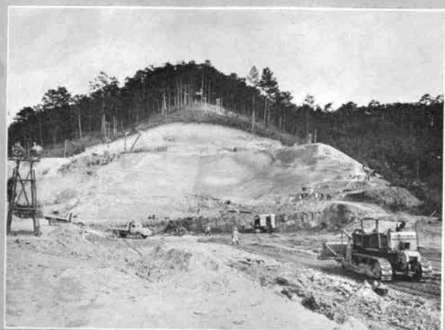
↑取水路および構造物基礎掘削 (1962-1-13)
