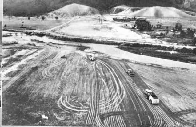
↑築堤工事盛土作業に活躍する重機群
