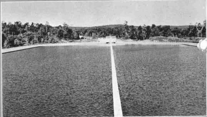
↑コンクリート調整池 貯水量 3,000,000 ft 3 長さ 1,185 ft 側壁高さ 11.5 ft - 18.5 ft
