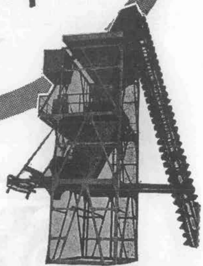
バッチャープラント
