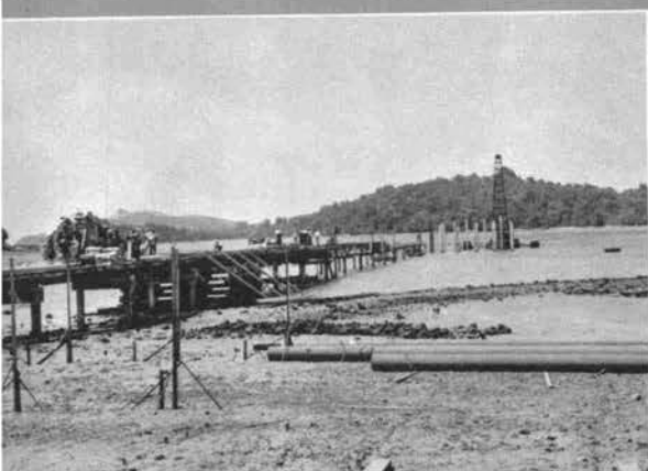
↑ くい打工事中の小型タンカー用のJetty工事
