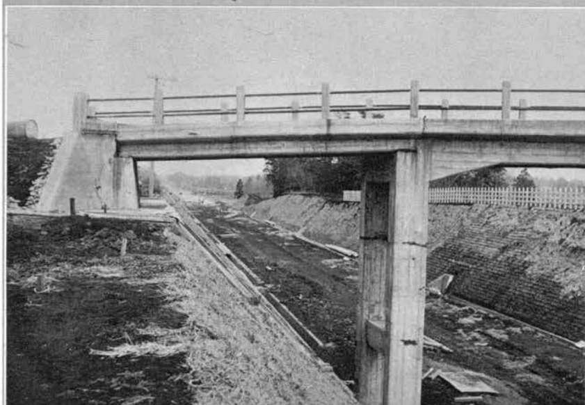
↑完成した路盤上に厚さ約30cmのサブバラストを散布し、ブルドーザで敷均す。前方では既に電柱が建植されている。
