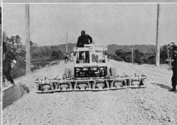
↑敷均した道床土をコンパクタで十分締固める。
