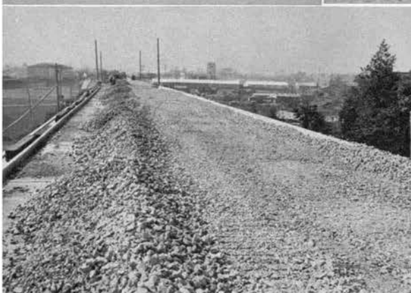
↑完成した路盤上に厚さ約30cmのサブバラストを散布し、ブルドーザで敷均す。前方では既に電柱が建植されている。
