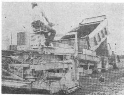
写真-1 第1レインの場合はガイド糸に乗るグリッド(矢印)に感受機を取り付ける
