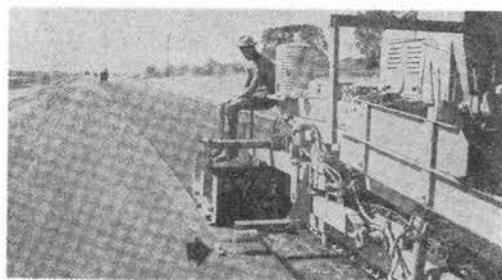
写真-2 第2レインの場合は舗装した第1レインに乗るそり(矢印)に感受機を取り付ける
