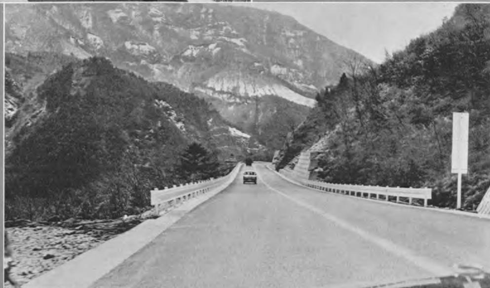
↓完成した箱根バイパス 第7工区
