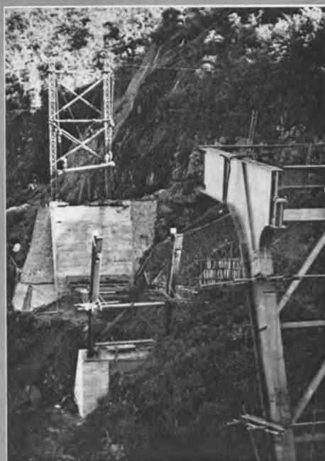
↑ 観音橋施工中 鋼方杖ラーメン橋、橋長85.6m、支間65m
