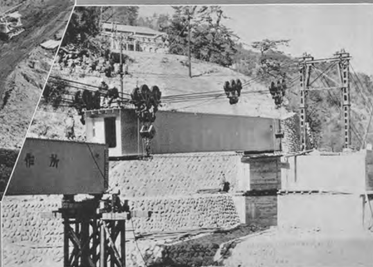
↑ 架設中の湯の川橋 活荷重合成箱けた、橋長63.9m、支間63m
