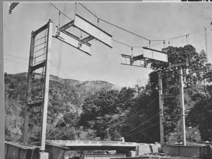
↑ 架設中の猿沢橋 鋼橋脚、3径間、連続扱けた 橋長108.8m、支間108m
