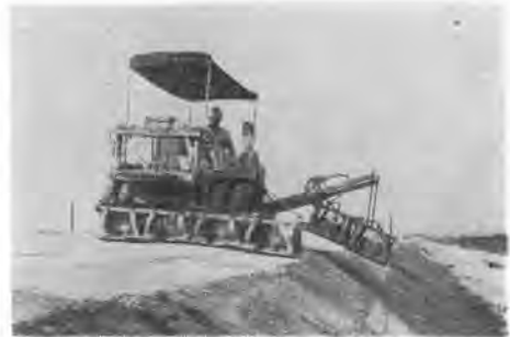
写真-1 バイブレートリーコンパクタ
