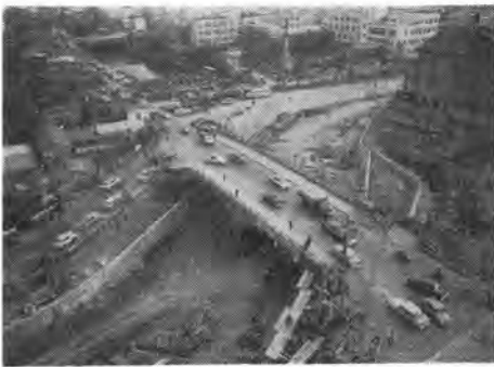
写真-3 首都高速道路1号線菜女橋付近河底工
