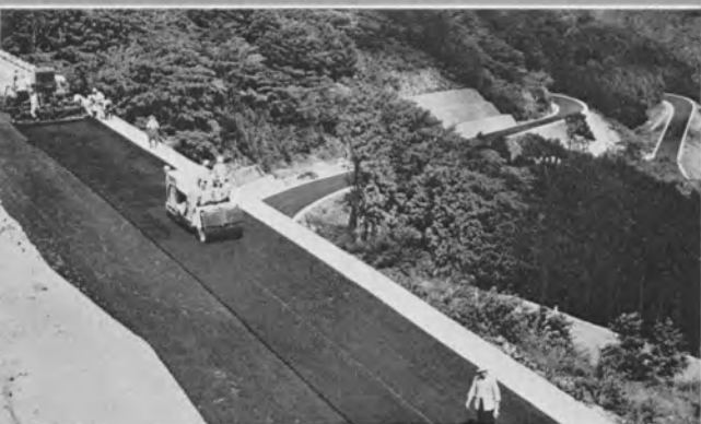
← アスファルト舗設作業
