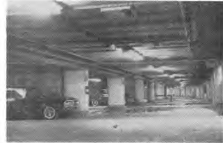
写真-6 汐留駐車場内部
