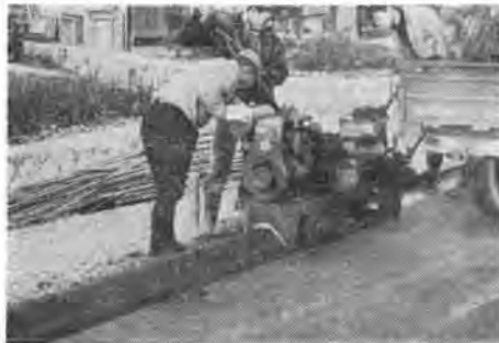
写真-2 稼働中のカーブナー
