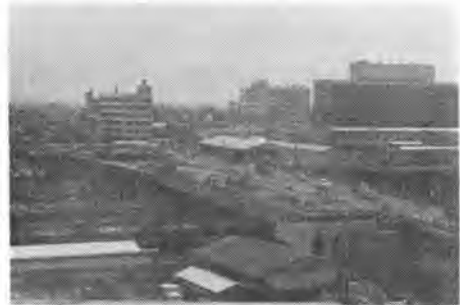
写真-3 新宿線橋拡幅工事(甲州街道)
