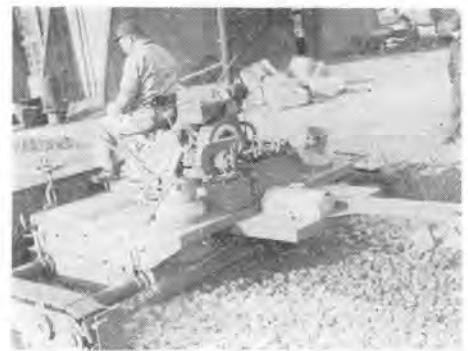
写真-17 酒井アンマン製スプレッドフィニッシャ
