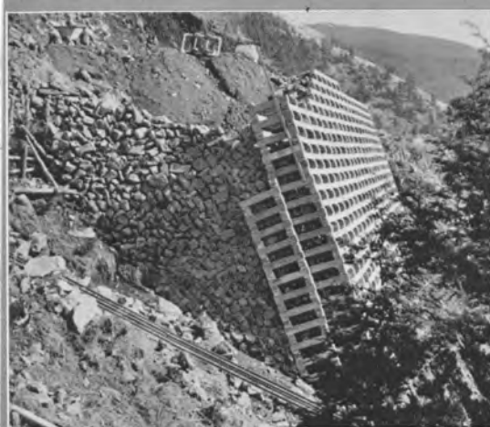
↑ 井げた擁壁工事 崖錐地帯の土留に使用された。
