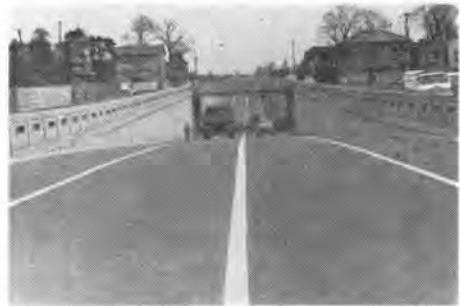
写真-2 環状7号線と補助52号線の立体交差(世田谷区若林町)
