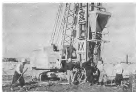
写真-4 ポッパーからケーシング内への砂投入作業
