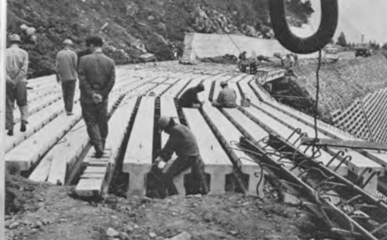
↑二子椏橋架設中 4径間、PCけた、橋長 40m
