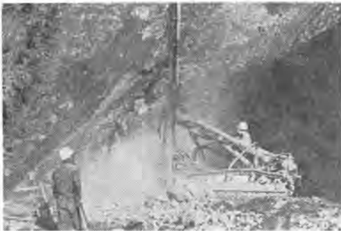
写真-2 ADT 3000 型エアトラックドリル
