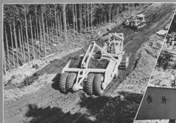
↑ スクレーバによる土工作業 第9工区工事現場（昭和34年8月）
