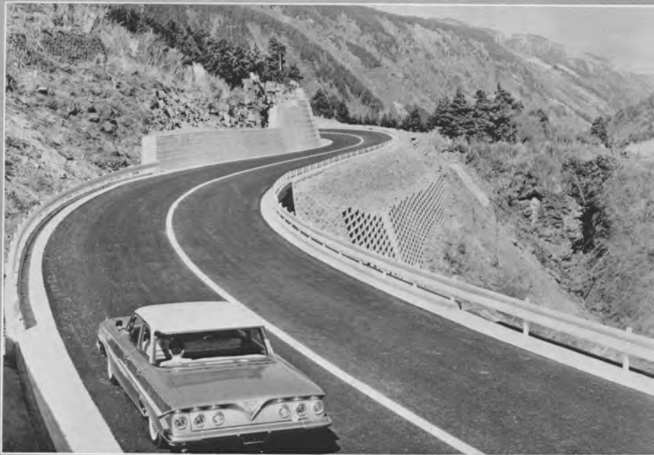
↑完成した箱根バイパス 二子峠付近 クロノイドによる反向曲線
