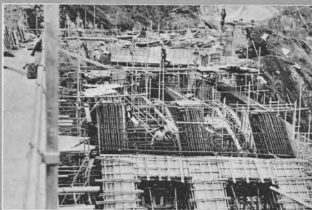
↑ 天狗橋の架設工事 鉄筋コンクリート方杖ラーメン構造 (昭和35年12月)
