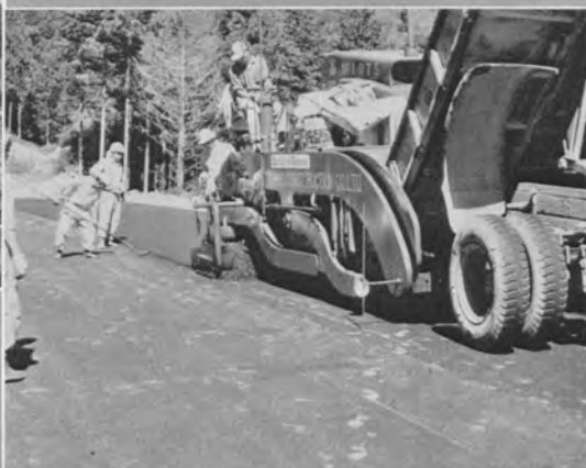
↑中間層施工中
