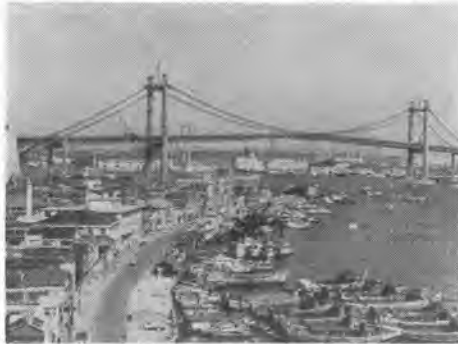
写真-2 完成近い若戸橋
