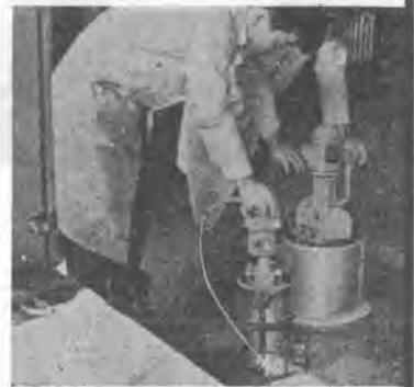
両機の振動作業中
