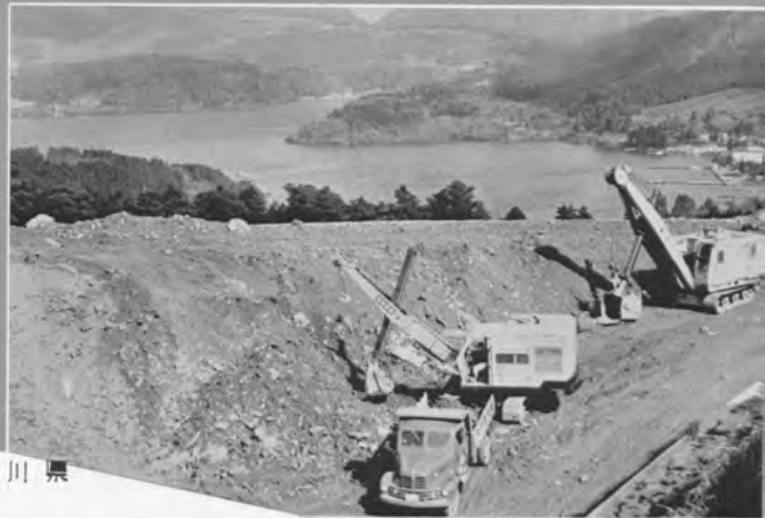
↑パワーショベルによる 土工作業 終点インターチェンジ 付近 (昭和36年12月)
