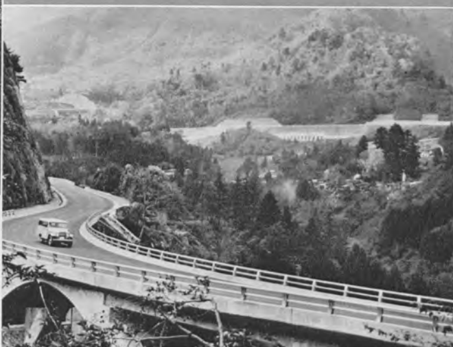
↑ 完成した天狗橋 曲橋半径 60m、橋長 89.4m
