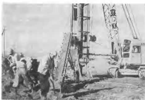
写真-3 ベルコンによる砂投入作業
