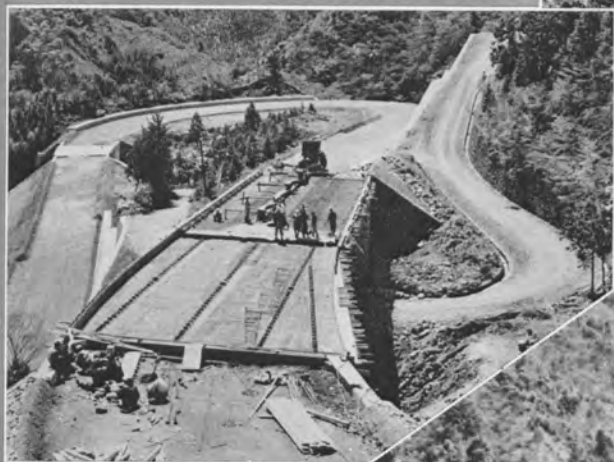
↑ 七曲り2の橋の床版打設工事 2径間、ゲルバー飯げた橋、 橋長 50.7m
