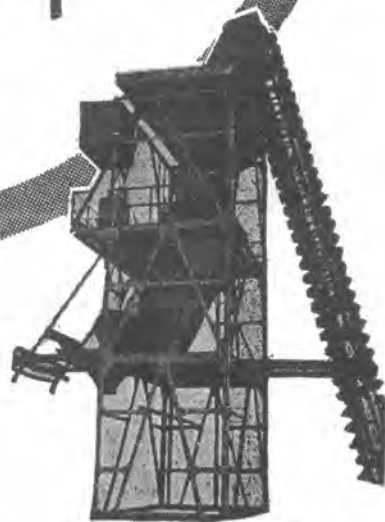
バッチャープラント
