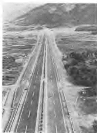
写真-1 完成した名神高速道路 山科付近
