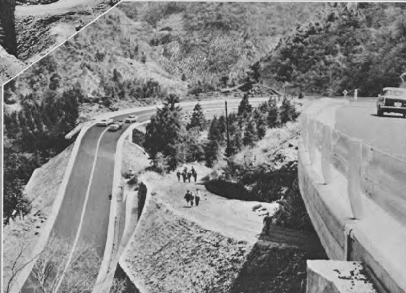
→ 箱根バイパス七曲り付近 中央人の歩いている道路は 旧東海道
