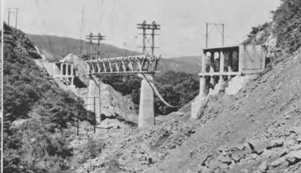
↑架設中の黒岩橋 3径間連続トラス、橋長 140.7m
