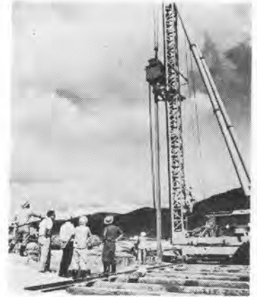
写真-3 シートパイルの打込み作業
