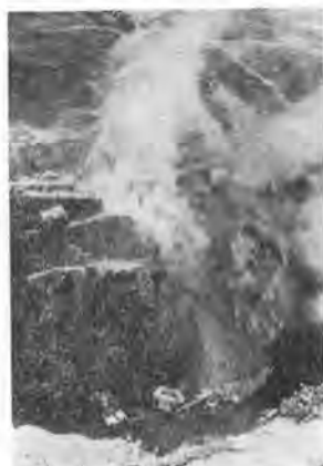
写真-2 左岸A点エアトラックのドリルでせん孔中、白煙の中央に柱のように黒く見える。空気圧力 6 \text{ kg/cm}^2
