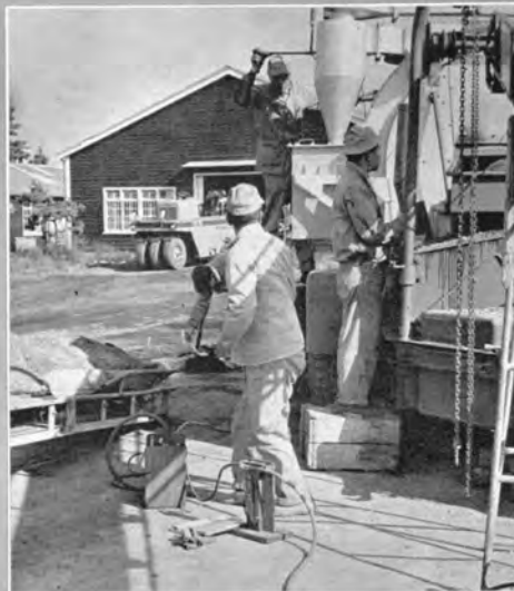
↑アスファルトプラントの性能試験
