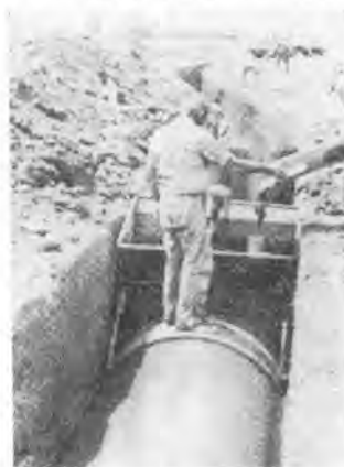
写真1 48 inch の No-joint パイプ (California, Sacramento)
