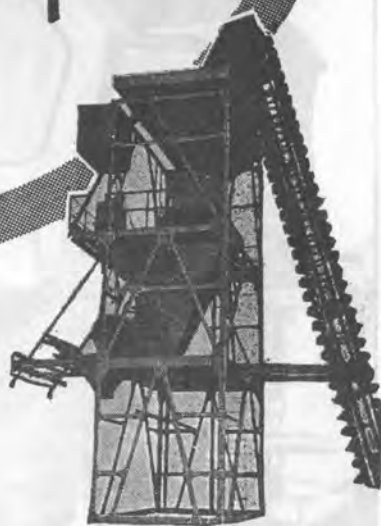
バッチャープラント
