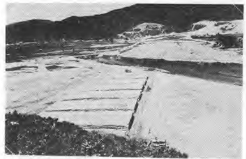
写真-4 左岸 インターセプターのため掘削中
