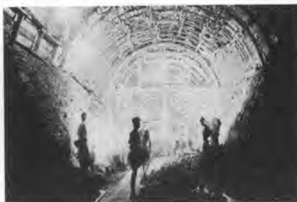
写真-2 逆巻でコンクリート打設中の構造
