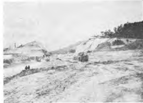
写真-1 余水吐、下流より見る
