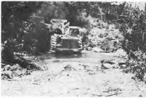
写真-1 サイゴン現場間 300 km, ジャングルを切開き河床を横断して自走するモータスクレーバ
