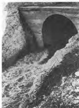
写真-5 ずい道排水口
