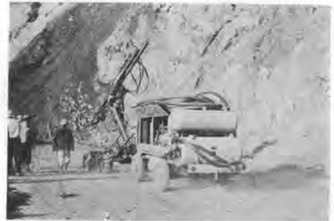
写真-1 ポータブルコンプレッサけん引の ATD-3000 エアトラックドリル
