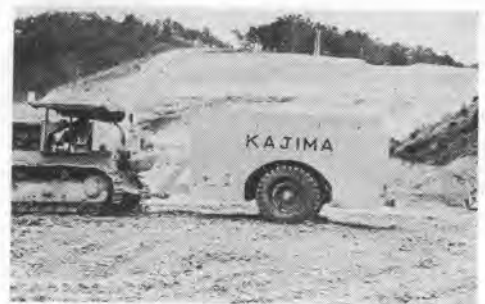
写真-5 盛土転圧中の 50t タイヤローラ
