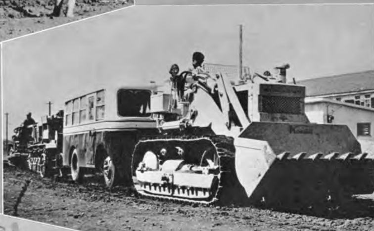
↑履帯式トラクタショベルの性能試験
