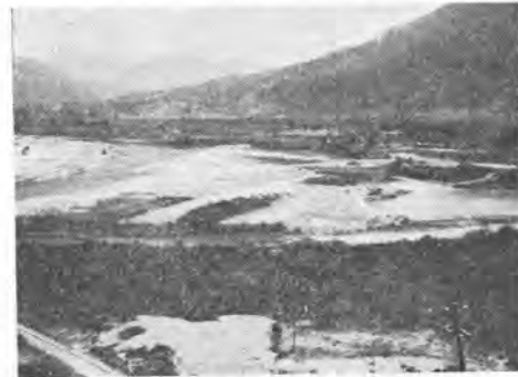
写真-2 余水吐骨材採取場
