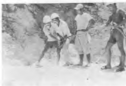
写真-3 明り掘削中のインドネシア坑夫
