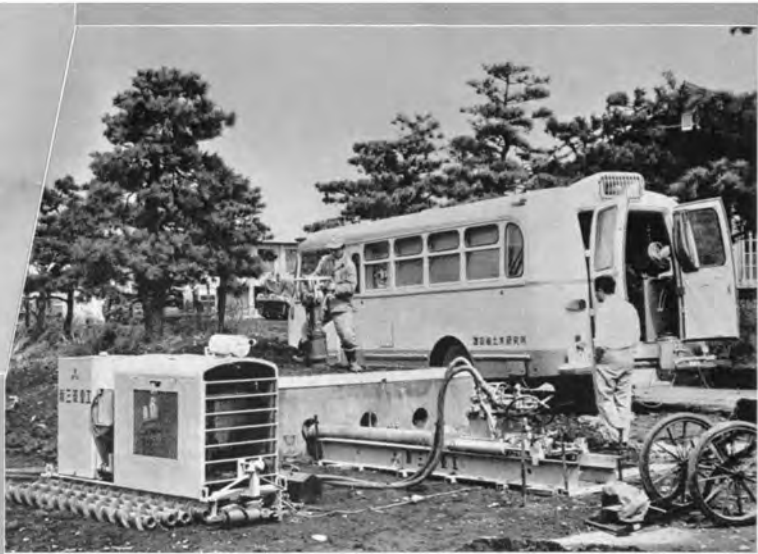
↑ ホリゾンタルオーガの性能試験 — 作業時油圧測定 抵抗線油圧計、回転計による計測を実施 新三菱重工 HA-15B (昭和37年春)
