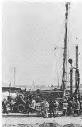
写真-1 実演中のリパースサーキュレーションドリル
