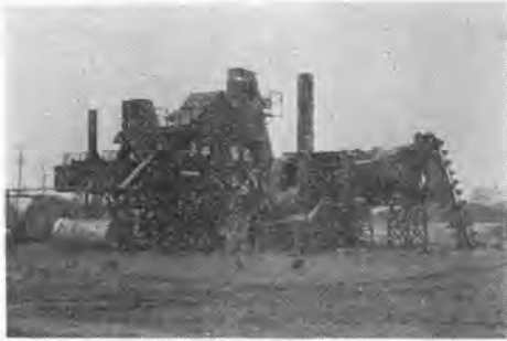
写真-8 パーバグリーン 847 型プラント
