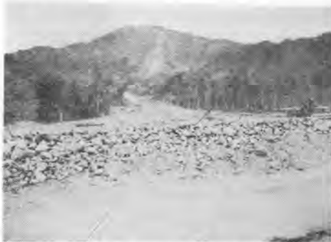
写真—4 発電所から鉄管路を望む
