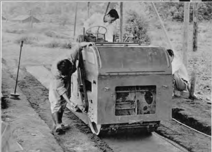
← 振動ローラの性能試験 — 土の締固め試験 酒井工作 RS-31 (昭和34年春)
