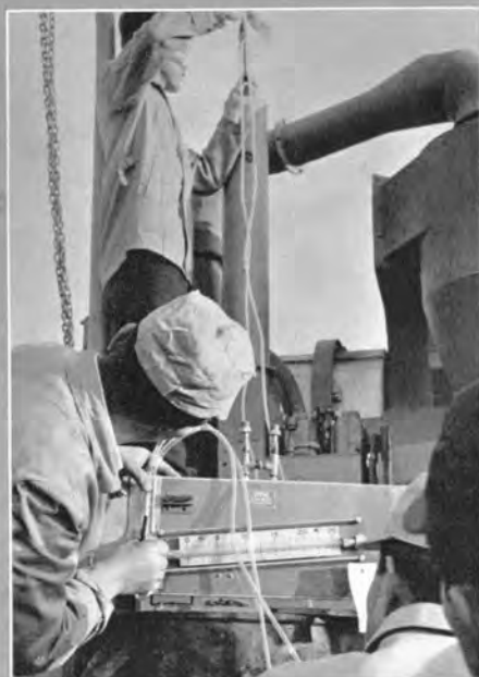
← アスファルトプラ ントの性能試験
