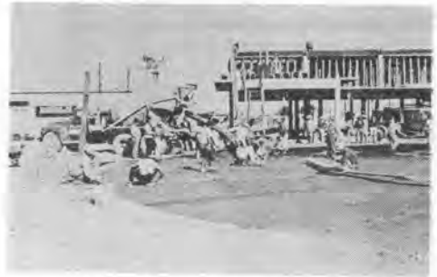
写真-1 工事現場
