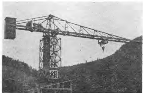
写真-7 1.7t タワークレーン(浦賀ドック)
