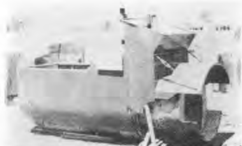
写真-3 機械は左へ動くときに右側に一体のコンクリートパイプを押し出して行く。移動式スリップホームである。
