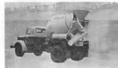
写真-3 傾斜回転胴形トラックミキサ (ドラム開放式) (新潟鉄工製)
