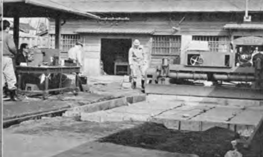
↑コンクリートフィニッシャの性能試験
