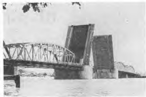
写真-3 クルンテブ橋
