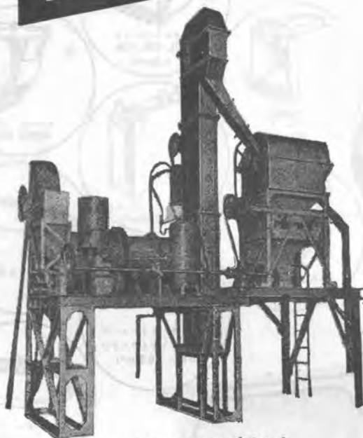
アスファルトプラント
