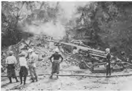
写真-3 左岸エアトラックドリル水平せん孔中 ロッド 6m 空気圧力 6kg/cm 2
