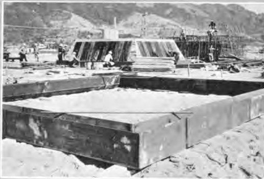
↑ 角型潜函 — 刃口金物据付
