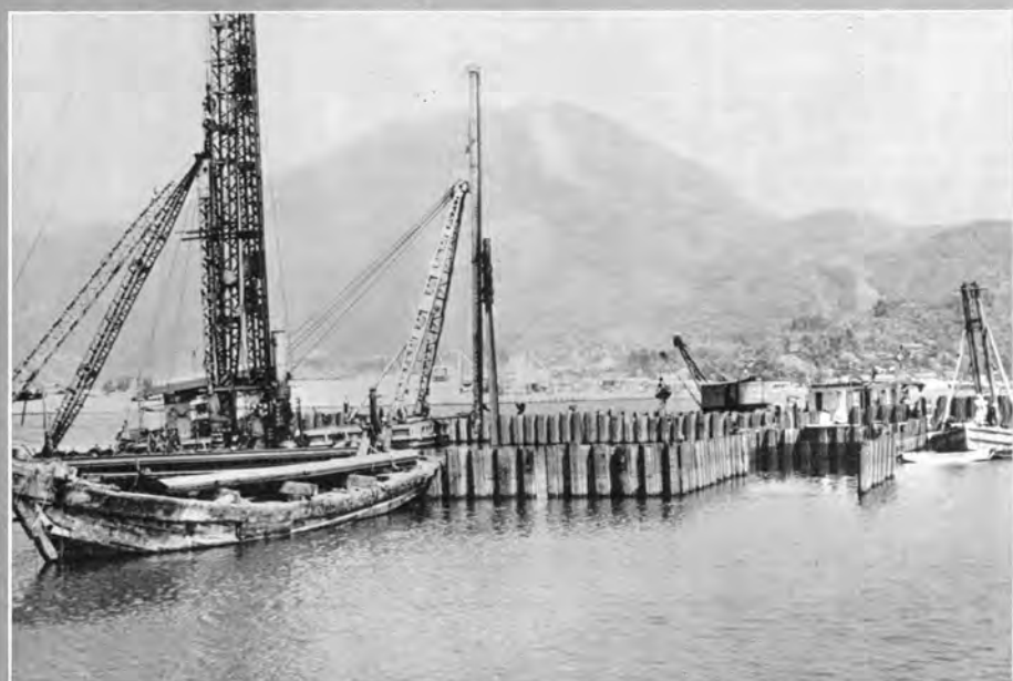
↑ 冷却用水取水口 — 仮締切鋼矢板工 くい打機：テルロック22
