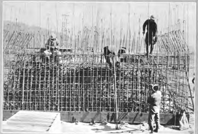
↑ 角型潜函 — 鉄筋組立 (ニ鉄デーコン使用)
