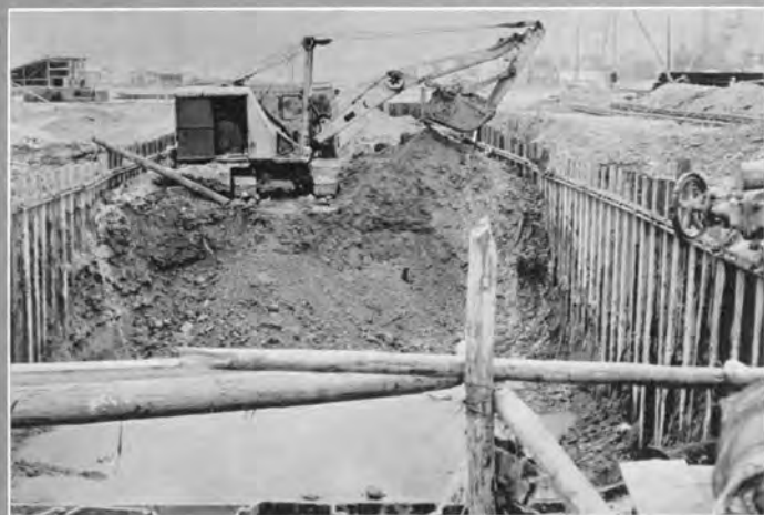
↑ 冷却用放水路 日立 U06 トラクショベルによる掘削および鋼矢板仮締切
