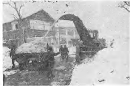
写真-6 TBR の積込状況
