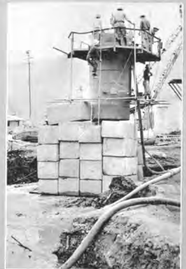
↑ 丸型潜函沈下 — コンクリートブロック荷重載荷状況
