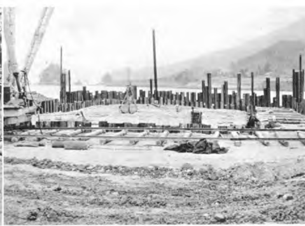
↑ 冷却用水放水口 — 仮締切鋼矢板工 八幡皿型 長さ 10・12m
