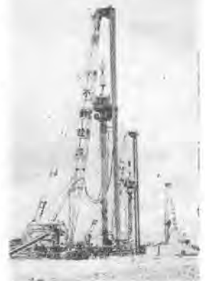
写真-2 パイプロ・コンポーザ
