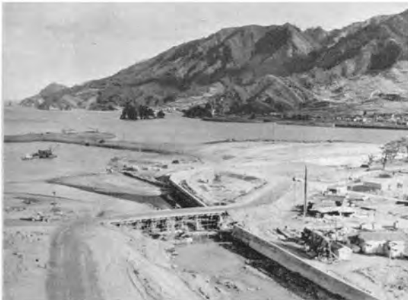
↑ 埋立工事開始直後の状況
