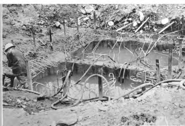
↑ 角型潜函沈下完了状況
