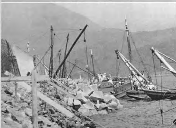
↑ 埋立前面の護岸工事——捨石工、防波堤
