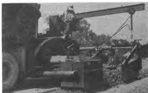
SJ-50ロードワイドナー 本機は附属品の交換によってコンクリート、または加熱されたアスファルトを含むあらゆる合材を用いて道幅を広げたり、側道を舗装する作業を行うものです。
