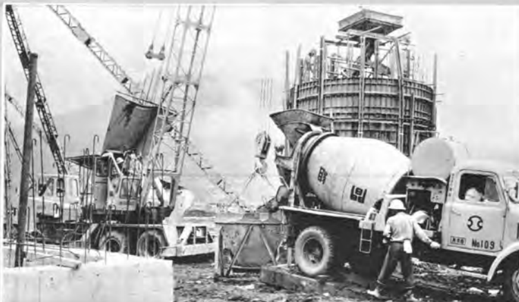
← 潜函躯体のコンクリート打設
