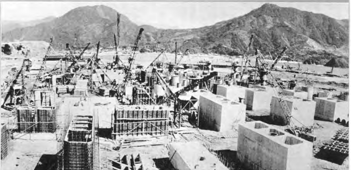
↓ 本館基礎潜函工事全景
