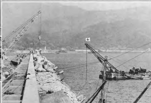
↑ 埋立前面の護岸工——テトラポット (4t) 施工状況
