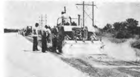
写真-3 Baton Rouge の北部の U.S. 61 号線における施工状況
