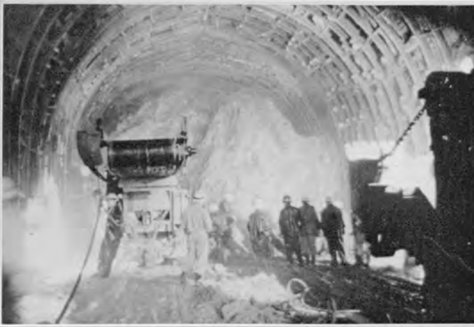
↑ 下部半断面の掘さく作業（コンウェイ2台併列）
