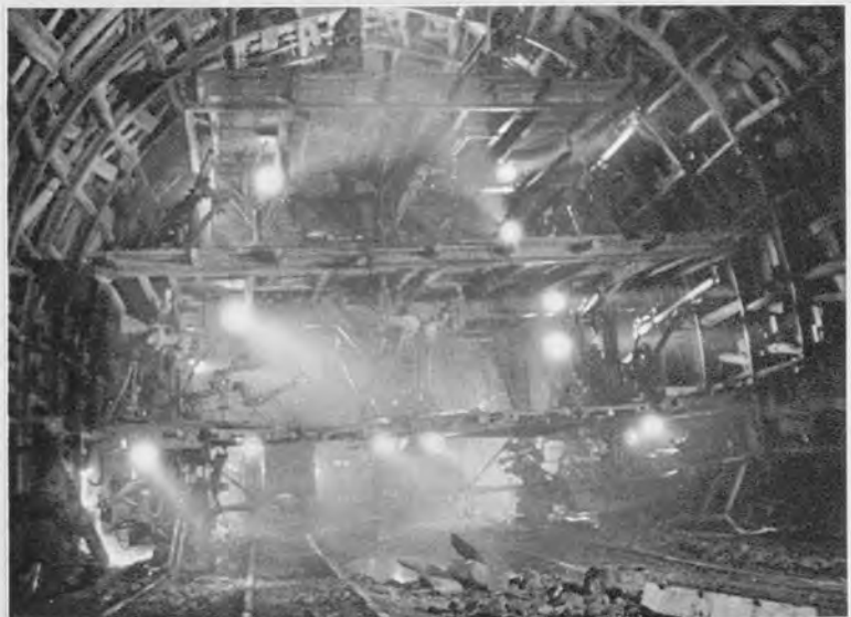
↑全断面掘さく用ドリルジャンボ（21ブーム）
