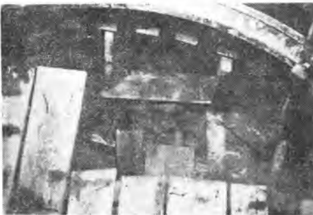
写真-6 切羽の鏡止板および先行矢板 V型支保工, ライナプレート
