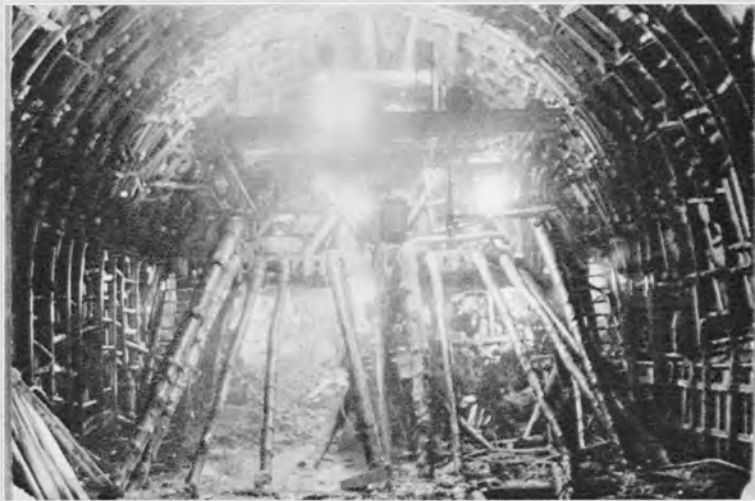
↑切羽押し出しに対する鏡止め補強
