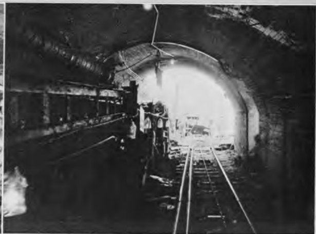
↑第2工区（葉原斜坑）坑口左側にずり出し用ベルトコンベヤが見える。
