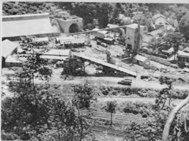
↑第1工区（敦賀口）坑外設備
