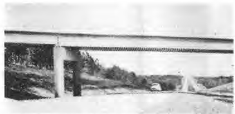
写真-1 Ruston 付近の Interstate 20 の安定処理された路肩
