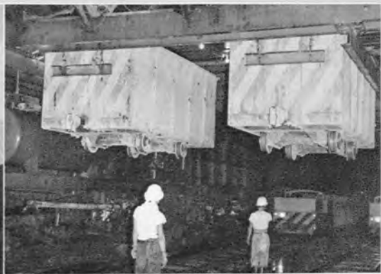
↑ずり車入替 ドリルジャンボ後部にあるチェリーピッカーによって6m 3 トロをつり上げ実車と空車の入替えをする。
