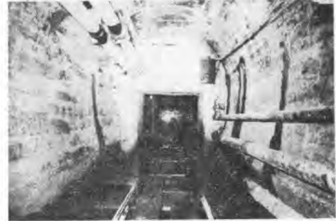
写真-8 気室内部および配管状況
