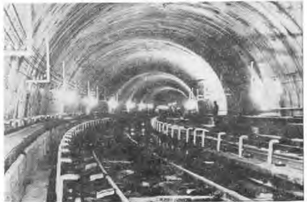
写真-3 レールを敷いたルーフ・シールド工事区間
