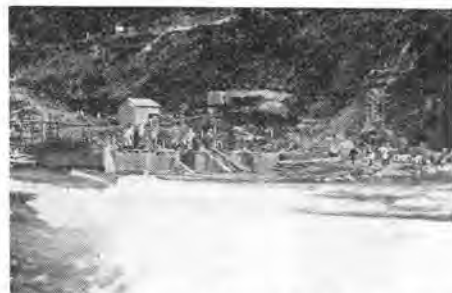
写真-2 上流締切左岸側ボーリング状況(昭和36年3月)
