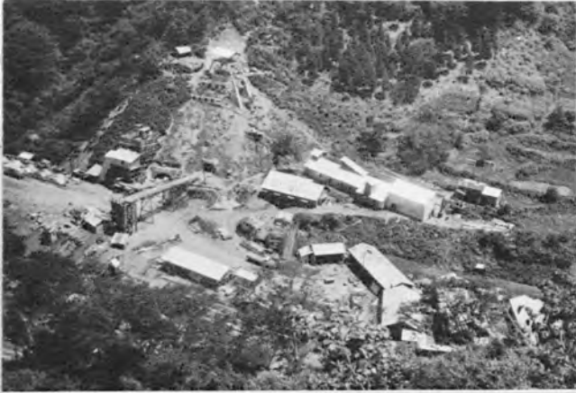
↑第3工区（板取立坑）坑口付近 ずり出し横坑、材料搬入横坑が見える。
