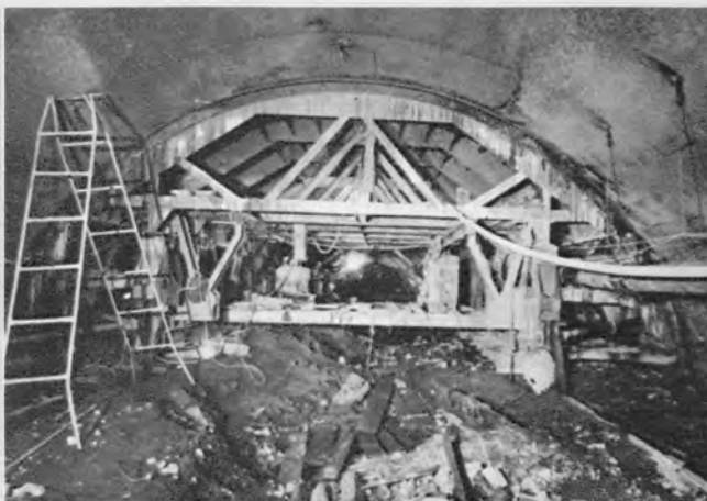
↑半断面用スチールフォーム 工法変更を余儀なくされ半断面工法に移行したところでは、全断面用スチールフォームを改造して上部半断面のみを打設した。
