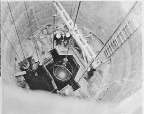
↓掘さく中の板取立坑（深さ230m）キブル降下中 上部ずりピンで放出を終わったキブルが降下する。ライターと称するガイドが随行してキブルの振れ止めの役目をする。
