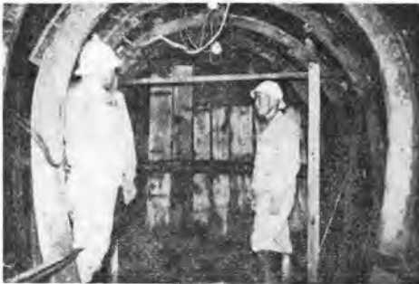
写真-5 ライナプレートおよびV型支保工
