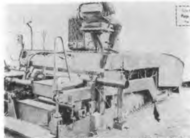
写真-3 SA 40 アスファルトフィニッシャ
