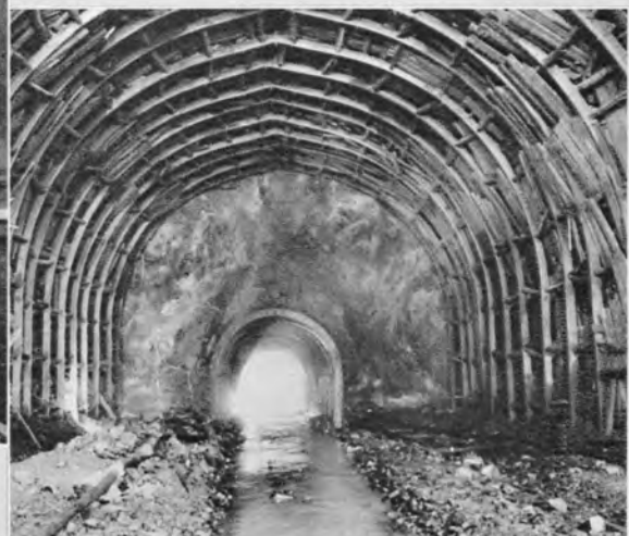
↑プロテクタを使用した底設先進導坑
