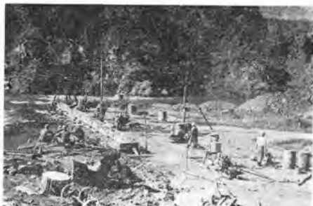
写真-1 上流締切右岸側ボーリング状況(昭和36年3月)
