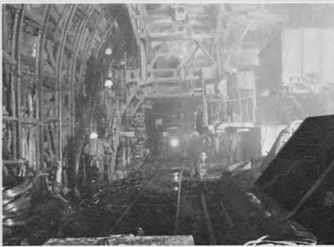
↑ジャンボ背面のチェリーピッカー 右端につり上げたずりトロがみえる。
