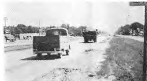
写真-2 安定処理してない路肩の例 (浸食されている)
