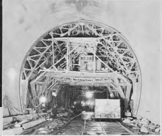
↓ 全断面用スチールフォーム（ノンテレスコーピック型）
