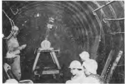
写真-3 ライナプレート組立状況
