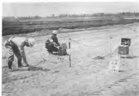
写真-2 D/M ゲージで測定中
