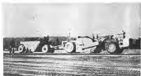
写真-2 容量 70 cu.yd. の土量運搬の実況
