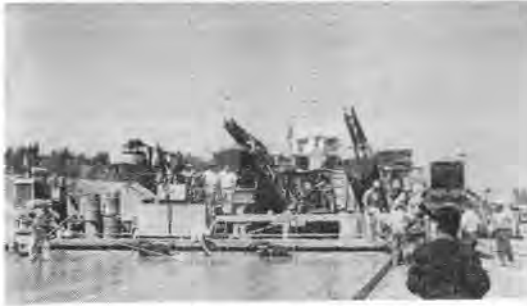
写真-3 コンクリート舗装工事
