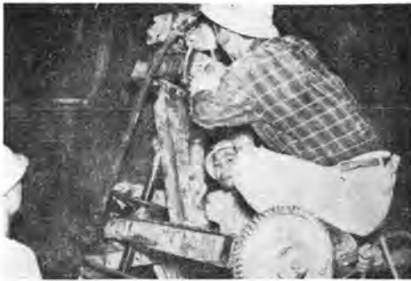
写真-4 先行矢板打込中
