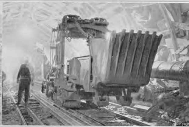
↑大町トンネルは後立山連峰赤沢岳付近の直下1,000mの深さに掘られた長さ5.5kmの輸送路である。トンネル掘削には大規模な全断面工法が採用された。その中の1つコンウェイショベル。
