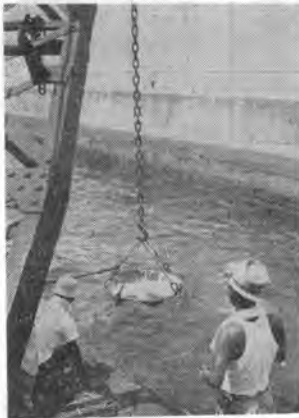
写真-1 (a),(b) バケツトによるグラウティング
