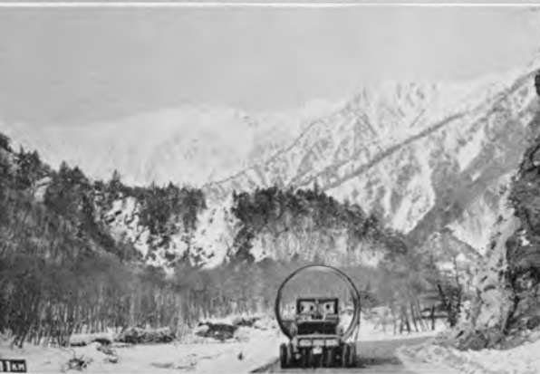
↑長野県大町市から標高3,000m級の後立山連峰の下をくゞってダムに達する大町ルート。このルートをはるばるフランスから輸入された水圧鉄管が低床式トレーラで輸送されている。(昭和35年2月)
