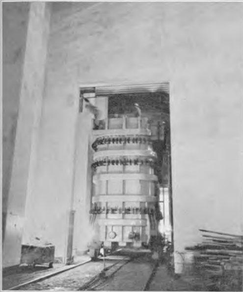
← 巨大な変圧器の搬入状況。容量95,000kVA (昭和35年8月)
