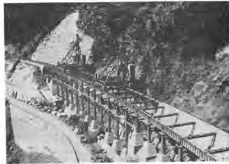
写真-2 ケーブルクレーン走行路と移動塔
