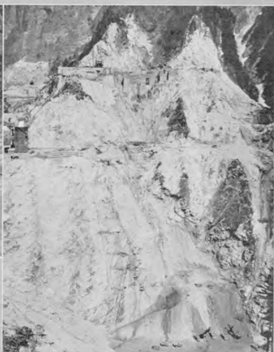
↑ 昭和34年5月頃の右岸掘削状況。ダムサイトの兩岸の表面を、堅い岩盤が出るまで削りとり、ダムコンクリートを打込む。
