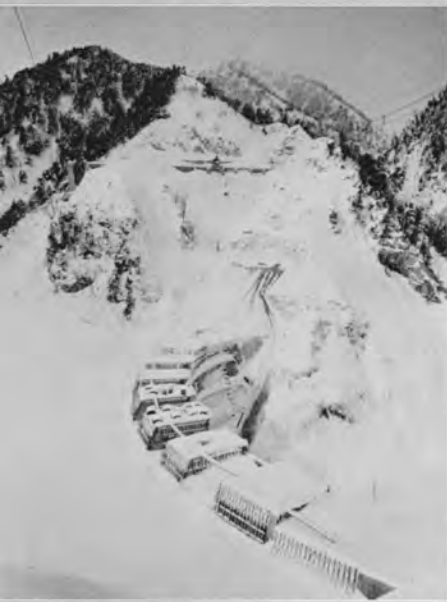
↑黒部峡谷の雪はものすごい。12月～3月の冬期間は積雪のため、全く人がよりつけなくなる。従って地表の工事は1年のうち約半分は休まなければならない。(昭和36年2月頃の状況)
