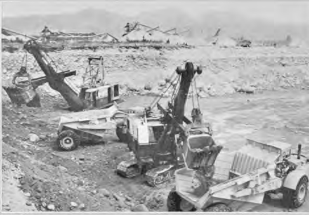
↑大町ルート途中、高瀬川河畔の骨材採取場で稼働するマリオン社のショベル。3回で側の28t積のダンプトレーラーが一杯になる。遠方に見える骨材製造プラントまで輸送する。ダムを作るためには300万t以上の骨材が必要である。 〔昭和35年3月〕
