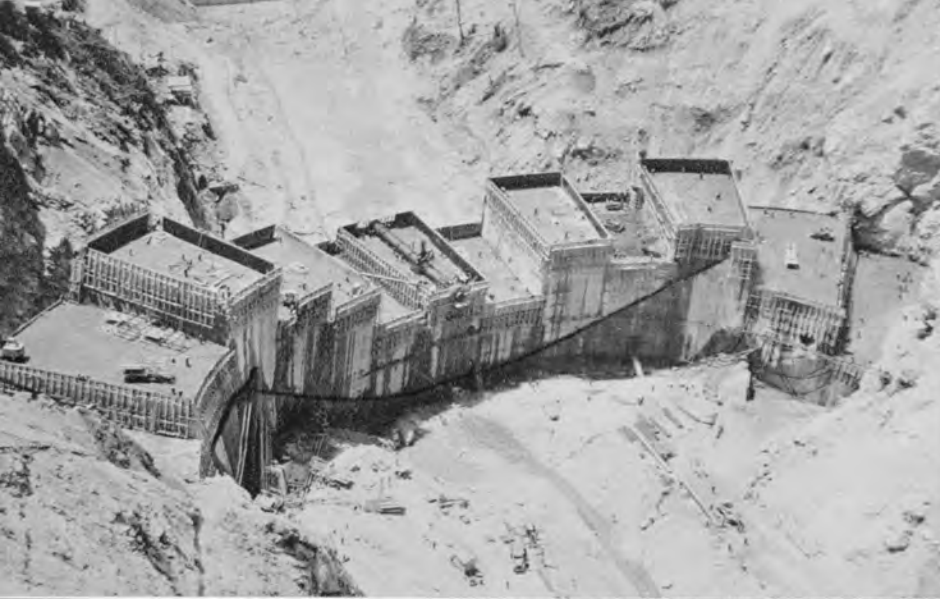
昭和35年5月、ダムは漸く峡谷の中にアーチの形を現わし始めた。中央部の鉄管にはバルブが設けられ将来放水路として働く。
