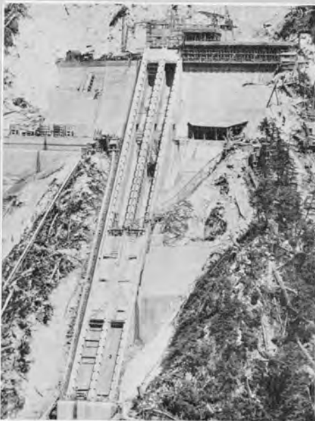
↑貯水池の水を発電所へ送り込む水路トンネルは、ダムの直上流右岸側に長大な斜めの取水口をもっている。下流のかんがい用水に支障ないよう貯水の表面水を取水できる設備をもっている。
