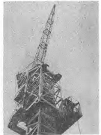
写真-1 ST 125 タワークレーン
