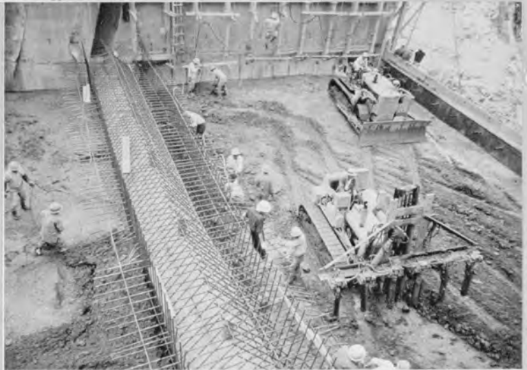
↑ダムのコンクリート打込み状況。 25tハイスピードケーブルクレーンで運ばれて来たコンクリートは打込場におろされ、敷均しのブルドーザで平にされたあと、パイブレータ6本を装備したパイブロドーザによって機械的に締固められる。(昭和36年7月頃)
