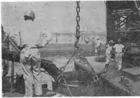
(a) 現場到着のクッカーからバケツトマスチックの流入
