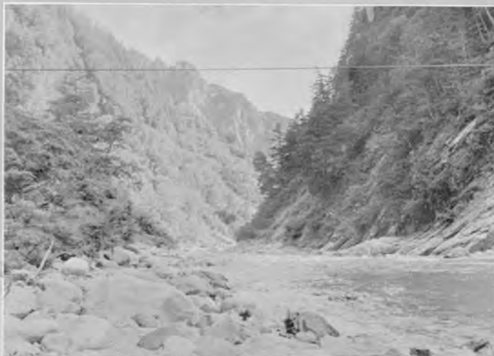
↑ 着工前のダムサイト。兩岸の絶壁は時には 400m にも及ぶ。全く人跡未踏の場所であった。 昭和29年頃
