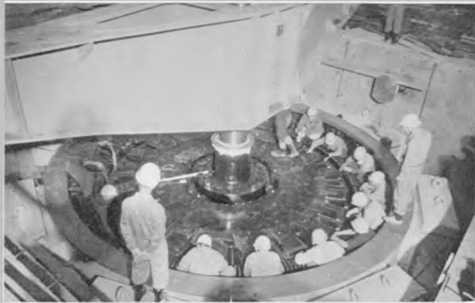
↑第1号発電機のロータの据付状況。 1/1,000mmの誤差も許されない精密な据付工事である。 (昭和35年8月)
