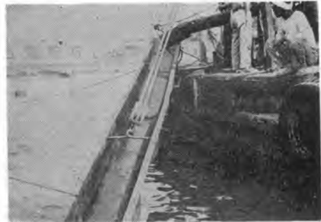
(a) 現場到着のクッカーから直接シュートでマスチックの流し込み
