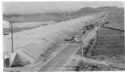
写真-6 完成間近い長岡久我工区
