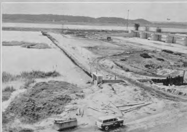
↑工事中の常陸川水門 上部は利根川、中央部は仮締切堤下流部分
