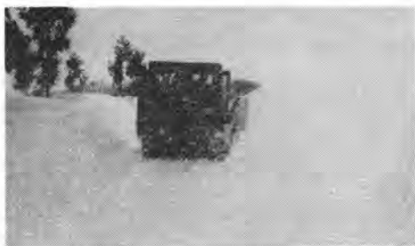
写真-6-① 拡幅除雪状況
