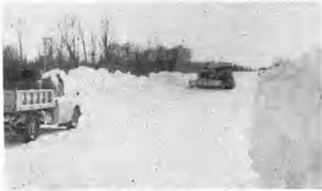
写真-8 ブルドーザによる圧雪拡幅排雪
