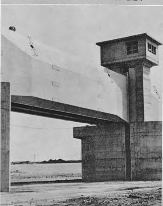
↑水門堰柱およびゲート 水門有効幅 28.5m 高さ 19.85m ゲート重量 115t
