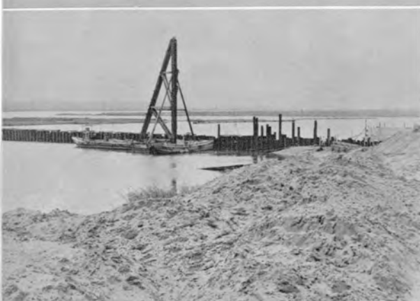
↑仮締切工事 鋼矢板(八幡II型)長さ12m打込中 右側常陸川、左上方利根川本川
