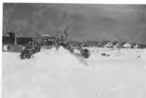
写真-1 タイヤドーザによる掘割排雪
