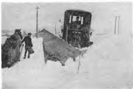
写真-6-② 拡幅除雪状況
