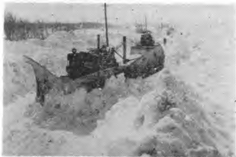
写真-5 ブルドーザによる段切り拡幅排雪
