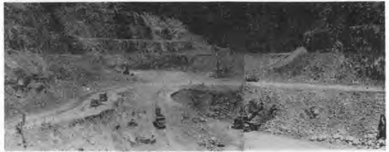
写真-2 原石掘削状況
