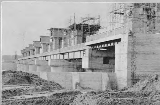
↑水門機械室、型わく建込中
