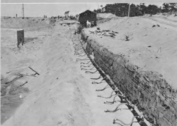
↑左岸上流 ウエルポイント工 → ニューマチックケーソン沈設作業 コンプレッサ 4-7kg/cm 2 5台 スティフレッグクレーン 3台
