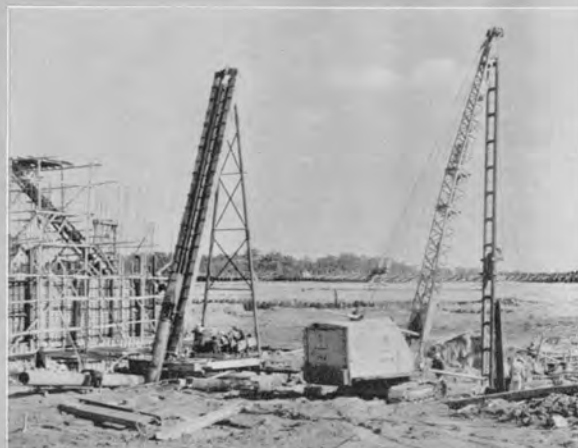
↑堰柱および鉄筋コンクリート 床版打設作業
