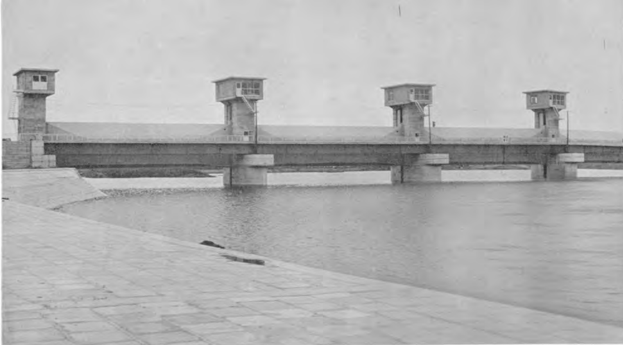
↑完成した水門本体の全景 本水門31.5m 8連、右端は閘門10m
