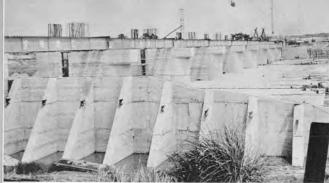
↑完成した下部堰柱および翼壁部分
