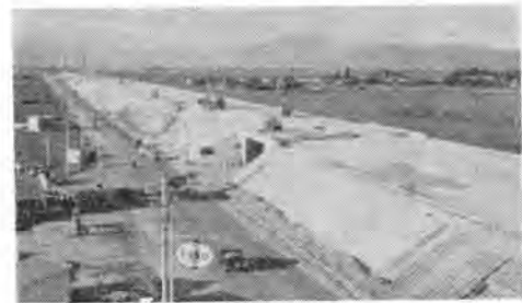
写真-7 完成間近い長岡久我工区
