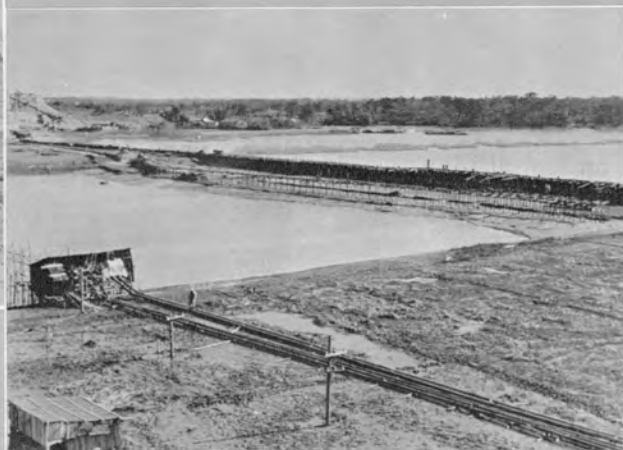
↑仮締切堤内排水作業中 右側上常陸川水門下流部
