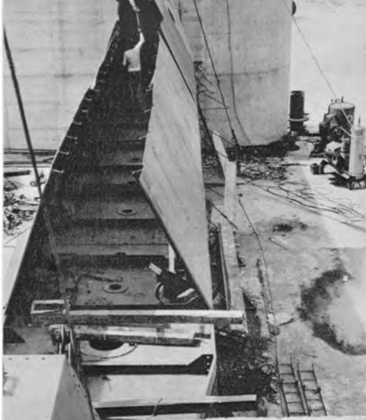
↑水門ゲート据付作業中 上部スキムプレートおよび頂版建込中
