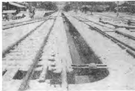
写真-12 流雪溝(長岡操車場内)
