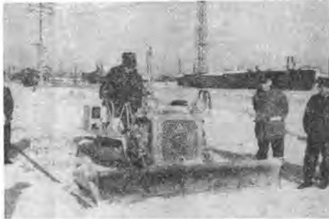
写真-11 鉄道のヤード内の小形ブルドーザ
