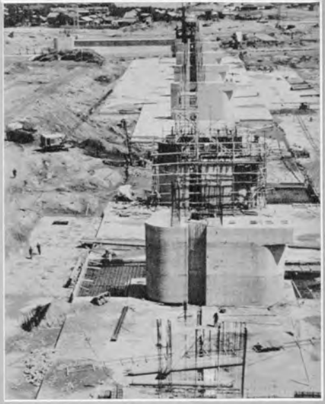
↑堰柱および鉄筋コンクリート 床版打設作業
