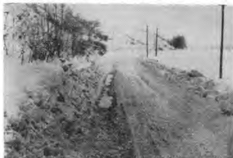
写真—1 除雪された砂利道の状況
