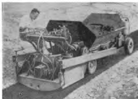
写真-1 舗設作業中のカンターペーバ
