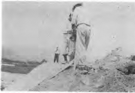
写真-2 ビプロランマによる法面転圧
