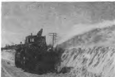
写真-7 三菱 WTR 型ロータリ除雪車による放雪拡幅排雪
