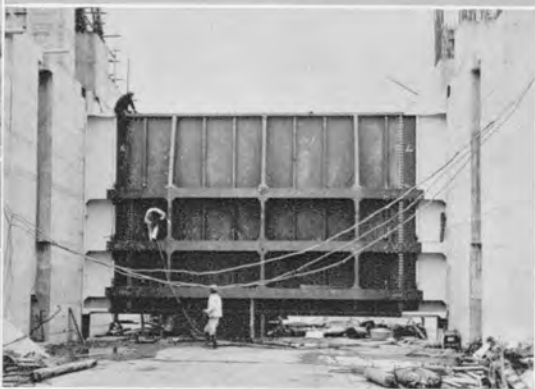
← 開門ゲート 溶接作業
