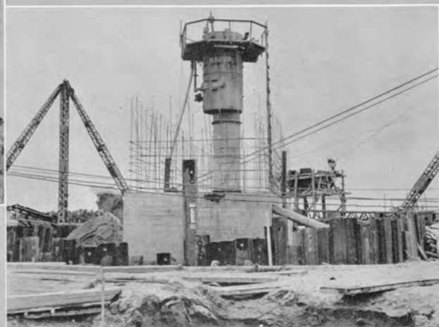
↑左岸上流 ウエルポイント工 → ニューマチックケーソン沈設作業 コンプレッサ 4-7kg/cm 2 5台 スティフレッグクレーン 3台
