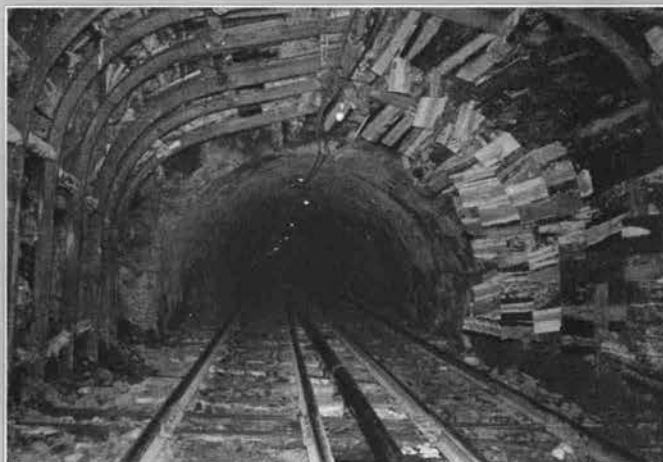
↑ 昭和18年8月頃工事中止の時の導坑コンクリート 来宮方坑口から 370m 付近
