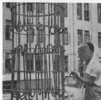
写真-7 鉄筋溶接
