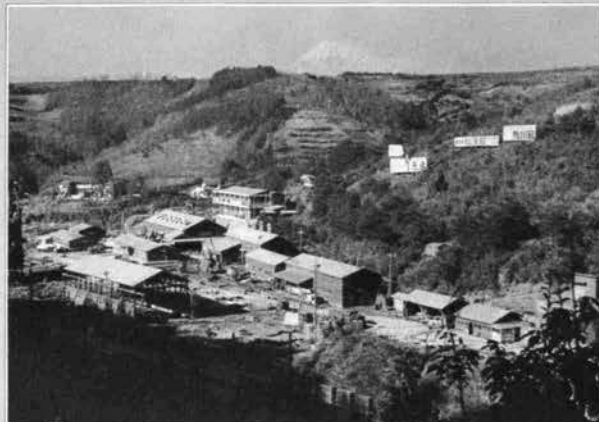
↑ 函南方坑外設備
