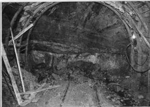
↑ 底設導坑切羽の状況 来宮方坑口から 1.730m 付近
