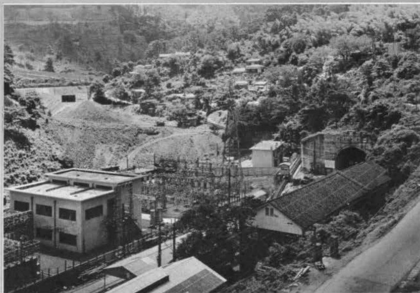
↑ 来宮方坑口 坑門左のブロック2階建の蔭が現丹那トンネルの坑門
