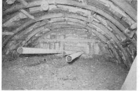
写真-5 143 k 229 m 土留 3本のパイプはボーリングのために切端まで伸してある
