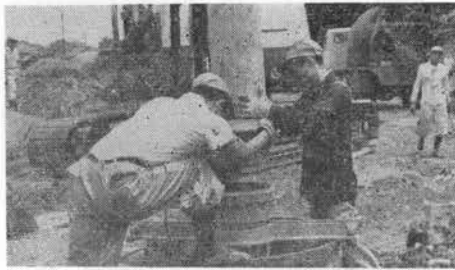
写真-9 トレーミー管つり込
