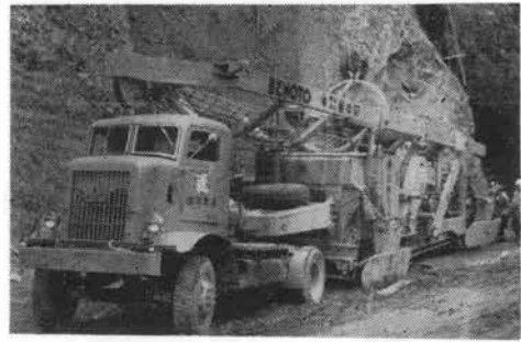
写真-5 トレーラにひからせて対岸に移動中のベント機械
