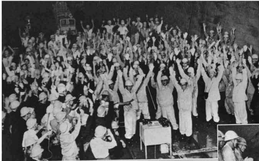
← 爆破貫通歡喜の場面 来宮方坑口から 2.620 m 付近
