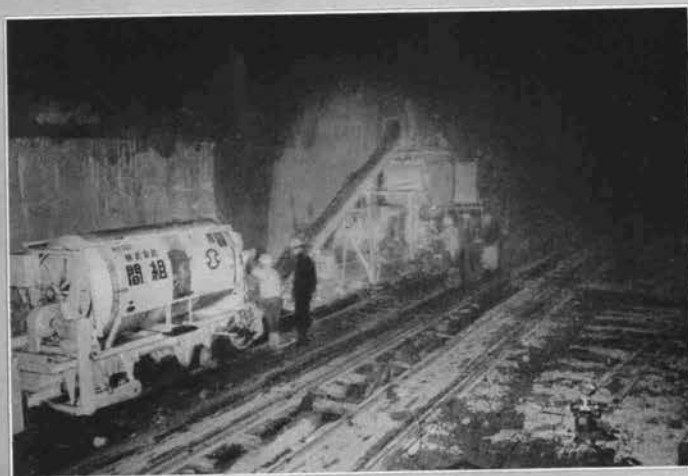
↑ アジテータカー (2.5m 3 ) とコンクリートポンプ
