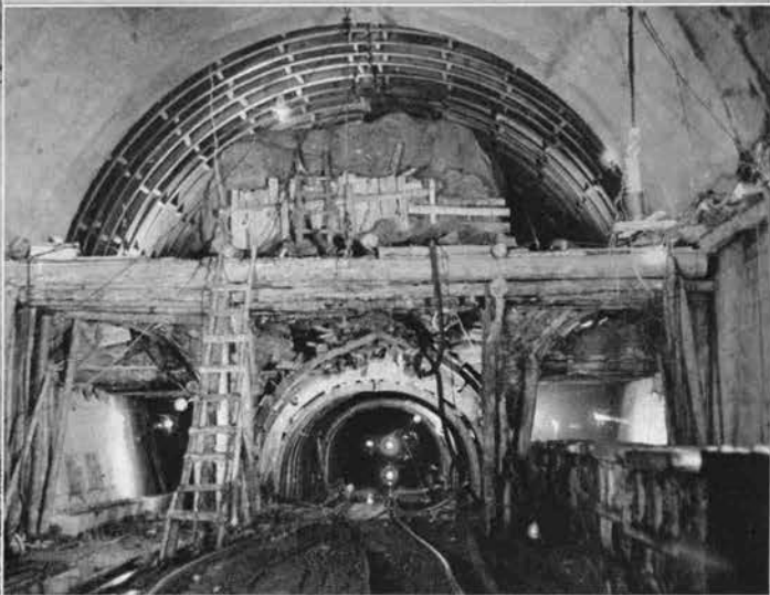
↑ 側壁導坑式掘削 来宮方から 2.600m 付近
