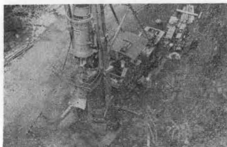
写真-4 左岸側掘削中のベント機械 (左側は現道、右側は作業用に開削した平場)
