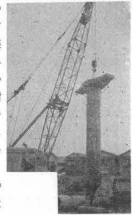
写真-1 ケーシング建込み
