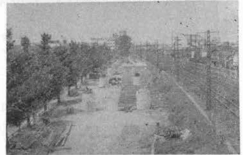
写真-13 橋脚完成
