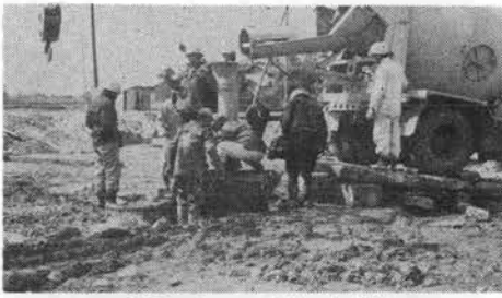
写真-4 コンクリート打設
