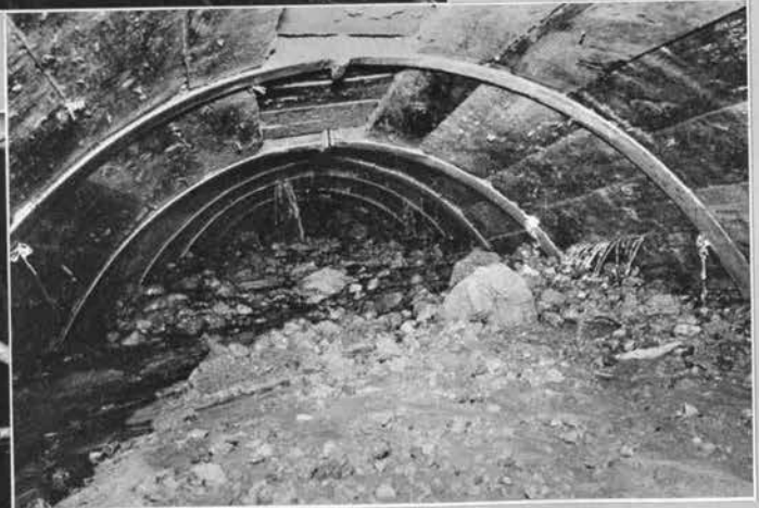
導坑崩壊状況 函南方坑口から ↓ 3.000 m付近
