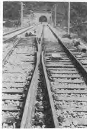
写真-2 ノーズ可動分岐器
