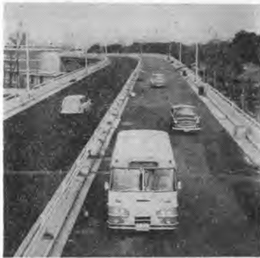
写真-1 完成近い1号線(浜離宮付近)
