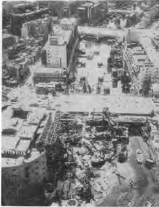
写真一7 高速4号線全面的に実施中の高架橋りようの基礎工事(日本橋付近) 手前昭和通り江戸橋, 上流日本橋
