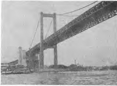
写真-4 完成・使用開始した若戸大橋
