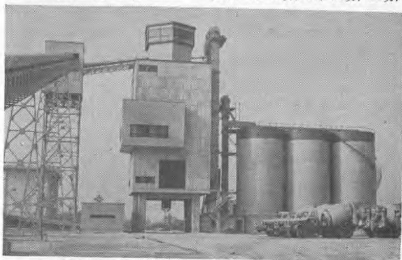
56切~2型 全自動電子管式パッチャープラント
