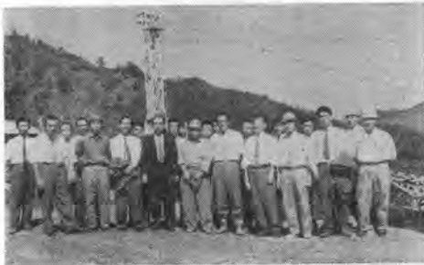
写真-1 4.5 重 ケーブルクレーン固定塔側頂上
