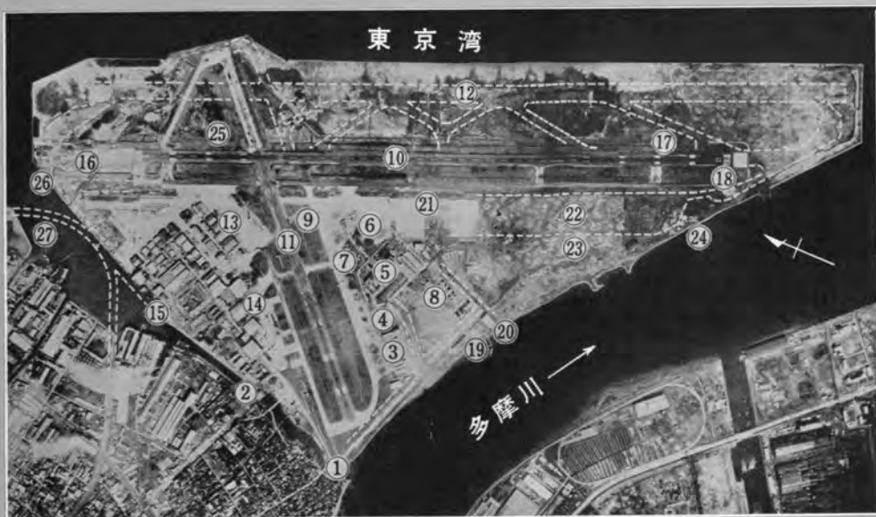
↑ 東京国際空港の拡張工事
