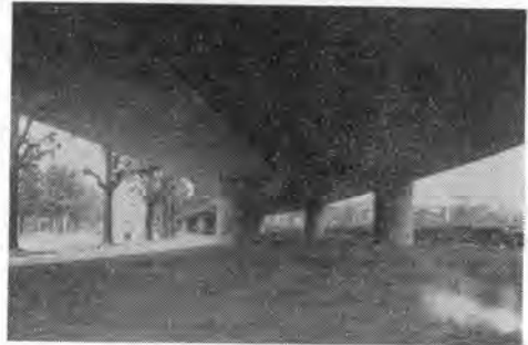
写真一8 高速4号線完成した高架橋(千駄ガ谷付近)
