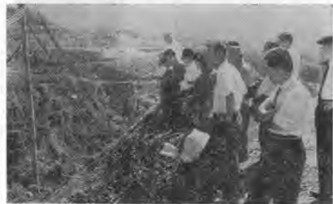
写真-3 ダムサイド
