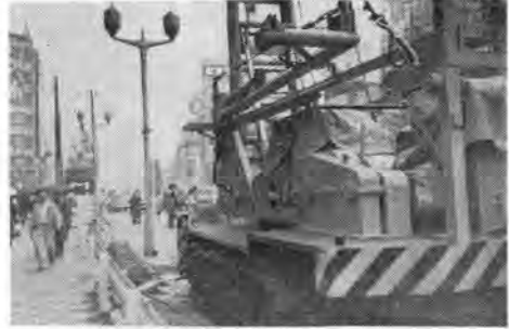
写真—2 昼間待機中のアースドリルマシン
