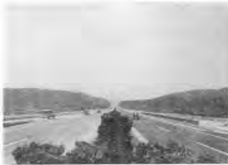
写真-7 完成した名神高速道路山科区間
