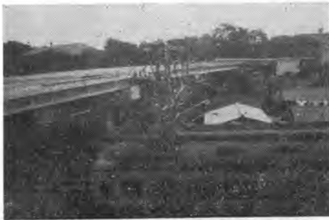
写真-1 環状7号線—西武池袋線との立体交差部
