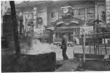
写真—1 歌舞伎座前の工事現場
