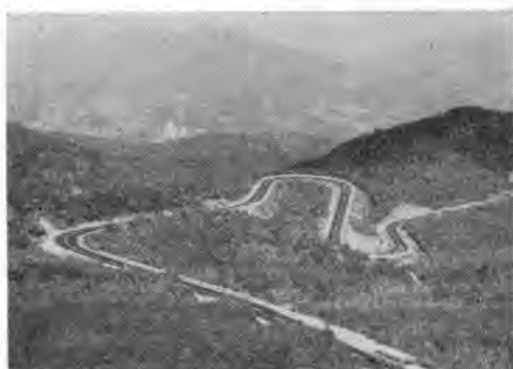
写真-2 開通した伊香保・榛名道路の榛名区間
