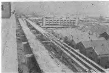
写真-2 完成間近い高速1号線(芝浦ランプから都内を望む)
