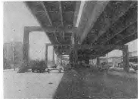
写真-4 高速1号線浜崎橋付近インターチェンジ
