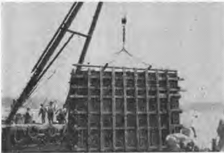
写真-5 ヨット防波堤鋼製型わく据付
