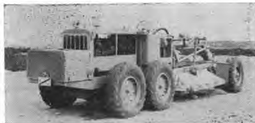
写真-1 ヒーターブレーナ
