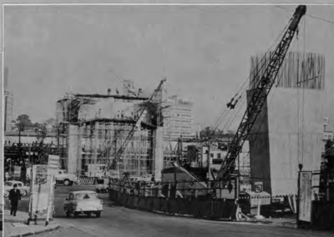
↑ 放射22号線—渋谷駅付近の立体交差工事
