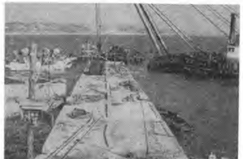
写真-3 防波護岸
