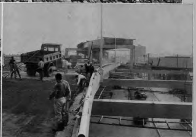
↑ 高速道路1号線インターチェンジ — 浜崎橋付近の路面舗装 —
