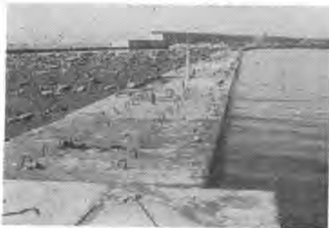
写真-6 3m 岸壁(前方は防波護岸)
