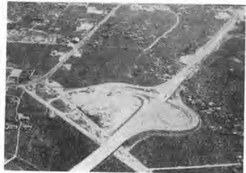
写真-6 工事中の名神高速道路茨木インターチェンジ
