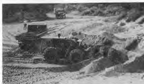
写真-2 125A トラクタショベル
