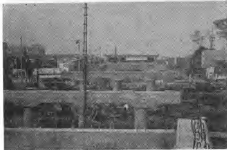
写真-2 環状7号線—青梅街道との立体交差
