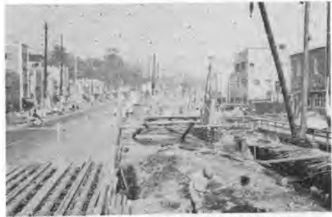
写真-3 放射4号線—大橋付近拡幅工事
