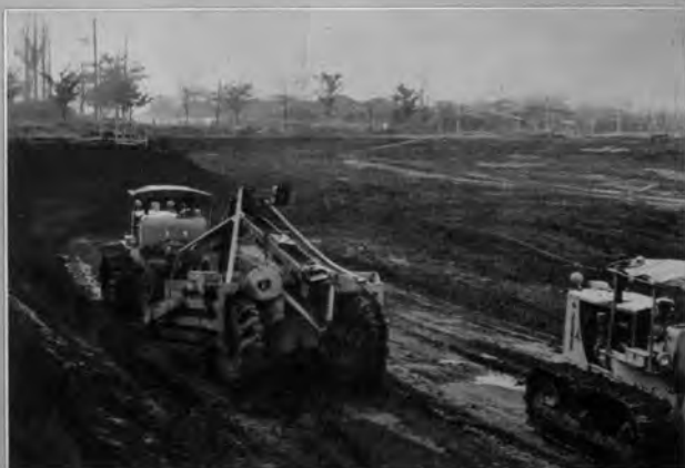
→ 駒沢公園建設整備橋りょう新設貫通道路築造工事
