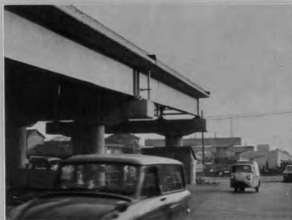
↑ 環状7号線—青梅街道との立体交差工事
