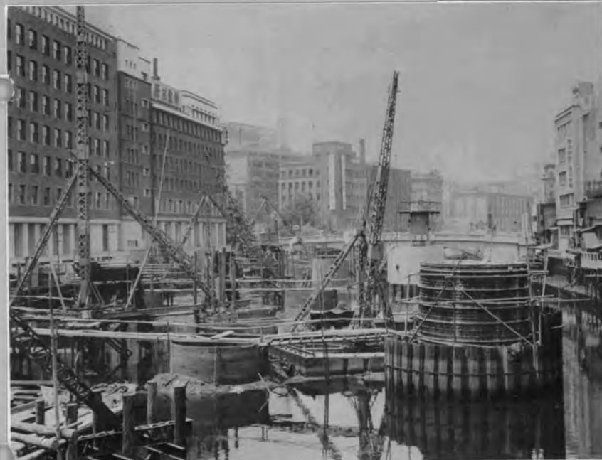
← さかんに工事中の高速道路4号線 — 日本橋付近 —
