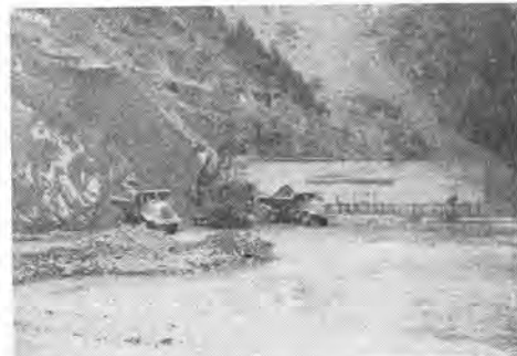
写真-4 ダム掘削 (正面の壁は下流仮縮切) 54 B パワーショベル, 86 ED ダンプトラック
