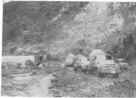
写真-2 1号仮排水トンネル上口（明り工事） 22Bトラッククレーン、トラックミキサ
