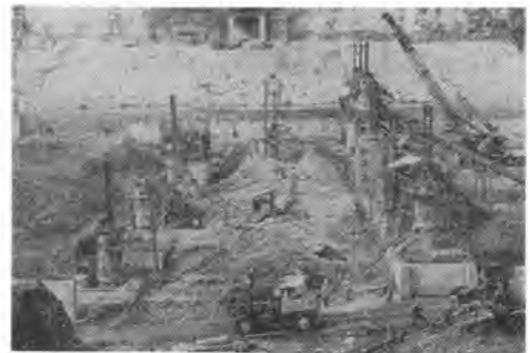
写真-4 ケーン施工状況
