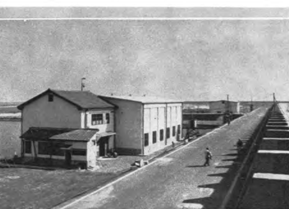
↑排水機場付近 (昭和37年10月)
