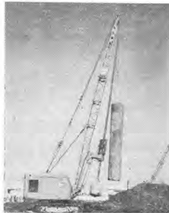
写真-3 クレーン作業
