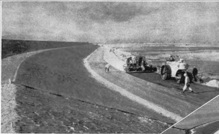
↑海岸堤背面道路（幅8.0m）アスファ ルトコンクリート施工（厚さ5.0 cm）
