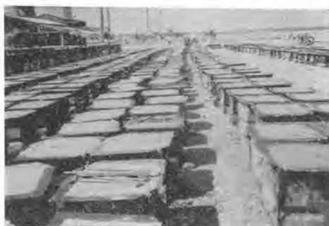
写真-6 流しこみ式コンクリートブロック養生中
