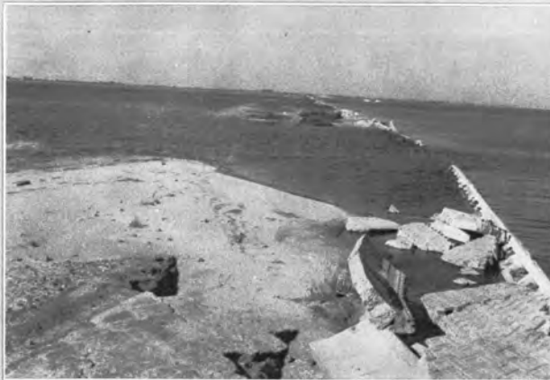
↑ 伊勢湾台風による海岸堤被災状況
