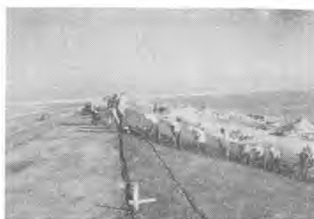
写真-2 法面サンドアスファルト人力舗設
