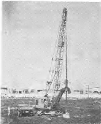
写真-1 掘削状況
