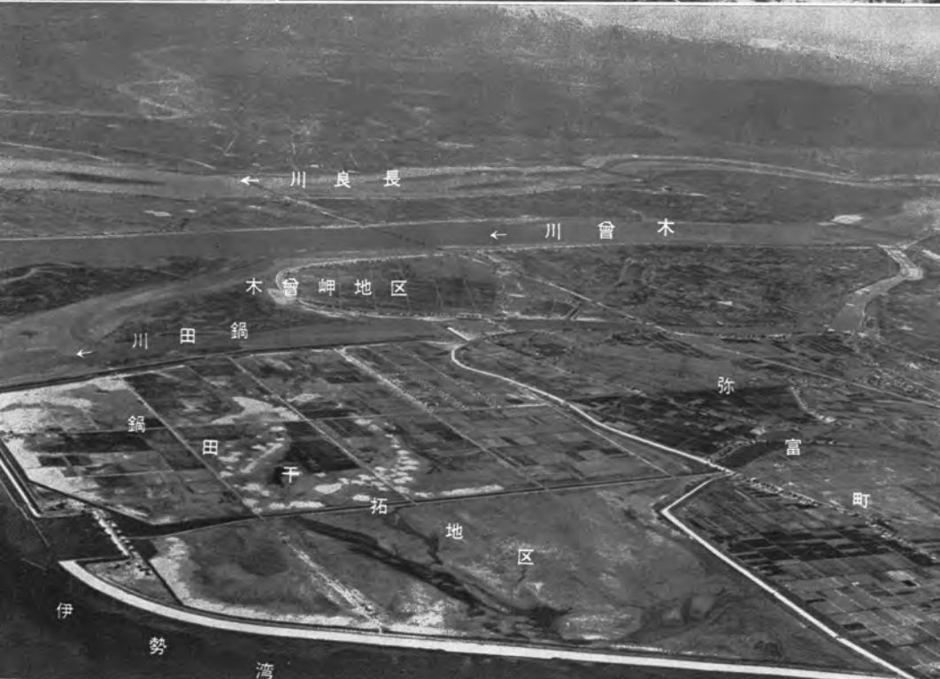
← 完成した鍋田干拓災害復旧工事地区の全景
