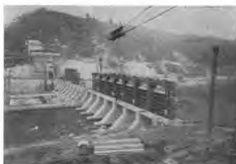
写真-1 最近のダム施工状況
