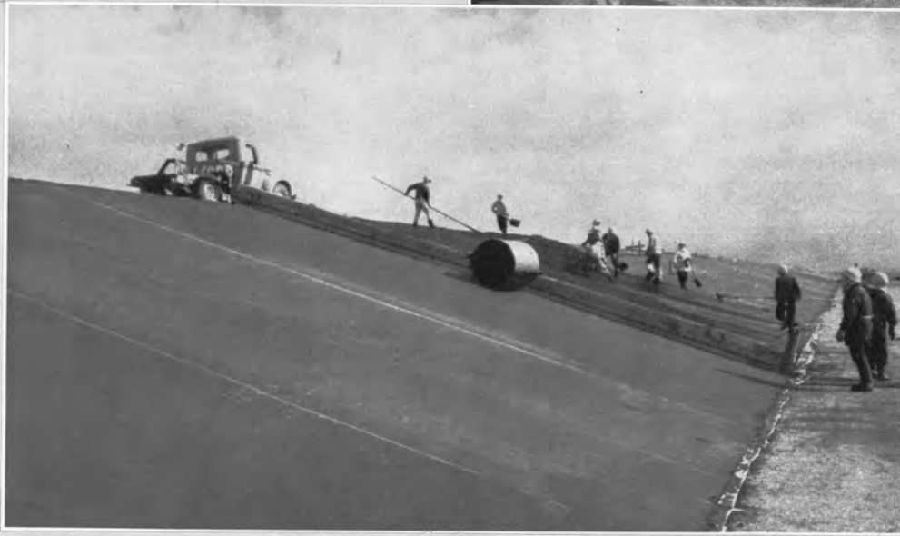
← 法面細粒式ア スファルトコ ンクリートを フラットロー ラ (800kg)に より転圧
