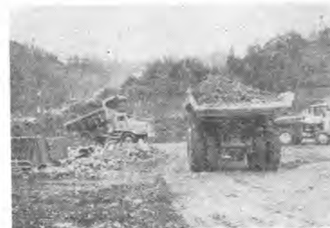
写真-5 捨土状況 (将来モータープール予定地) 86 FD ダンプトラック, ユークリッドダンプター
