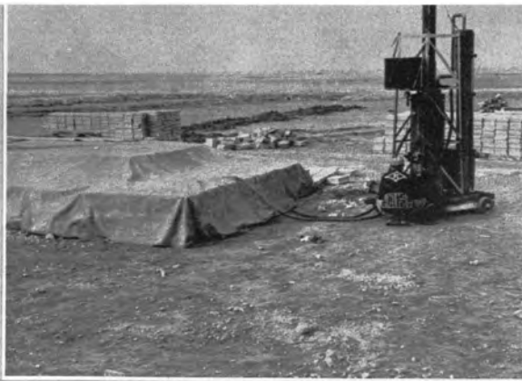
↑コンクリートブロック 蒸気養生中
