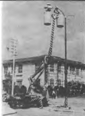
街路灯工事に活躍する コーリツ・スカイワーカー
