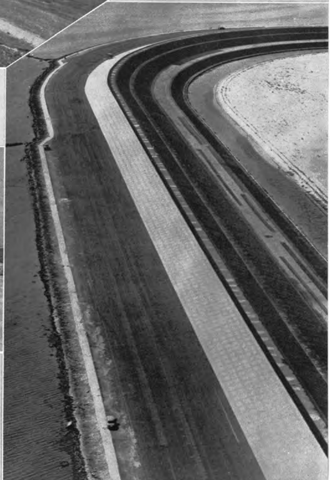
→ 海岸堤（船溜西）完成 （昭和37年10月）
