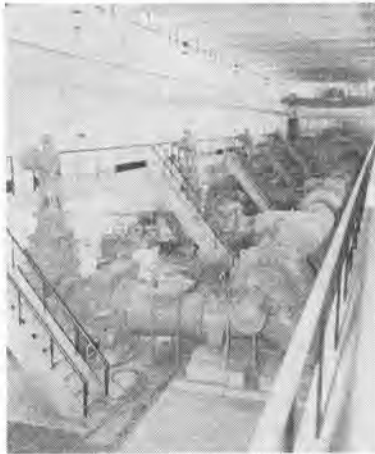
写真-1 配水ポンプ場全景
