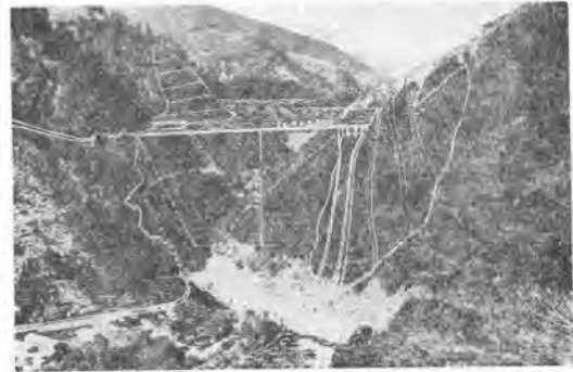
写真-1 ダムサイト地点 (下流より)
