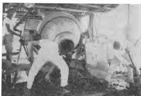
写真-5 コンクリートミキサによるコンクリート練り
