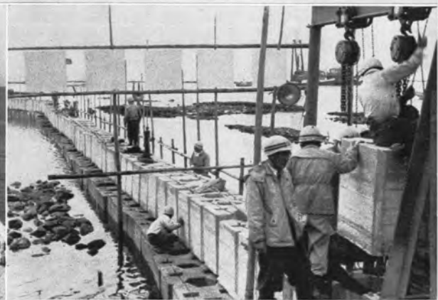
↑ 第1潮止め完了 (延長145.0m)
