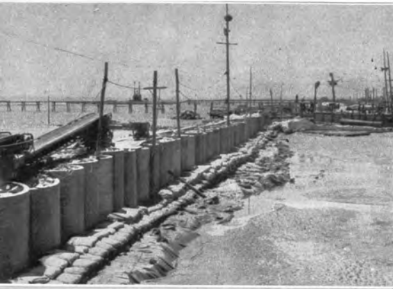
↑第2潮止め完了 (延長60.0m) 内径1.00mヒューム管
