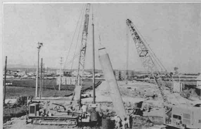
↑尼崎高架のアースドリルに よる長さ10~12m、径1m の場所打ちコンクリートく い工事 (昭和36年10月)
