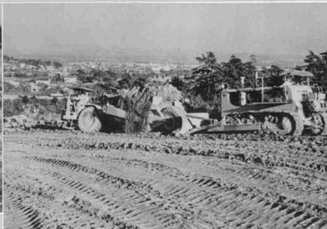
↑高槻地区の11m 3 積みモータスクレーバ作業 (昭和36年8月)
