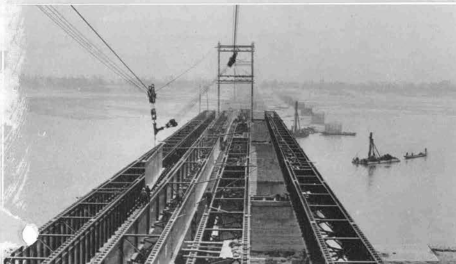
↑ 尼崎高架の中空床版用の 径60cm 円筒型わく (昭和37年5月)
