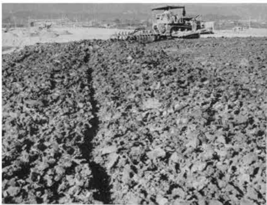
↑ 茨木地区のディスクハローによる含水比の調整作業 (昭和36年9月)
