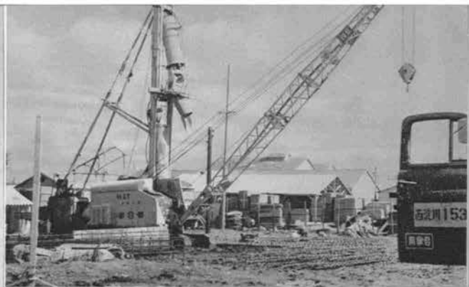
↑尼崎高架のベントによる長さ10~12m、径1m の場所打ちコンクリートくい工事 (昭和36年9月)
