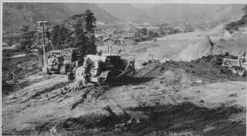
↑ 32t級のブルドーザに装着したリッパによる米原山東地区の軟岩岩破碎作業 (昭和37年7月)
