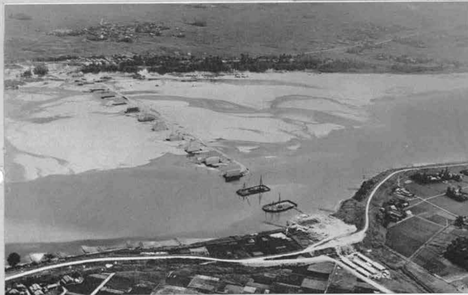
↑瀬田川橋の深さ25mのケーソン式下部 工事 (昭和34年9月)
