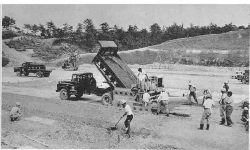
→ 栗東地区のアグリゲート スプレッドによるベース コース材料の敷均し作業 (昭和37年9月)
