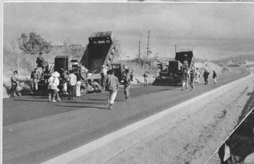
→ 高槻地区の中央分離帯用場所打ちコンク リート緑石機の作業中 (昭和37年11月)
