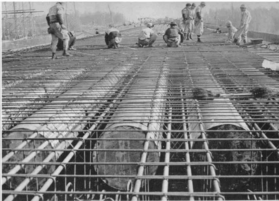
↑ 尼崎高架の中空床版用の 径60cm 円筒型わく (昭和37年5月)
