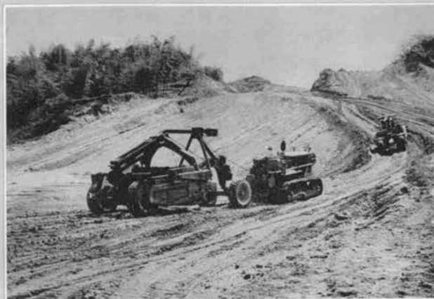
↑名神高速道路の第1号土工工事として着手された山科地区の9m 3 積みキャリオールスクレーバ作業 (昭和34年7月)
