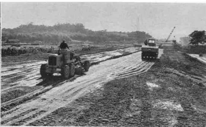
↑ 吹田地区の25tタイヤローラ、グレーダによる盛土締め作業 (昭和37年4月)
