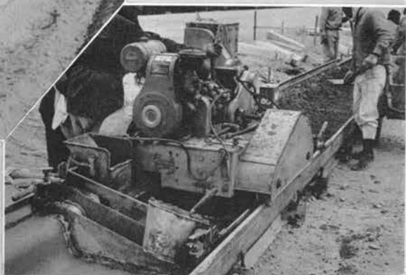
→ 高槻地区の中央分離帯用場所打ちコンク リート緑石機の作業中 (昭和37年11月)
