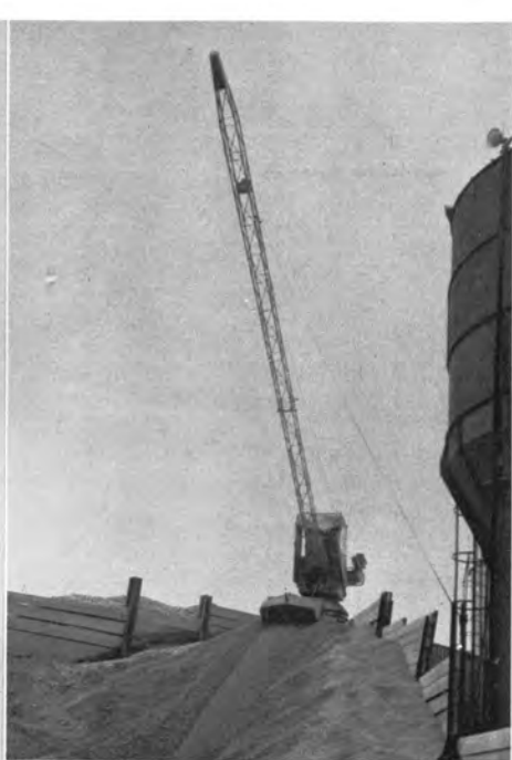
↑ライン河発電所建設現場における コンクリートプラントの骨材かき 寄せ装置 (フランス電力)
