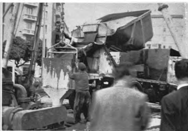
↑I.C.O.S. 工法—コンクリート運搬車 (イタリア)
