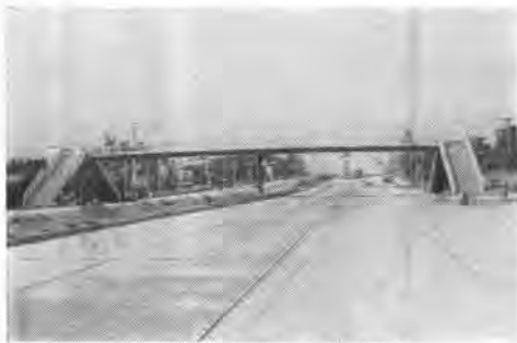
写真-5 跨道橋 (芦屋市門)
