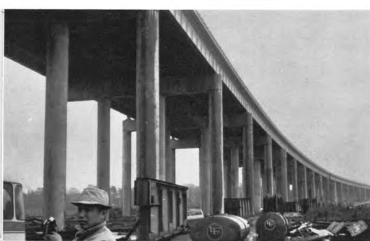
↑マンチェスタからロンドンに向うM-6 高速道路建設工事
