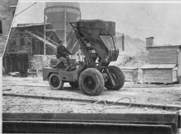
→ ライン河発電所建設現場の コンクリート運搬車
