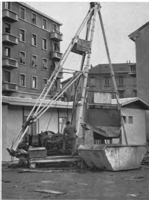
↑イタリア：ミラノ市地下鉄の I.C.O.S. 工法現場
