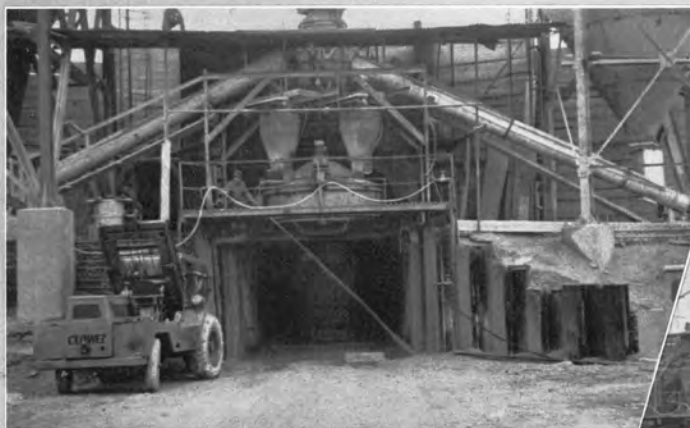
↑水平型タービンミキサを用いたプラント (フランス電力)
