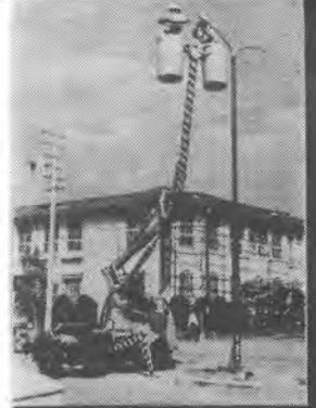
街路灯工事に活躍する コーリツ・スカイワーカー
