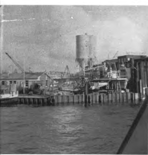
↑アムステルダム港湾における護岸工事
