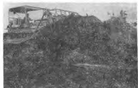
写真-3 レーキドーザによるかん木地帯の抜排根
