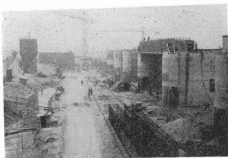
写真—4 フランス：マルコシャム発電所工事
