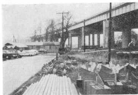
写真—7 イギリス：M-6 道路工事
