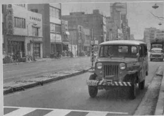
↑パトロールカーは毎日受持区間を巡回して、道路表面、 クレーン上 街渠柵、歩道、ガードレール、街灯、街路樹等の状態を点検し、異常の場合は無線電話で出張所に連絡する。
