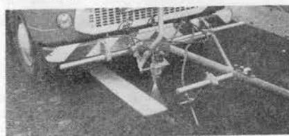
写真-3 ロードマーカで塗装中
