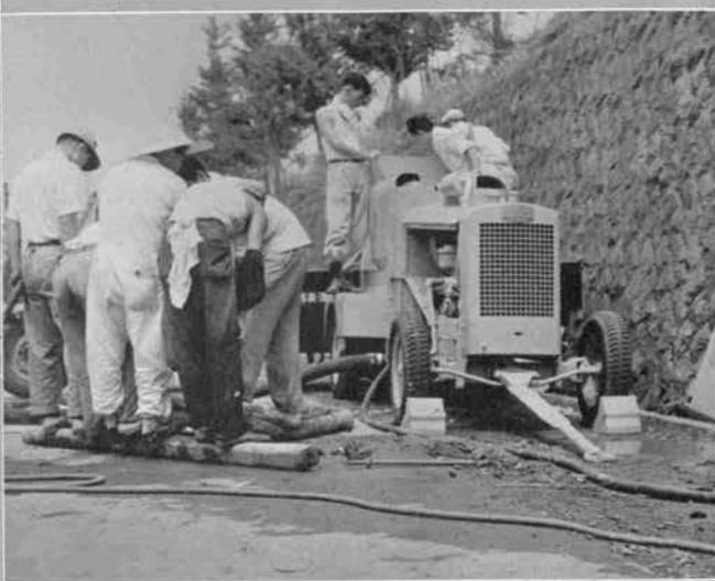
↑舗装版と路盤の間に生じた空げきに充てん材を圧入し、舗装版の沈下、亀裂を防ぐマッドジャック
