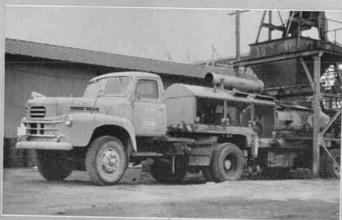
↑グースアスファルトは施工性と耐摩耗性に注目されて近年脚光をあびている。プラントから合材を受けているアスファルトクッカー
