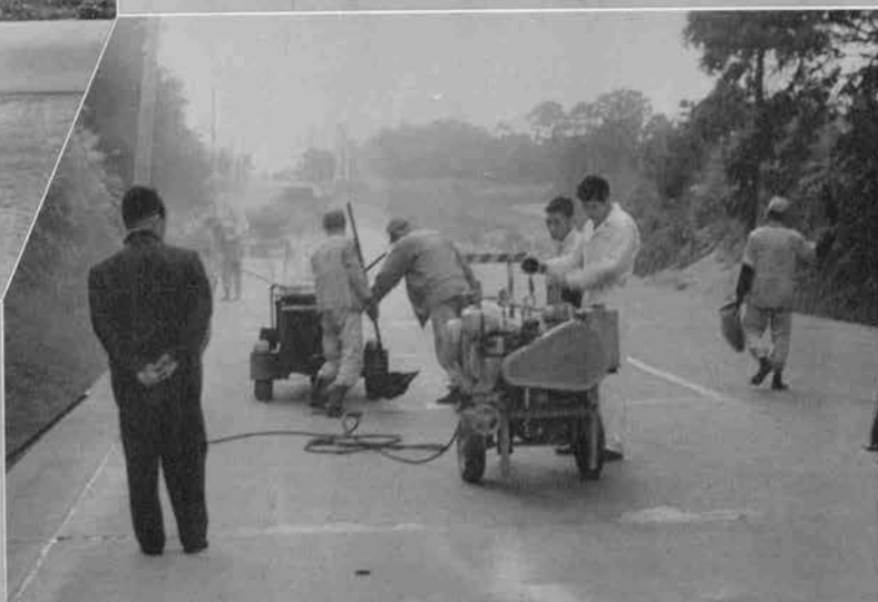
↑コンクリート舗装道路の注入目地の入替え作業には、シール材溶解機およびジョイントシーラーが使用される。
