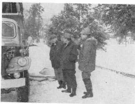
長岡市関原町 まわり道鉄板道路視察
