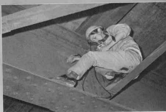
↑橋りょうの板圧測定
