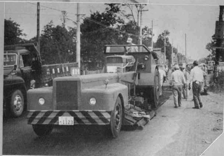
アスファルト舗装道路表面に発生した凹凸の修正に威力を発揮するヒータープレーナ
