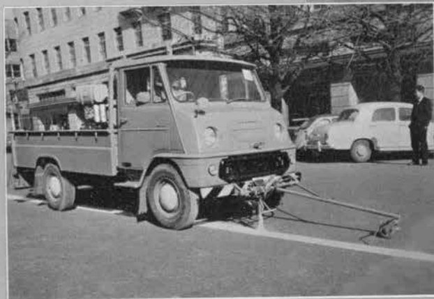
← 区画線塗布作業中の車載式ラインマーカー
