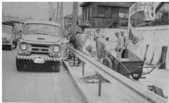
歩道の平板、縁石の修理に作業員や機材を輸送する小形作業車
