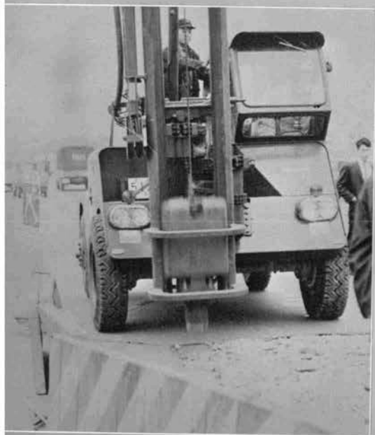
↑破損著しい舗装版は打替えを行なう。破砕作業に威力を発揮するコンクリート破砕機
