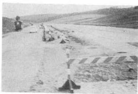
写真-1 ドイツ：アウトバーン工事の一風景
