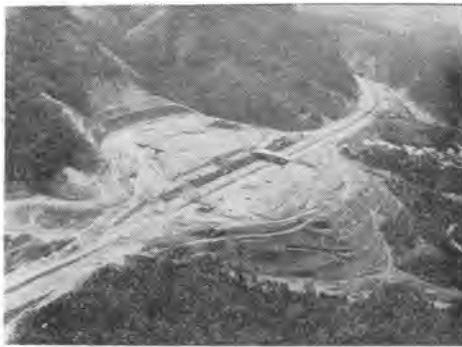
写真-1 建設中の名神高速道路大津インターチェンジ兼サービスエリア
