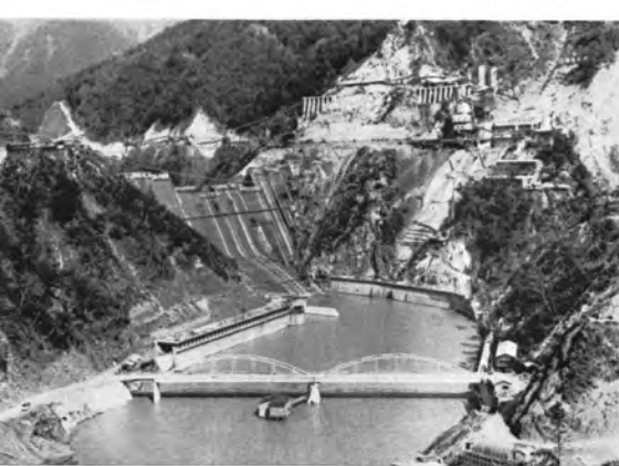
↑昭和36年10月 下流側から見たダム全体の全ぼう。
