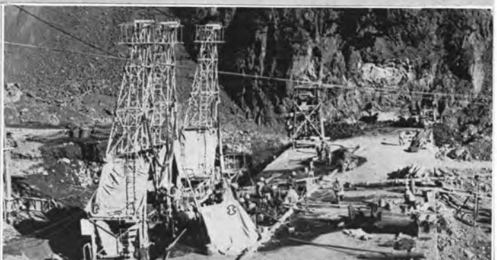
昭和34年12月 上流1次仮締め切りにてICOS工法を採用した。
