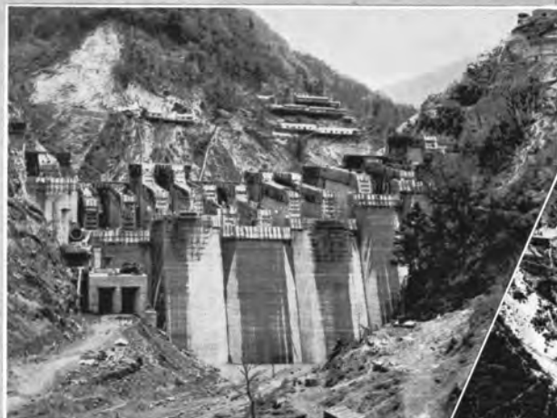
↑昭和36年4月 上流側から見たダム。左岸寄りの鉄管は放水管。
