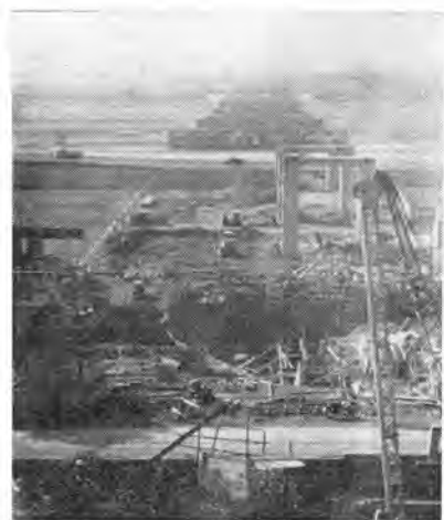
写真-3 第3京浜道路東京側から完成した多摩川橋下工を望む(手前は工事中的の玉川高架)
