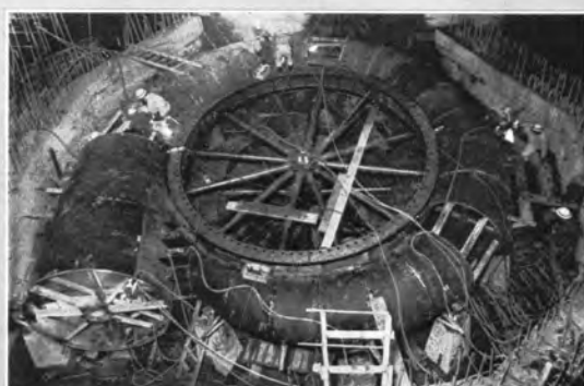
↑昭和36年7月 第1号水車ケーシング据付開始。
