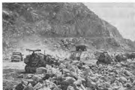
写真-2 トラクスカベータの現場稼働状況
