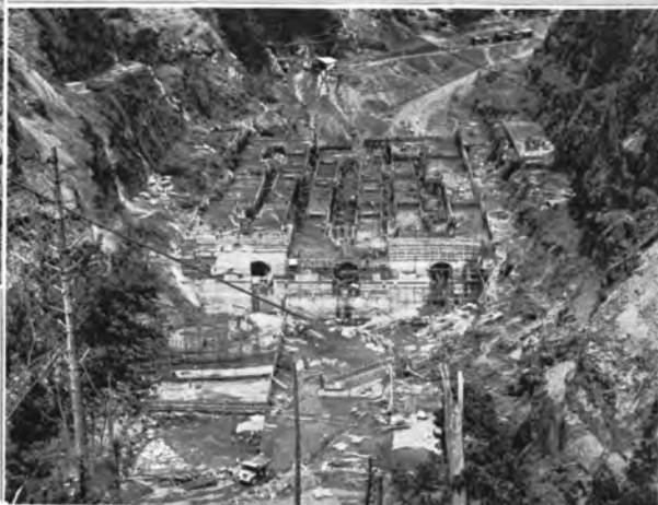
↑ダムコンクリートの打設は、昭和35年3月開始され、昭和35年6月にはダムホローの形が現われてきた。
