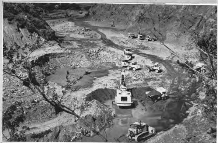
↑昭和34年10月下旬 第1次バイパスに通水し河床部掘削が本格的に開始された。
