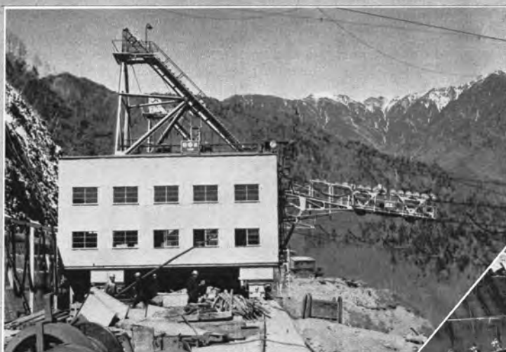
↑昭和35年2月 11t両端可動ケーブルクレーン 組立完了。
