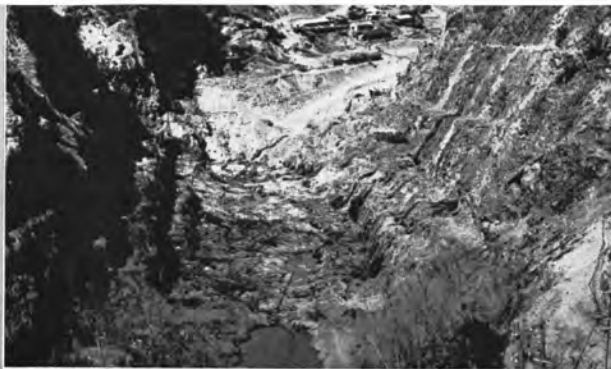
↑昭和35年2月 ダム河床部の岩壁がその全ぼうを現わした。
