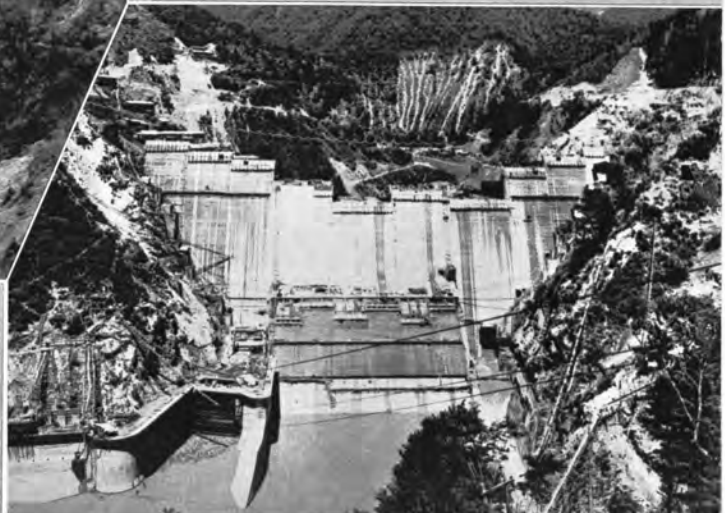
→ 昭和36年7月 発電所屋根、越流路兼用「が完了し、一部たん水を実施した。
