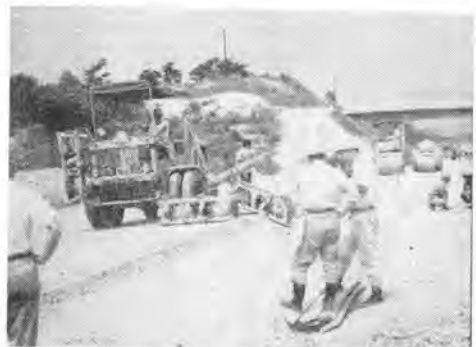
写真-2 名神高速道路舗装工事を実施中
