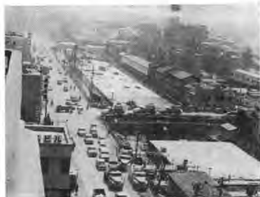
写真一4 建設中の大阪長堀駐車場
