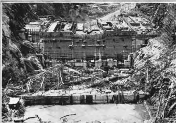
↑昭和35年7月 発電所のドラフトチューブ据付開始。
