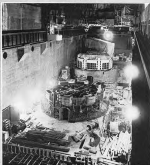
↑昭和37年1月 発電所内部の機器 据付状況。
