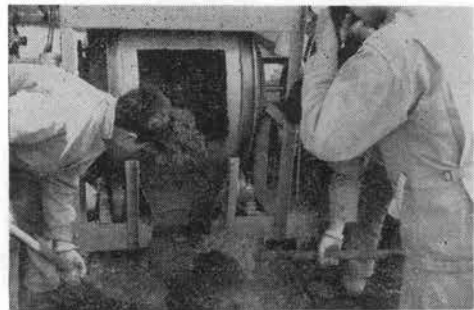
写真-25 胴から排出され始めた粗骨材の散布状況
