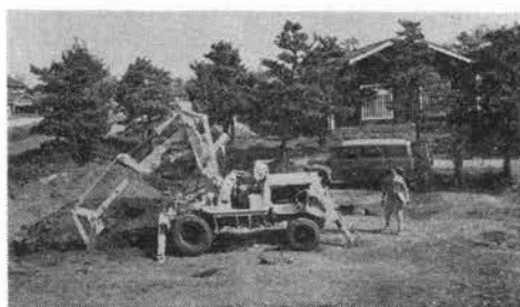
写真-6 スイングショベルローダの作業中の 油圧測定
