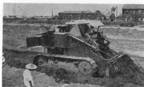
写真-7 スクレープドーザの主ドーザによる 排土作業試験
