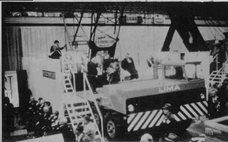
→ 大形のトラッククレーン(Baldwin-Lima-Hamilton; 500T形) ブーム長さ 64m、つり上げ荷重 50t キャリヤは8×4を使用している。
