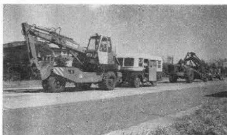
写真-3 油圧掘削機のけん引試験
