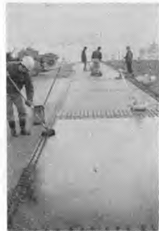
写真-2 タールラバーペイント塗布
