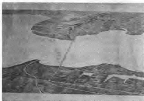
写真-2 上空よりみた琵琶湖大橋全量
