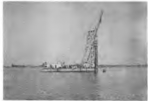
写真-3 くい打船全景
