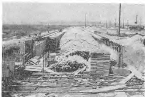
写真-2 川崎製鉄所1万トン用岸壁工事現場
