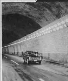
↓ 片開き地下道橋の全貌 (関西大学前) 学校を騒音から守るために、この構造物は設計されたが、音響に関する多くの実験研究が行なわれた。
