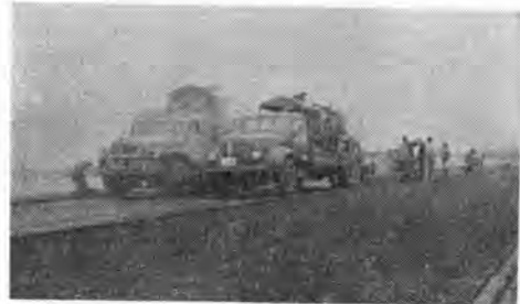
写真-3 舗設全景
