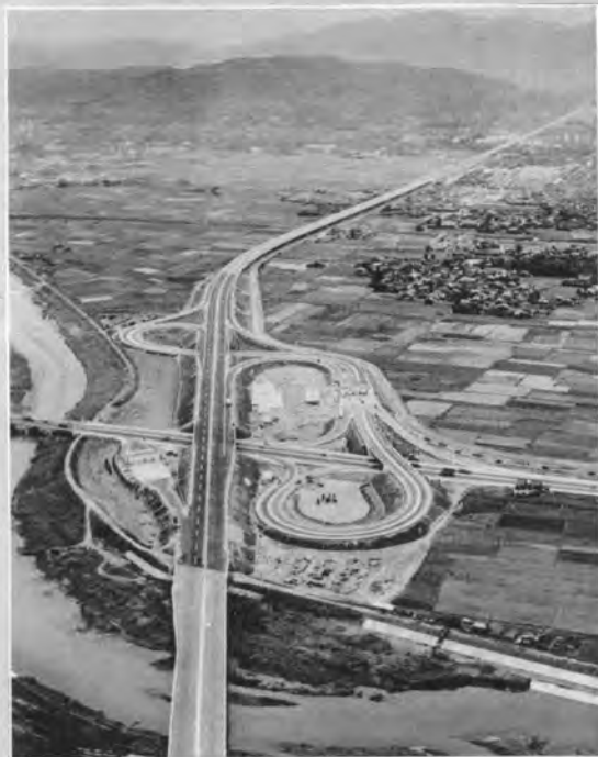
↑完成近い京都インターチェンジ ダブルランベット型と称される型式で、 平面交差はどこにもない。
