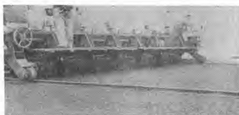
写真-6 スパイク・ローラ
