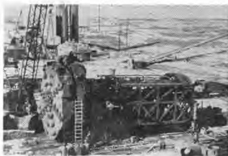
写真-7 カナダのサスカチワン川ダム水路に用いられた径 7.8 m の第9号機の現場組立
