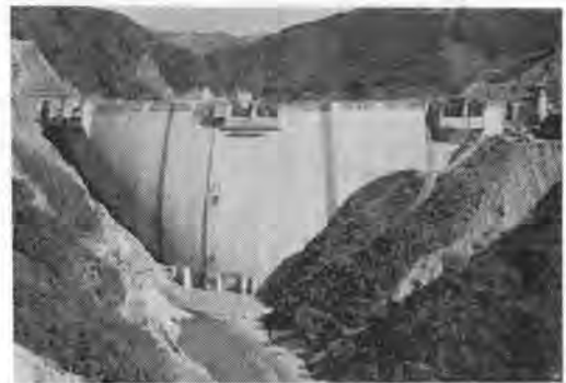
写真-1 ほぼ完成した一ツ瀬ダム
