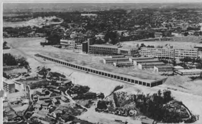
↓ 片開き地下道橋の全貌 (関西大学前) 学校を騒音から守るために、この構造物は設計されたが、音響に関する多くの実験研究が行なわれた。
