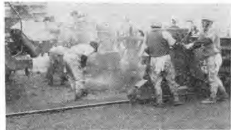
写真-4 合材敷均し
