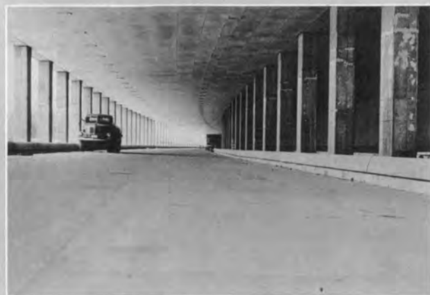
↑ 片開き地下道橋の内部
