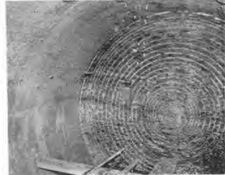
写真-6 トロントの下水トンネルに使用された直径 3.3 m の第 6 号機により掘られた切端
