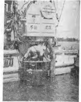
写真-5 振動くい打機 V-5型
