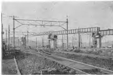
写真-2 米原駅構内桁架設工事
