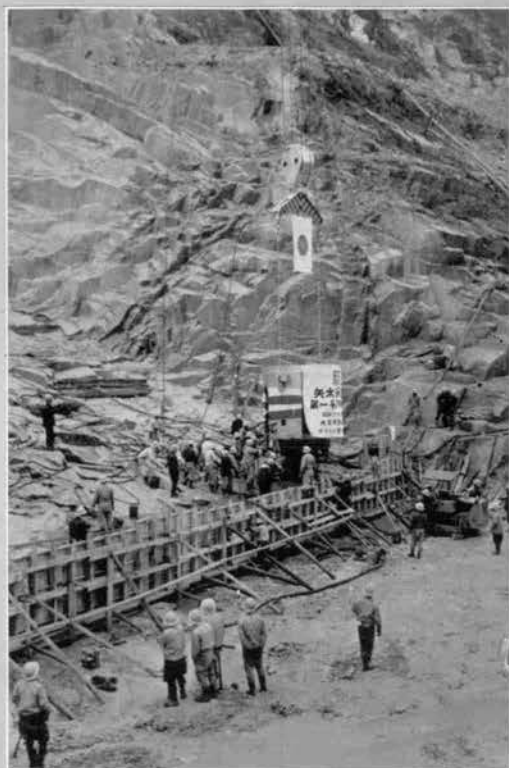
↑本体コンクリート打設第1号バケット 昭和37.11.16
