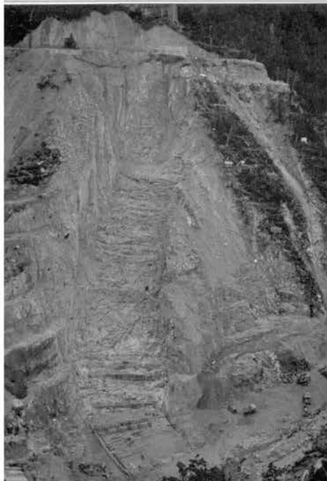
← ダムサイト左岸掘削状況 昭和38.5
