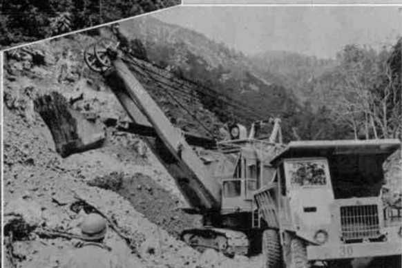
↑原石山における骨材採集状況
