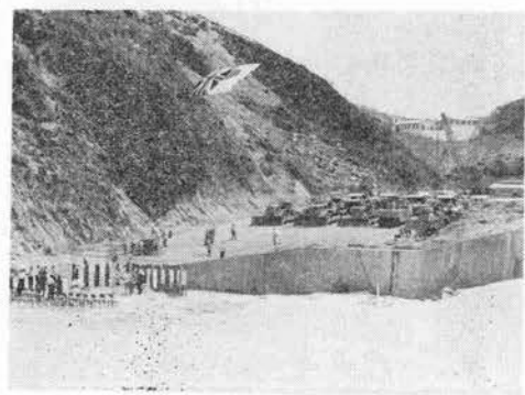
写真-4 定礎式当日勢ぞろいした重機械 手前コンクリート壁はカットオフ
