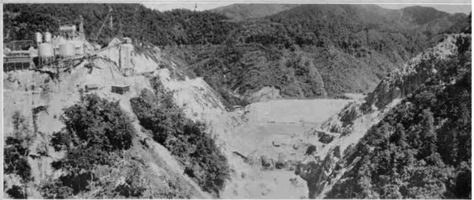
↑ダムサイト全景（下流側から見る）昭和38.7
