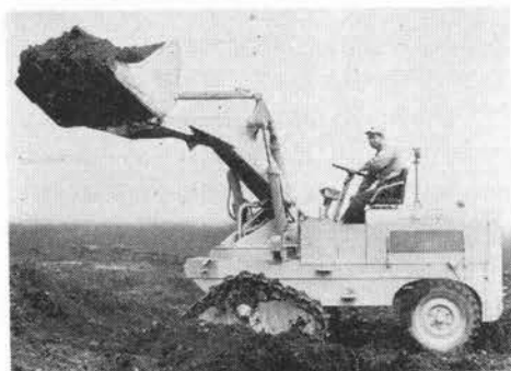
写真-1 三井アルマンA 60 スイングショベル
