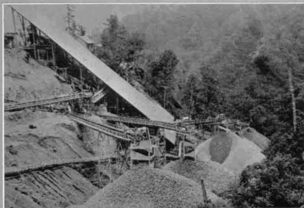
↑クラッシングプラントと骨材ストックパイル
