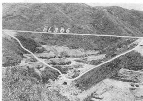
写真—1 下流からダム地点をのぞむ
