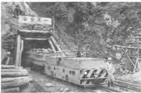
写真-9 蓄電池関車によるずり出し
