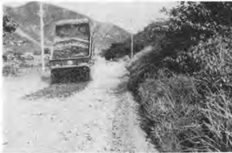
写真-2 ダンプカーで骨材の補給散布
