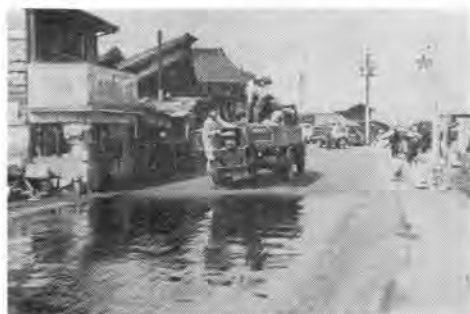
写真-12 スプレッダで碎石6号散布
