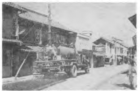
写真-11 ディストリビュータ (4 t 積) で乳剤散布中・能力 10,000 m³/日
