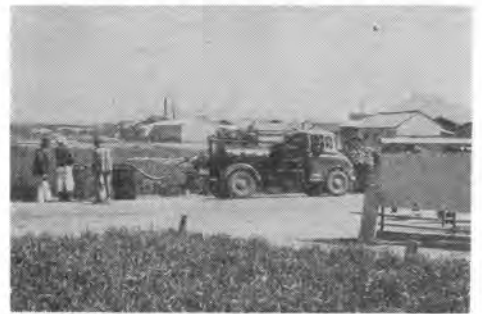
写真-10 ドラムから直接乳剤を吸込み作業中
