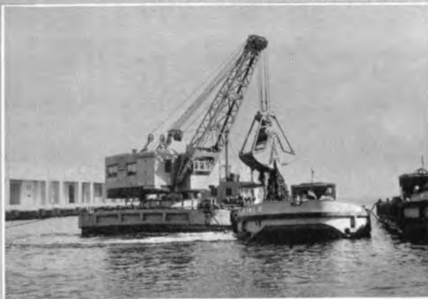
↑ 神戸港で浚渫中の4 m 3 グラブ浚渫船 “播磨号”
