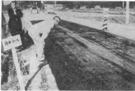
写真-7 第1回タール散布直後
