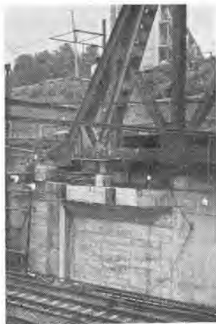
写真-3 部材で補強されたトラス
