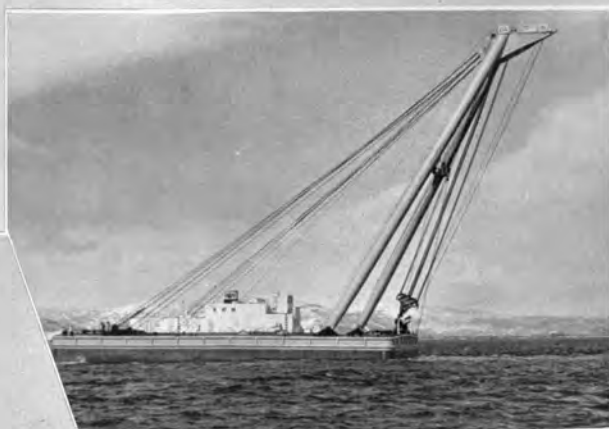
↑ 神戸港におけるPC管据付け用に建造された450 t 通り起重機船 “鉄拐号”
