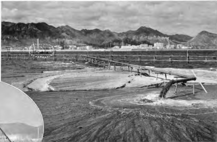
↑ 岩国の臨海工業地帯埋立工事中の260kW陸搬式電動ポンプ浚渫船“龍田丸”
