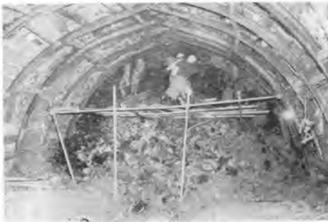
写真-2 上半断面掘削
