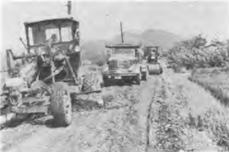
写真-3 グレーダによる骨材の敷均し
