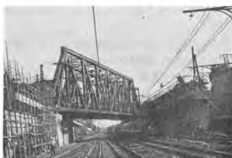
写真-2 扛上される橋げた
