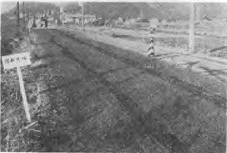
写真-8 6号砕石散布後の状況
