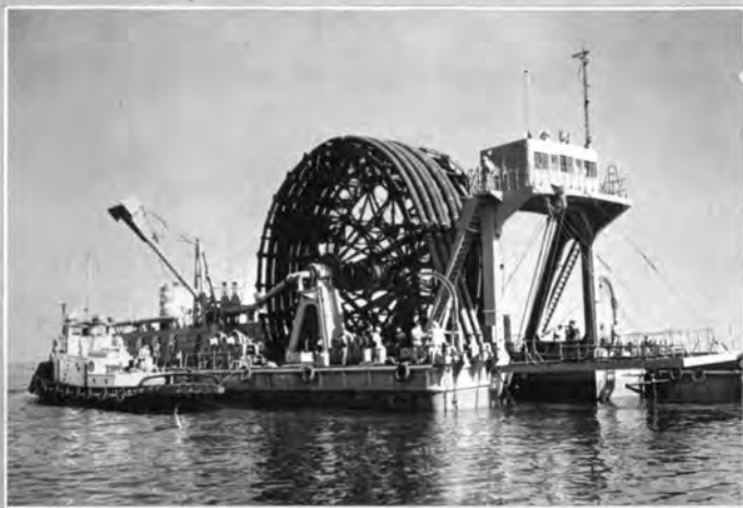
↑ 神戸港で深掘浚渫中のエゼクター浚渫船“飛竜号”
