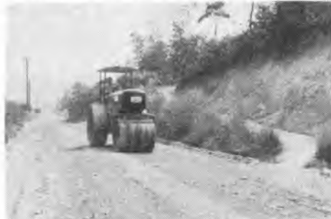
写真-5 ローラで転圧
