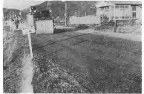
写真-9 転圧作業車 (10 t ロール)
