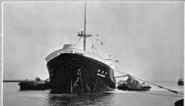
↑大阪南港での土砂卸し作業
