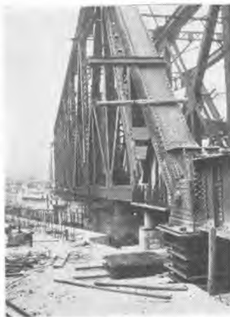
写真-4 箱座をそう入した状況
