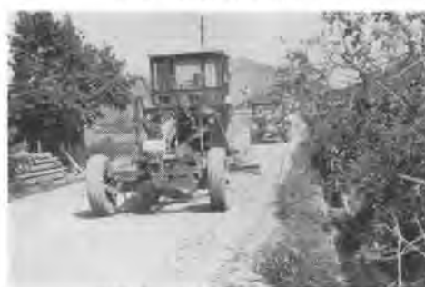
写真-1 グレーダで現道掘削中
