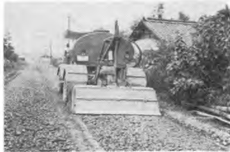
写真-4 スタビライザによる骨材の混合、敷均し
