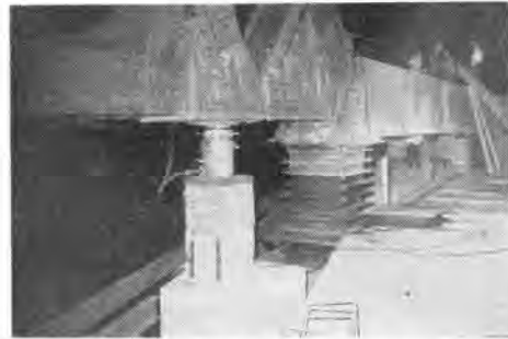
写真-5 箱座をそう入した状況
