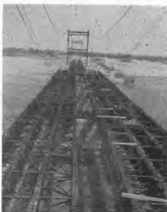
写真-3 けた架設状況(ケーブルクレーン)
