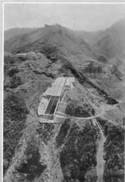
↑完成した取水口 (昭和38年4月)
