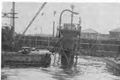
写真-4 羽田一浜松町モノレール橋脚基礎工事の東京湾上での施工
