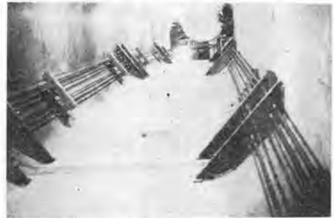
写真-5 えい航中の応力に対してハイテンションバーで締付ける
