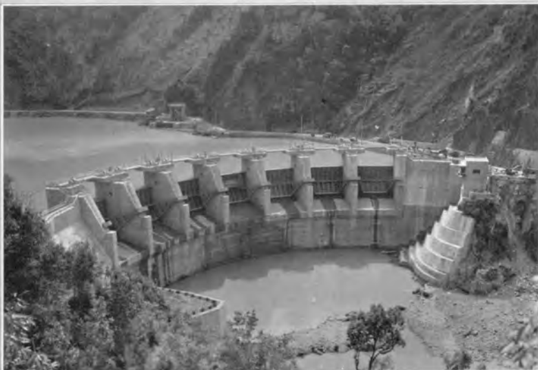
↑ たん水した杉安ダム (下流側から)
