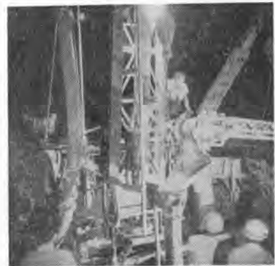
写真-2 ブランジャ式トレミーによる生コンクリート打設
