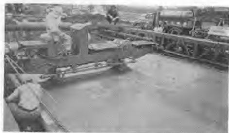
写真-3 コンクリートレベリングフィニッシャ LF形
