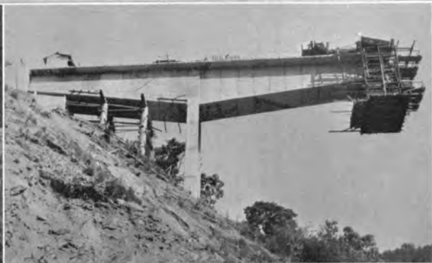
↑ 越野尾橋架設工事
