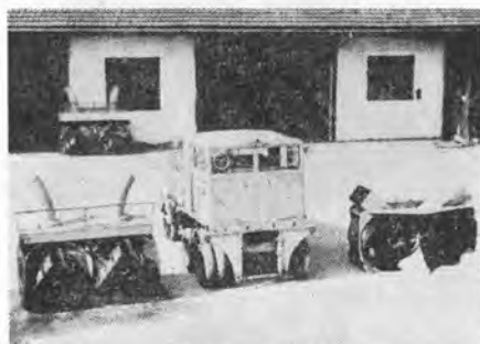
図-55 カッタ、プロアの交換アタッチメント
