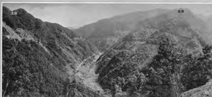
↑ 昭和35年10月の一ツ瀬ダム地点の状況 (ダム工事着手前)
