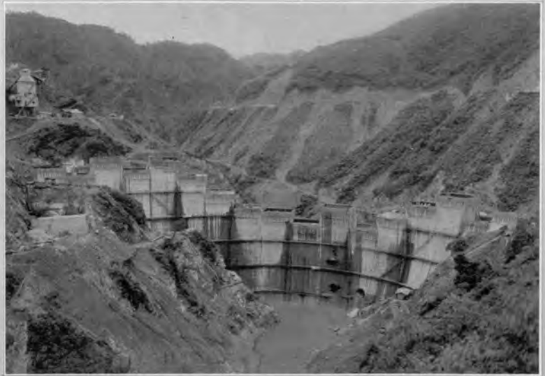
↑工事中のダム（昭和37年7月、下流側から）
