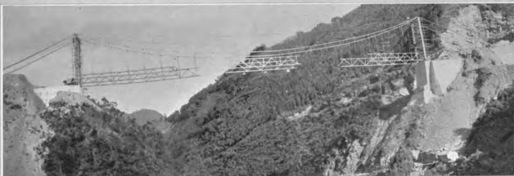
← 米良大橋架設工事 (補剛構つり橋)
