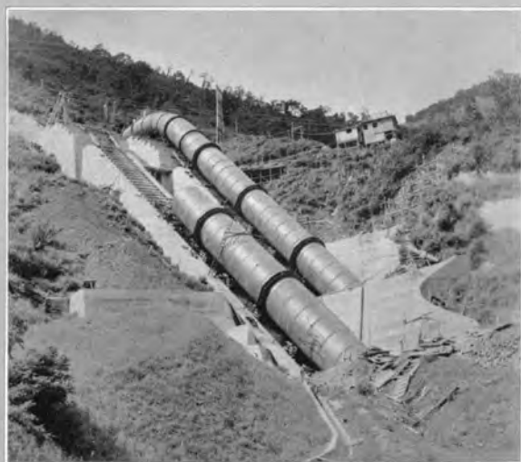
↑水圧鉄管路据付状況 (昭和37年9月)
