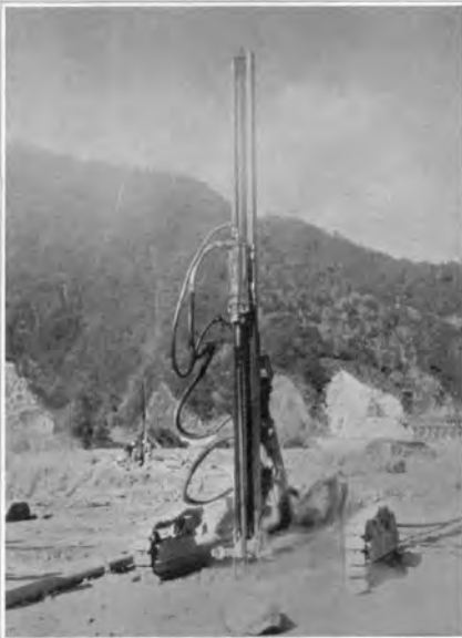
↑ 原石山で稼働中のエアトラック ドリル (AT-1000)
