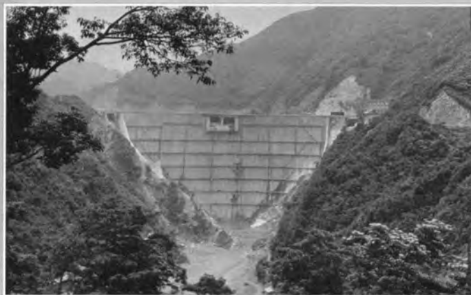
← 完成したダム背面
