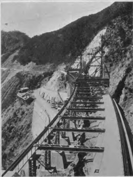
↑ケーブルクレーンテール タワーと同走路
