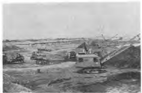
写真-2 陸上掘削現場状況
