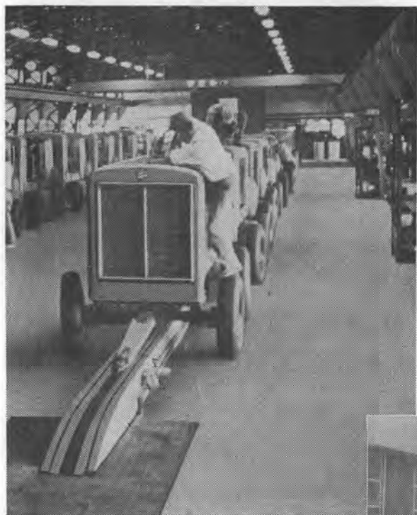
コンベア システム 組立工場
