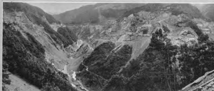
↑ 昭和36年3月の一ツ瀬ダム地点の状況 (ダム仮設備施工およびダム掘削中)
