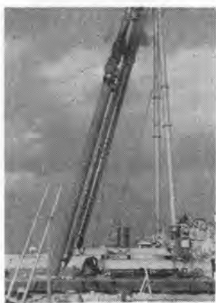
写真-2 くい打状況
