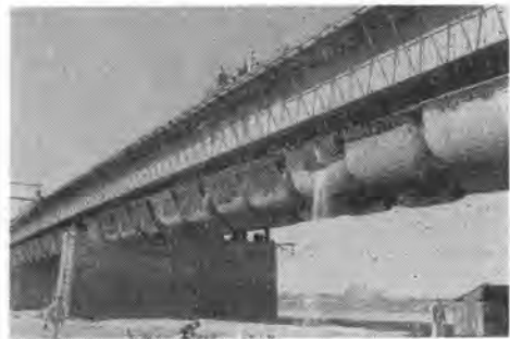
写真-7 水荷重状況(横川橋梁製作所特許工法)
