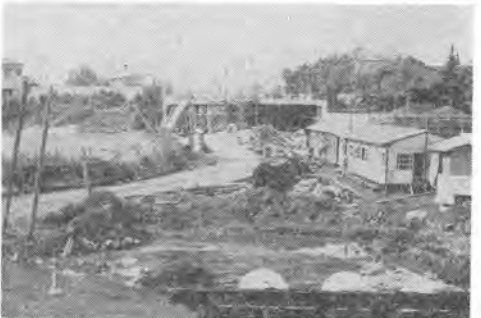
写真-16 (補24)環4との交点、前方はずい道工事中
