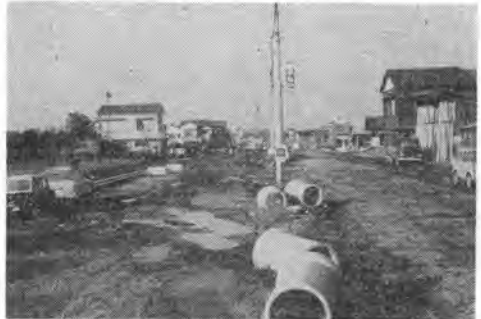
写真-15 (補134)補134整備状況(練馬区谷原町付近)
