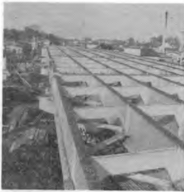
写真-11 (放3)大井町 線立体交差の 橋げた架設状 況
