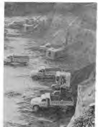
写真-2 土工工事(ショベルダンプ作業)
