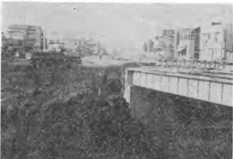
写真-13 (環8)環8整備状況, 橋りょうは第3京浜国道との立体
