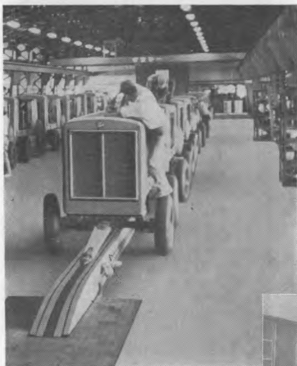
コンベア システム 組立工場
