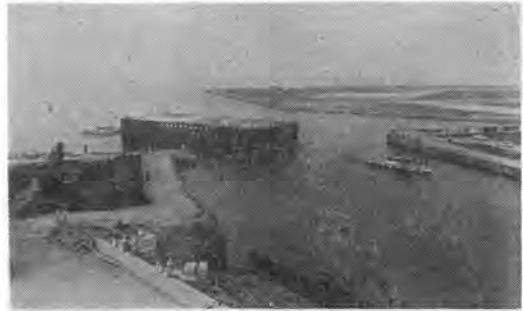
写真-1 沈埋函のえい航埋設作業
