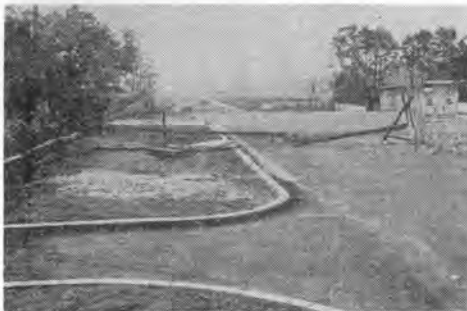
写真-12 (放7)放7整備状況(練馬区貫井町付近)
