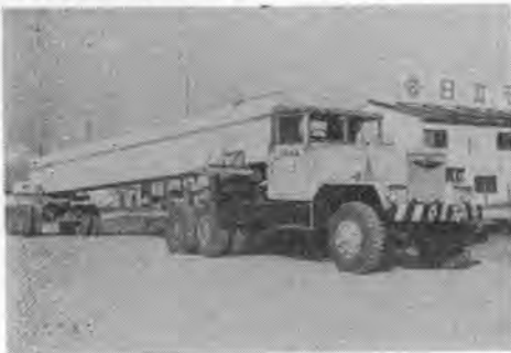
写真-1 けた運搬トレーラ
