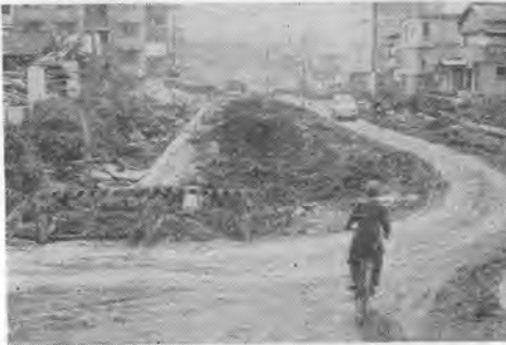
写真-6 (環4) 補24との交点から南方を望む
