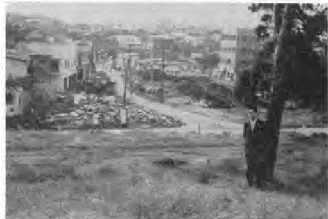
写真-4 放 23 ワシントンハイツから環 6 方面を望む を工事中である。
