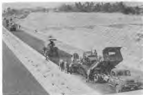
写真-1 舗装工事(表装の舗装)
