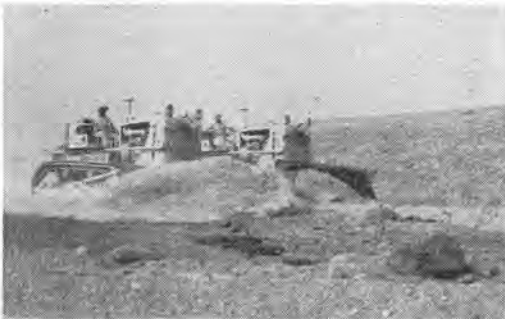
写真-2 ベリーで D80, GD37 稼働中
