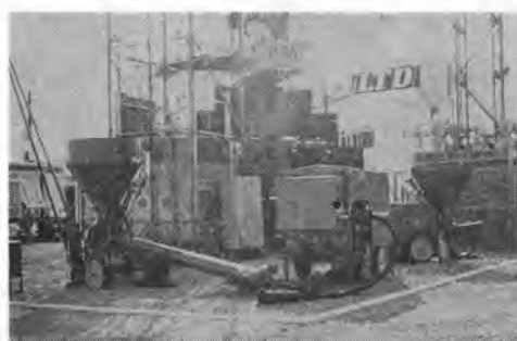
写真-14 ACE Achivery Ltd. コンクリートポンプ
