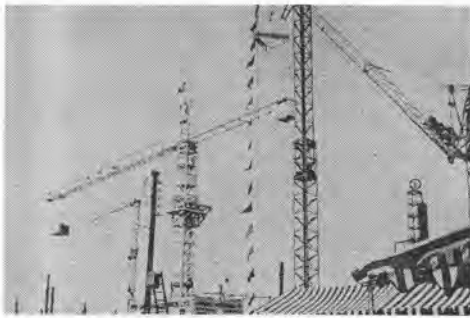
写真-6 簡易タワークレーン
