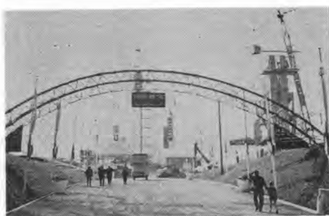
写真-10 A テラス中央口、デビッドメタル社の 74' スパンアーチ支保メタル
