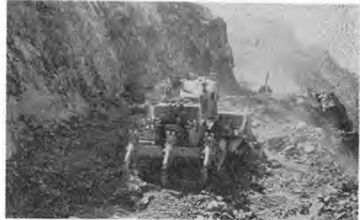
写真-4 サウジアラビアで D120 稼働中
