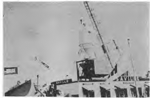
写真-8 ウエンゲット社のプラント
