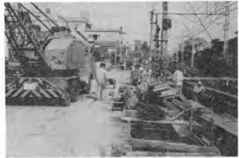
写真-8 (環6・京王線)京王線立体改良工事状況
