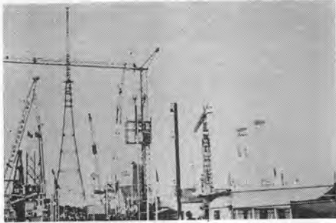
写真-1 各社のタワークレーン
