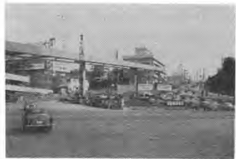
写真-1 放4赤坂見付立体交差の橋脚建設中 左方は高速道路4号線
