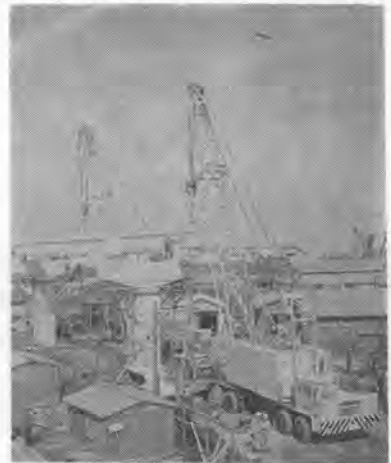
写真2 モノレール軌条架設作業
