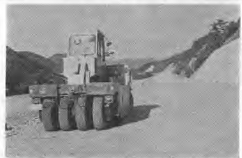
写真-2 路床面ブルーフローリング用25tタイヤローラ
