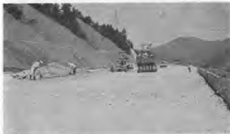
写真-1 グレーダによる路床改正
