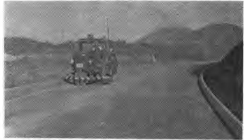
写真-6 モータースイパによるベースコース清掃
