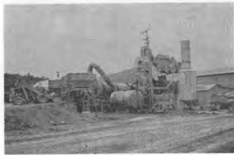
写真-5 アスファルトプラント T4 フレデリックパーカー 60 t/h
