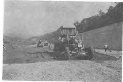
写真-13 サブベースコース舗設中 (手前:モータグレッダで敷均し 12t, 中:マガダム ローラで転圧 15t, 後:タイヤローラで転圧 25t)
