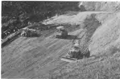
写真-6 盛土転圧 タイヤローラ 15~18t
