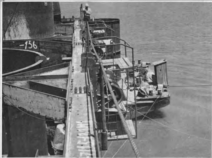
↑ケーソンは、北側ピヤーは40.69m×18.14m、南側ピヤーは40.69m×23.77mで、外壁のウインチはアンカーに固定したロープをまき、ピヤーを固定するためのものである。
