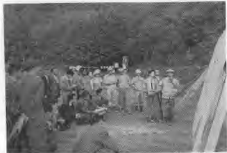
写真-3 根曳道路現場での工事状況説明
