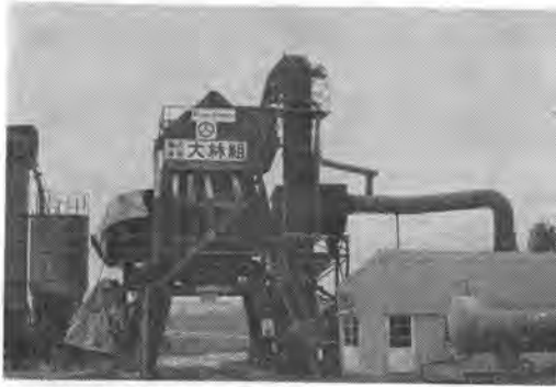
写真-3 アスファルトプラント Barber Green Co. OSM-893
