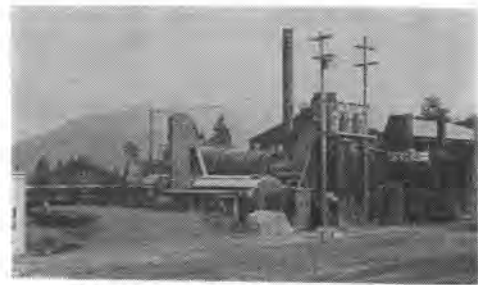
写真-11 100 t/hr アスファルトプラント
