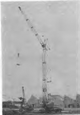
写真-1 日立 F106 タワークレーン 主な仕様は表-1のとおりである。
