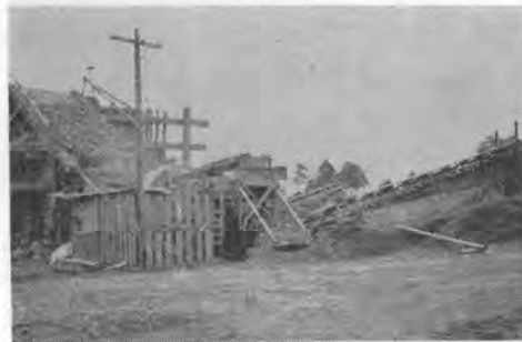
写真-6 クラッシングプラント アイオワ移動式
