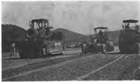
写真-3 グレーダによるサブベース合材敷均し およびタイヤローラ転圧
