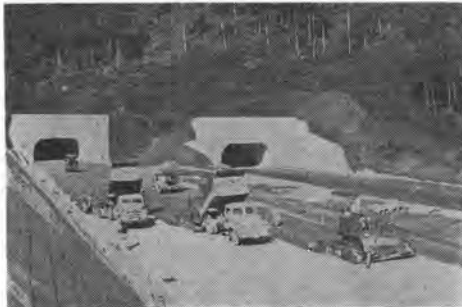
写真-4 アグリゲートスプレッダによるベース合材敷均し
