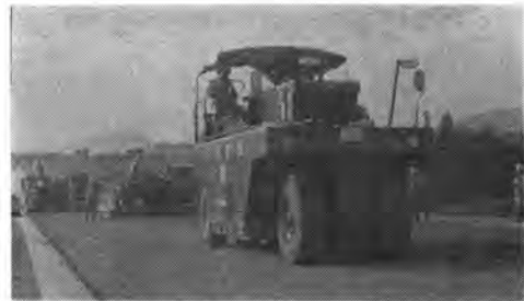
写真-5 ベースコースブルーフローリング用25tタイヤローラ
