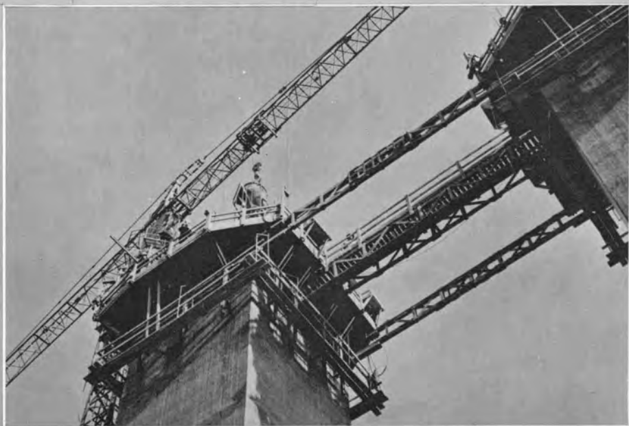
→ アプローチのピヤー スライディングホームで 施工中
