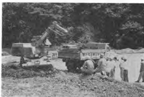
写真-9 新機種土砂積込 油圧式掘削機 0.4m 3 油谷ボクレン T.Y. 45
