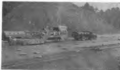
写真-3 セメント安定処理工施工中
