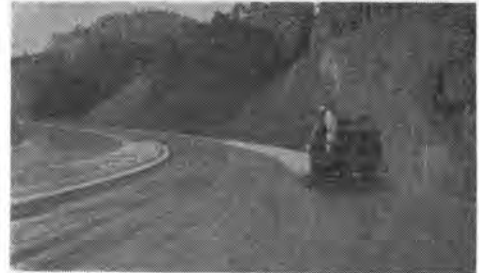
写真-7 デストリビュータによるプライムコート散布
