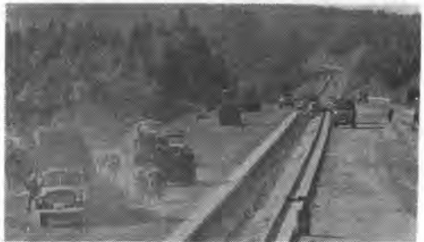
写真-7 デストリビュータによるプライムコート散布
