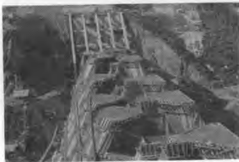
写真-2 工事進行中の穴内川ダム
