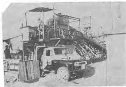
写真-2 ベースミキシングプラント
