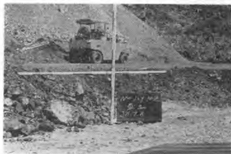
写真-8 盛土転圧 各層 50cm 厚さ敷均し転圧
