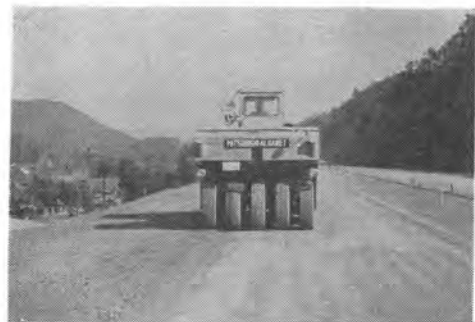
写真-14 タイヤローラ 25 t でベースコース転圧中
