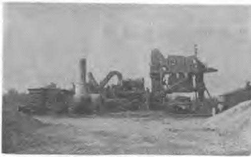
写真-3 アスファルトプラント
