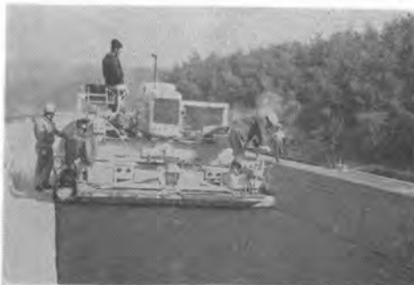
写真-60 アスファルト舗設中 セドラビット 60 t/h
