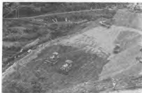
写真-5 盛土ブルドーザのまき出し ブルドーザ D 509t、ブルドーザ BF 15t
