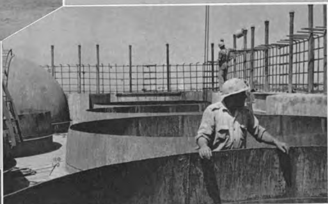
↑掘削中のウエルは、直径4.712mで、 南側および北側のピラーは、それぞ れウエルの数が28および21個である。
