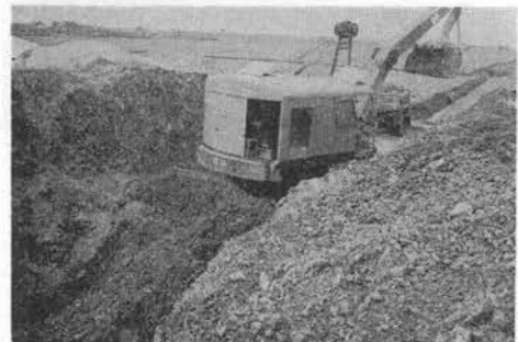
写真-13 場内での掘削積込み作業
