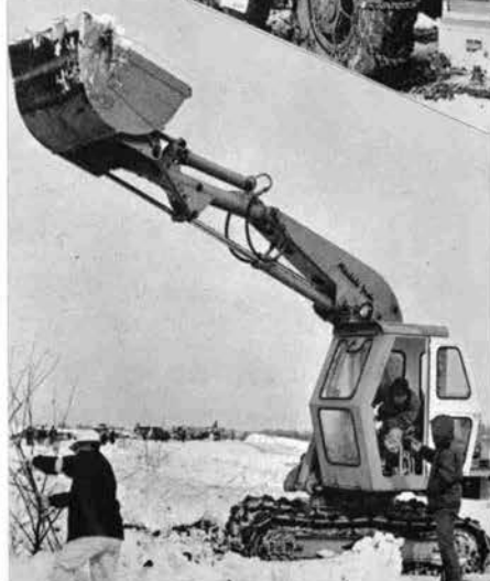
↑ロータリ除雪車：川崎車輛 KLD-5P スノーフライヤ
