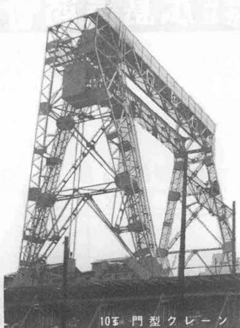
103 門型クレーン
