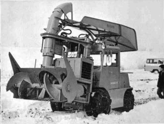
↑ロータリ式スノーローダ：新潟鉄工 NMR-1
