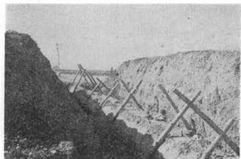
写真-14 工事現場の一場面
