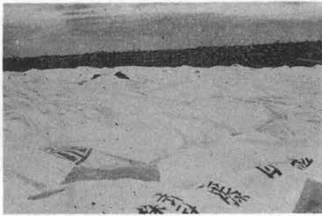
写真-7 ビニールシートにより土砂に雨の当るのを防ぐ
