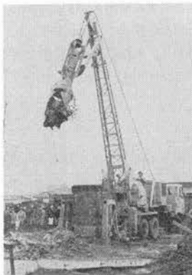
写真-2 実演中の BT-2 型ベノトボーリングマシン
