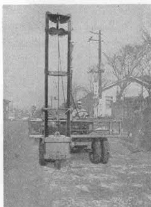
写真-8 ウインチ式コンクリート破砕機
