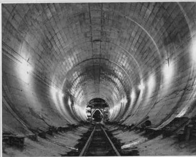
↑放水路本巻完了 (S. 38・12・20)
