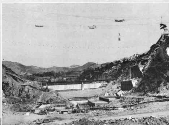
↑コンクリート打設および掘削 (S.38-3-20)
