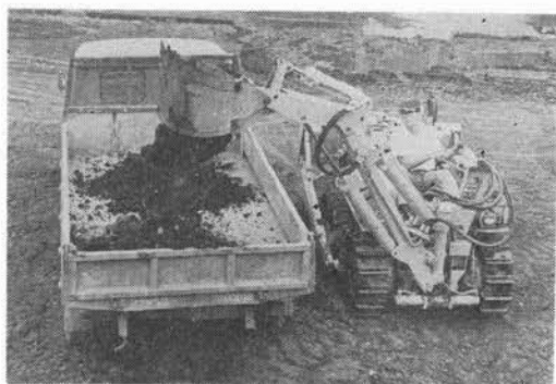
写真-4 ショベル作業
