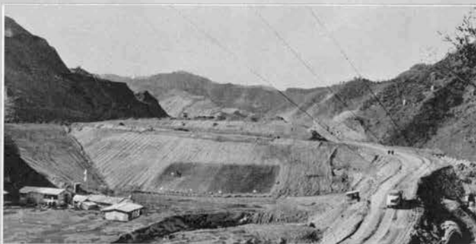
↑本沢ダム全景(下流側より)(S.38-11-20)
