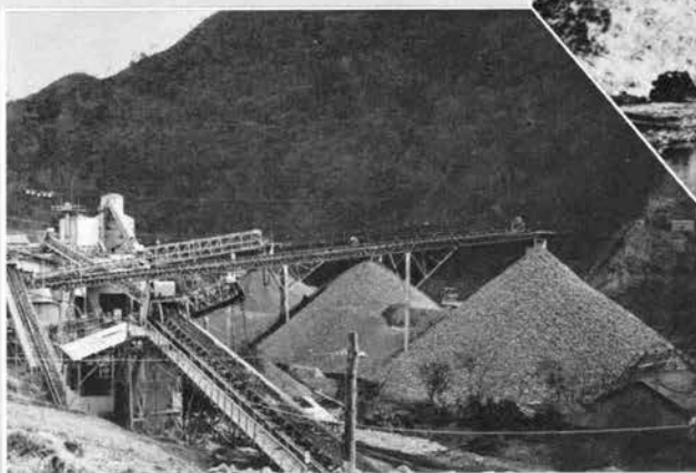
↑城山ダム工専用骨材プラント (S.39-1-8)
