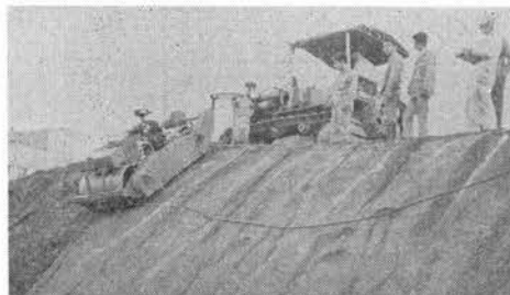
写真-2 振動ローラ式法面締固め機
