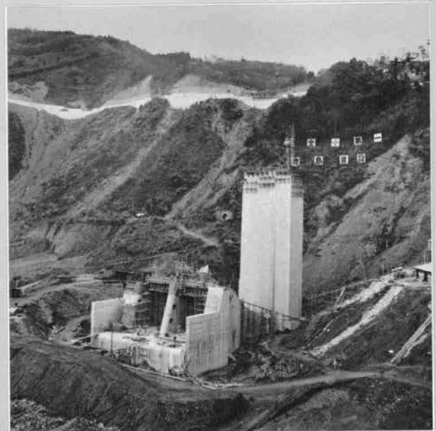
放水口工事 (S. 38・12)
