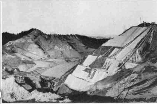
↑本沢ダム 左前方：ロックフィルダム 右：取水口 (S.39-1-8)
