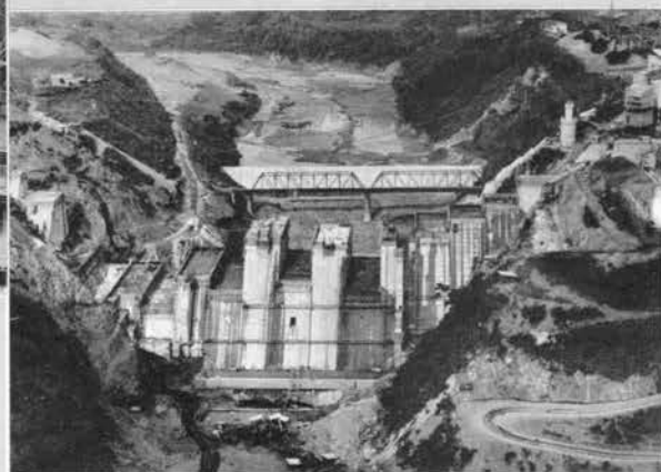
↑城山ダムコンクリート 打設状況 (S.38-11-20)
