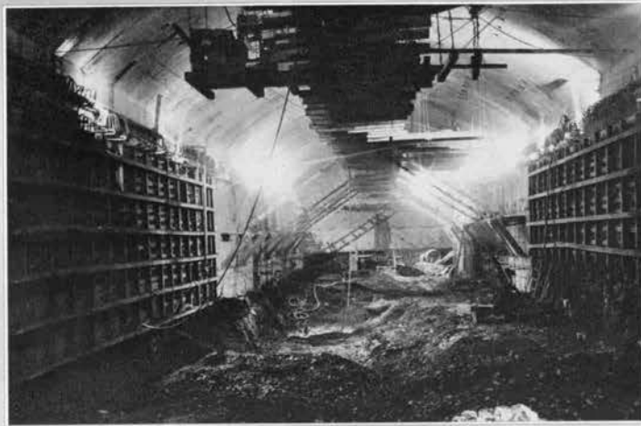
↑調圧水槽頂部の工事 (S. 38・12)
