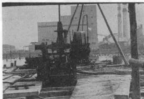
写真—1 テスト現場 (試錐機)
