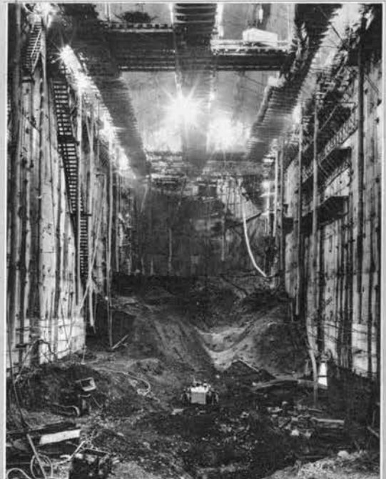
城山発電所の盤下げ状況 (S.38-12)
