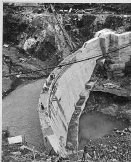
← 上流仮締切 ダム完成 (S. 35.8)
