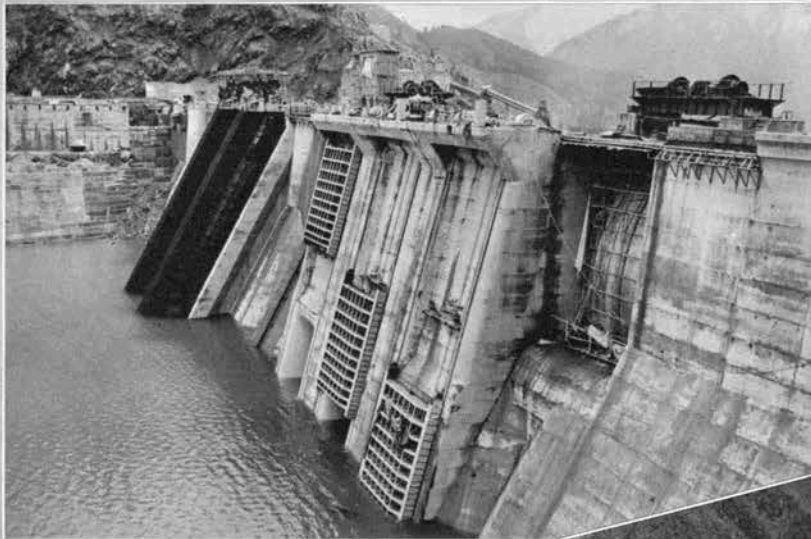
↑コースターゲート3門 型式 四方水密ローラゲート 径間 7.400m 高さ 9.352m クレストゲート2門 型式 テンターゲート 径間 8.600m 高さ 13.000m 掘付中
