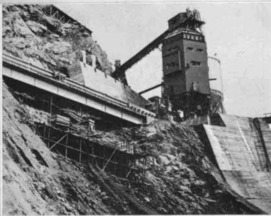
↑ バッチャプラント、バンカー線および トランスファーカー
