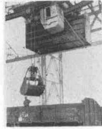
テルハーのワイヤーロープ直接掛 バケットにて貨車バラ荷物運搬中
