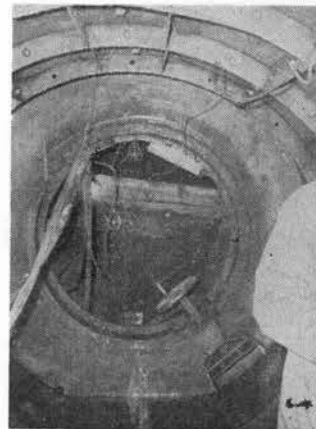
写真-26 作業中のシールド掘削機
