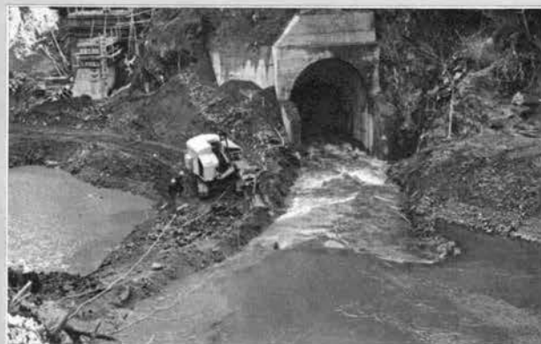
↑ 仮排水トンネル（径6.5m、延長312m）に 河流切換え（S. 35.4）
