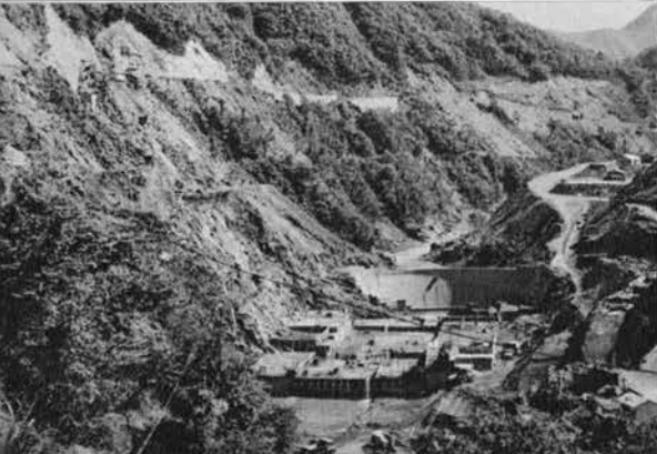
← 本体河床部コンクリート打設 (S. 37. 5)
