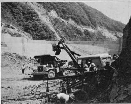
↑ 本体掘削工事 (12tダンプ、1.2m 3 ショベル) 掘削量 189,000m 3
