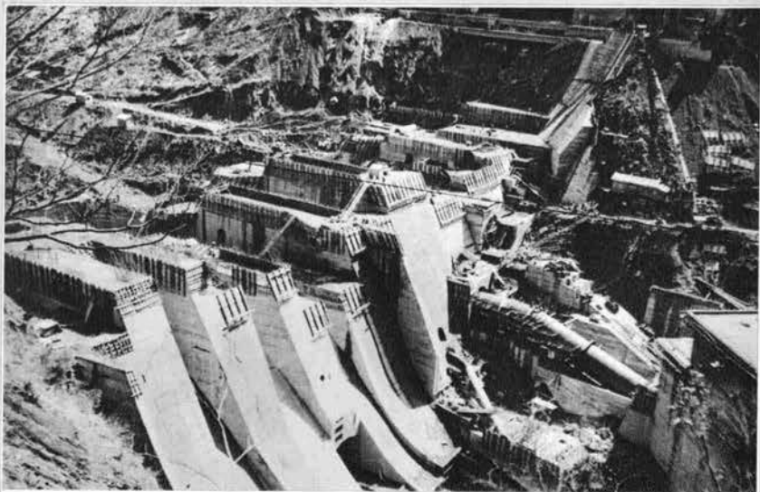
↑コンクリート打上り状況（下流面）
