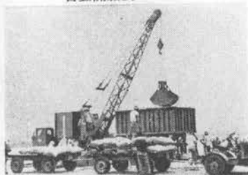
トラッククレーンの沿岸荷役に活躍中 の単索バケット及ホッパー
