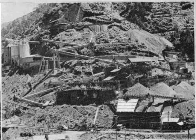
↑ 2次破砕製砂ふるい分工場全景 (220t/h)
