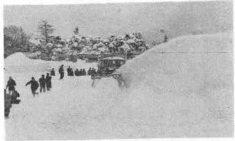
写真-7 北海道開発局の除雪機械性能試験
