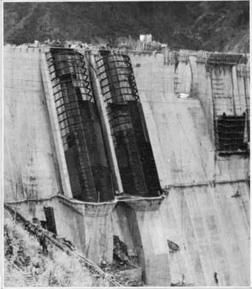
↑発電所取水塔スクリーン組立中
