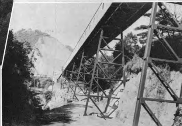
↑ベルトコンベヤー高架部の脚柱 No. 1コンベヤーの末端付近で、この脚柱が最も高く13m余りある。
