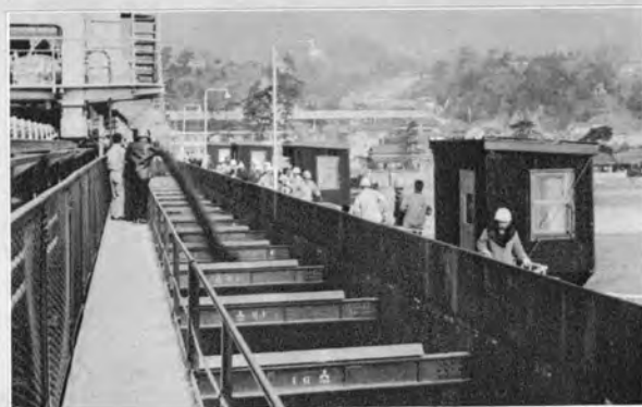
↑ トリッパから船積設備のホッパー内に落ちる土砂
