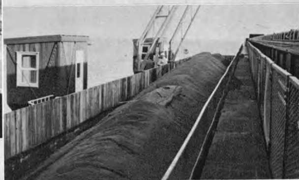
↓ 船積設備のホッパー内に満載された土砂
