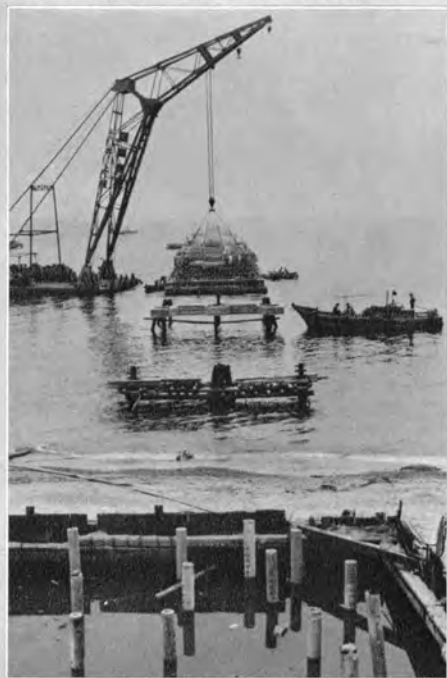
↑船積設備棧橋鋼管脚上にプレキャストげたをすえ付け中の状況
