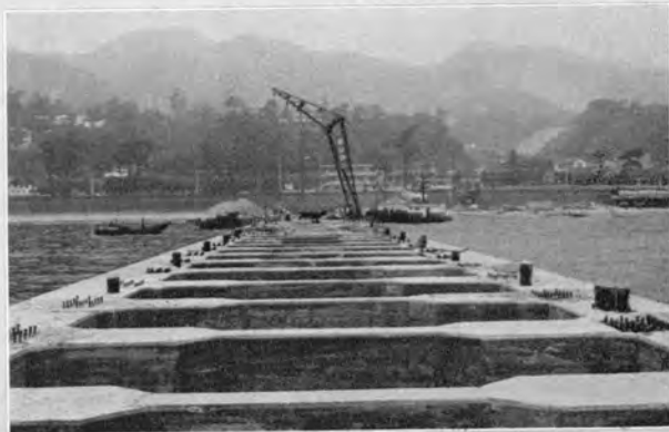
↑ 船積設備棧橋上部鉄筋コンクリートげたの完成状況
