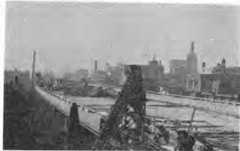
写真-1 大阪1号線西横堀川工区
