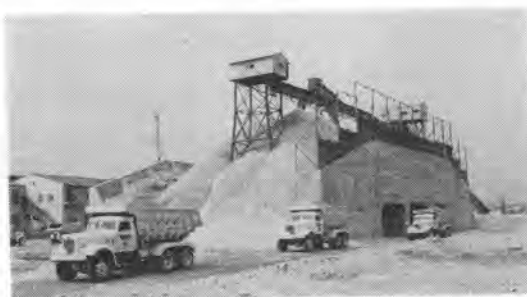
写真-5 貯溜そう (海岸ストックパイル) ダンプカーは貯溜そう下を循環して土砂を積んでいる。
