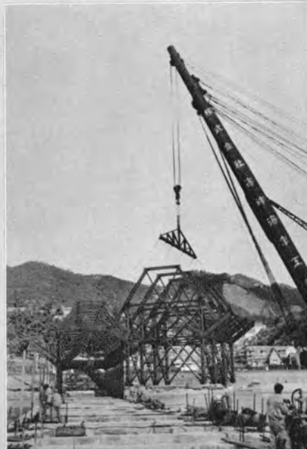
↑ ホッパー鉄骨脚すえ付け状況
