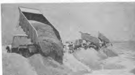
写真-6 土砂投入の状況 ダンプトラックによる埋立地先端の土砂投入。
