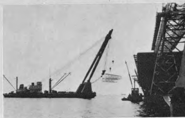
↑ 船積設備棧橋上部鉄筋コンクリートげたの完成状況
