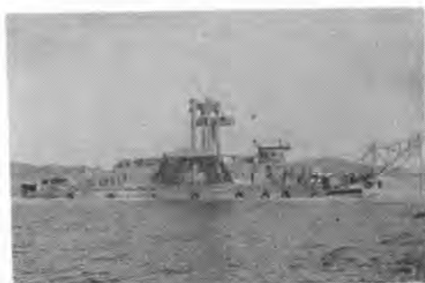
写真-1 カッターレスポンプ船による採砂作業
