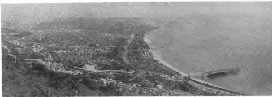
写真-1 須磨土取施設全景（西から東を望む）
