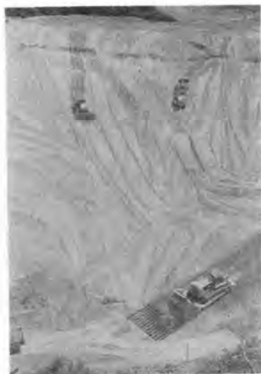
写真-4 土砂の集土および立坑への投入状況 立坑上部のスクリーンで30cm以上の石は除き、 別途に運搬して護岸裏込みに利用している。
