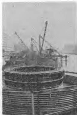
写真-4 大阪1号線四つ橋ランプウエイ
