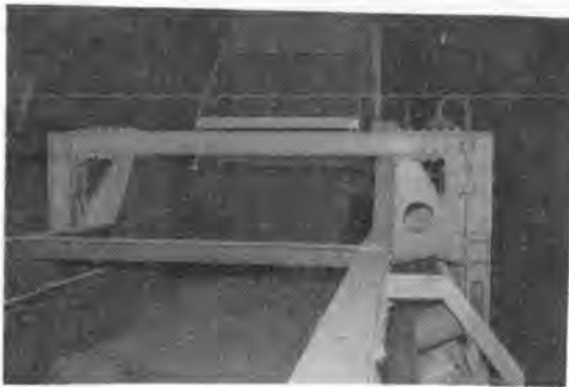
写真-3 ベルトコンベヤに土砂を積みこんでいる状況
