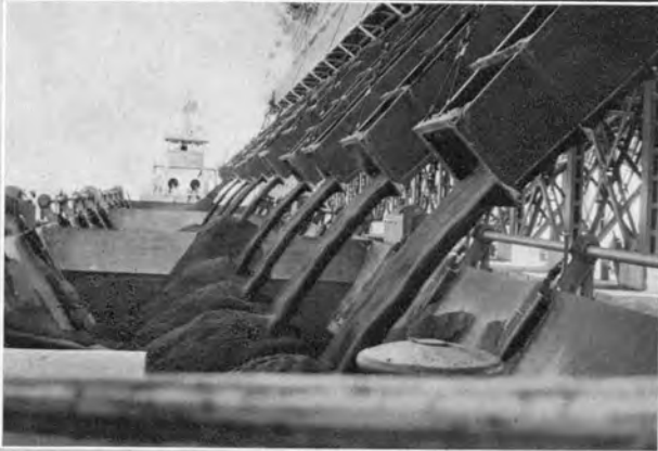
↑土運船に土砂を積みこんでいる状況
