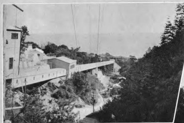
↑ベルトコンベヤー高架部架設状況
