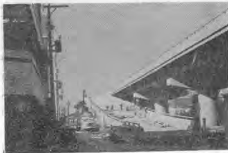
写真-5 大阪1号線四つ橋ランプウエイ
