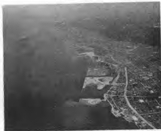
写真-1 神戸市港埋立工事進捗状況(昭和38年10月現在) 手前から東部3工区、2工区、1工区ならびに摩耶埠頭。左上方の突き出ている部分は和田岬付近の西部埋立地。なお鳥影は渡路島である。
