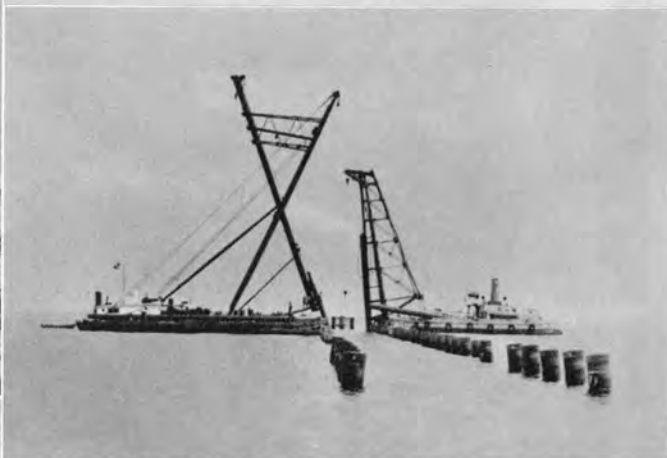
↑船積設備棧橋鋼管脚上にプレキャストげたをすえ付け中の状況
