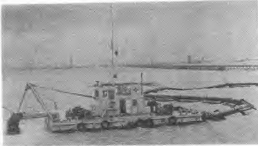
写真-4 敷砂施工状況
