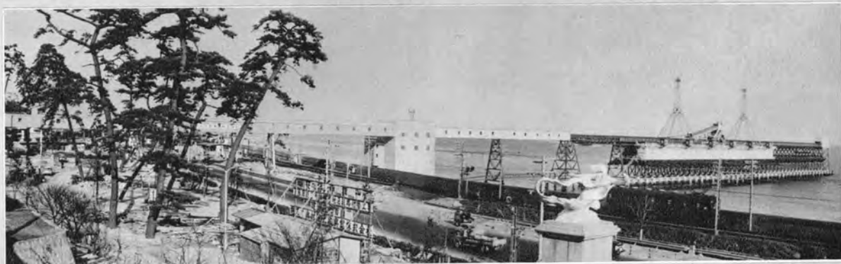
↑ 船積施設第1期工事完成状況
