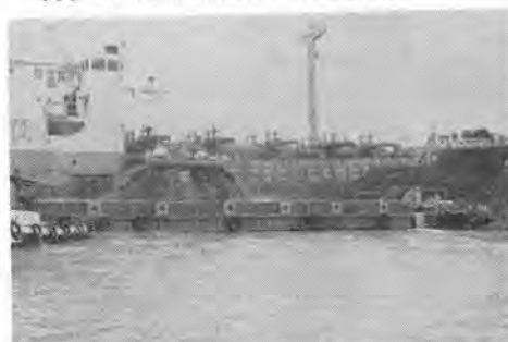
写真-3 サンドキャリアからバージの揚荷作業
