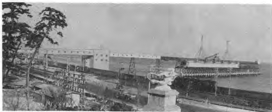
写真-2 船積設備全景
