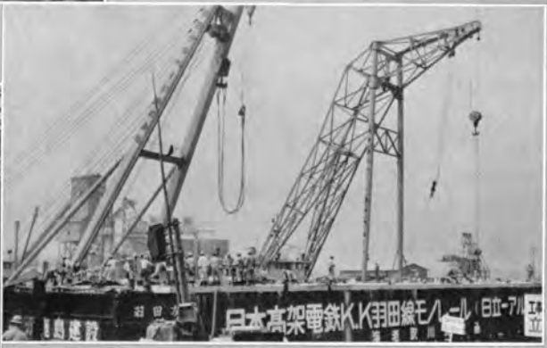
↑ 沈埋函沈設 (昭和38年 9月)
