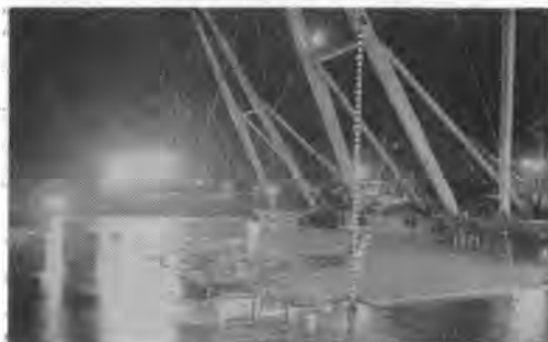
写真-4 沈埋函沈設
