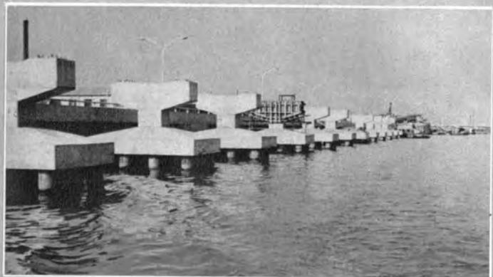
↑支柱立上り完了 (昭和38年11月)
