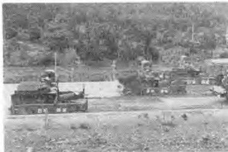
写真-2 雁隊をなして舗設作業中のアグリゲートスプレッダ
