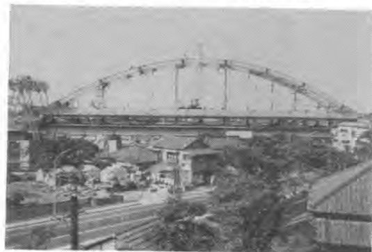
写真-5 桁の迫め作業
