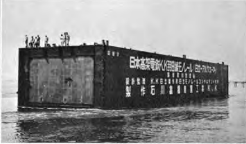
↑ 沈埋函曳航 (昭和38年 8月)
