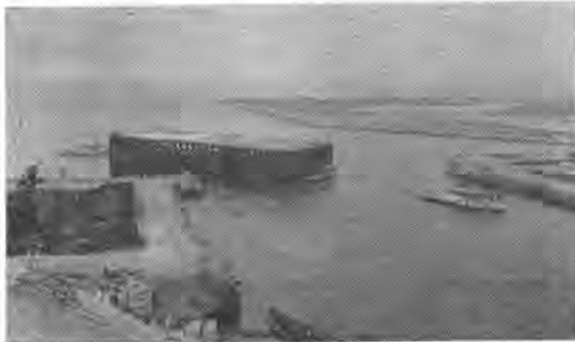
写真-2 沈埋函造船所から現場へ到着
