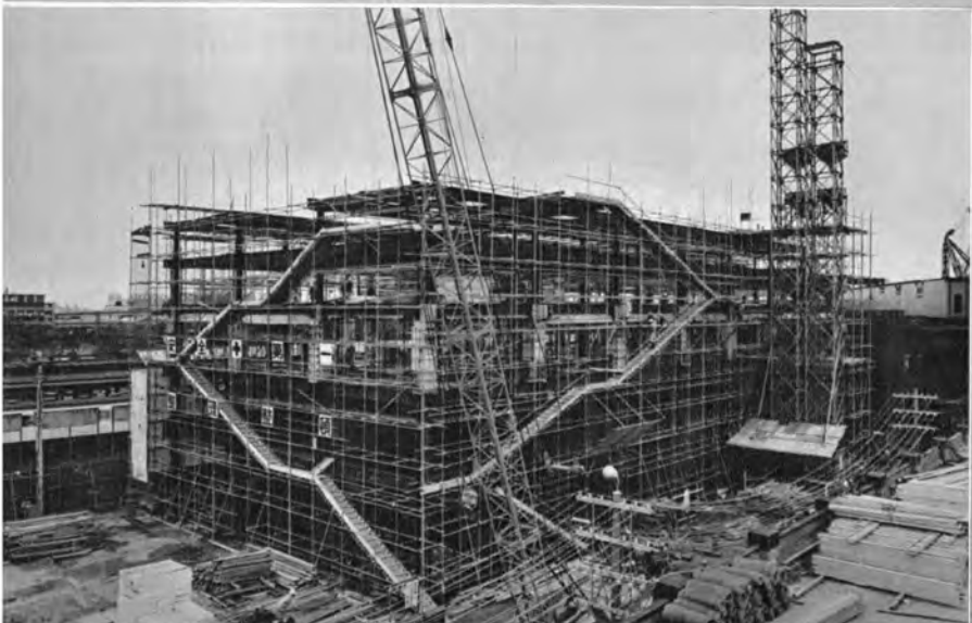
← 浜松町モノールステーションビル工事 (昭和39年 4月)
