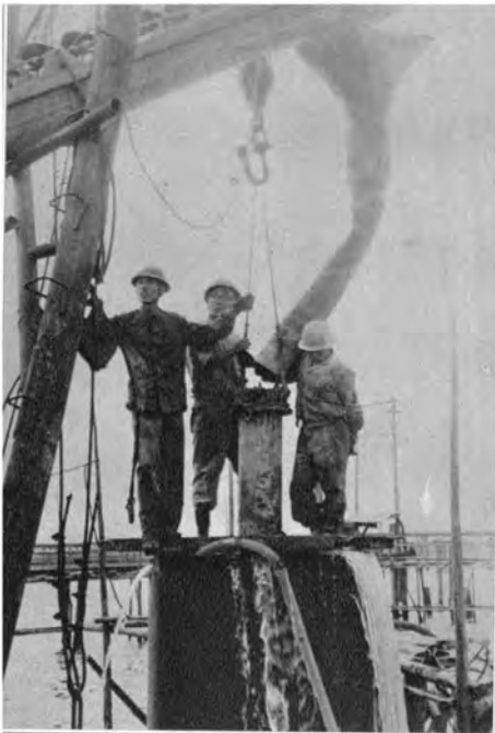
↑リバースサーキュレーション基礎工事 (昭和38年8月)
