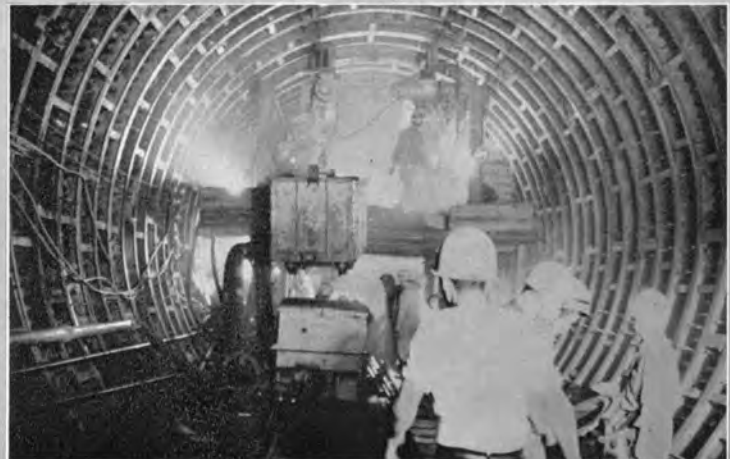
↑ケーソン内部でのシールドの組立 (昭和38年6月)
