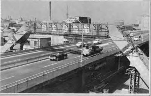
↑ 五色橋架道橋, 橋頭部据付け完了 (昭和39年 3月)
