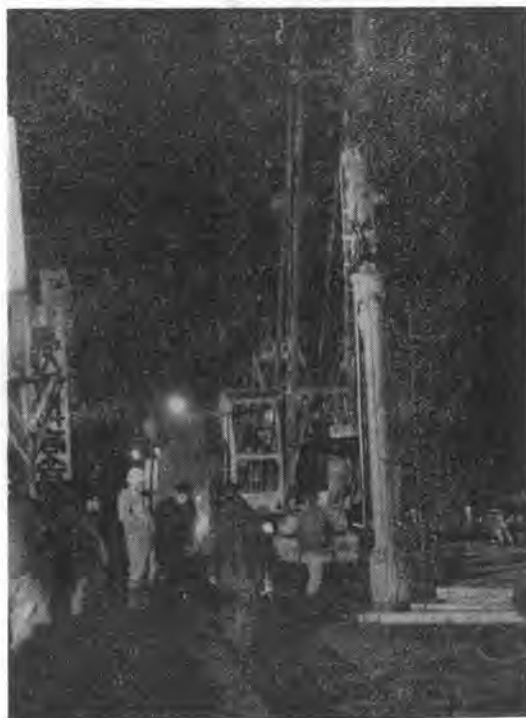
写真-3 デルマックによる鋼管くいの打ち込み
