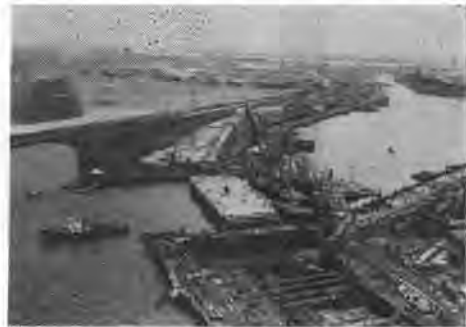
写真-3 沈埋函沈設開始
