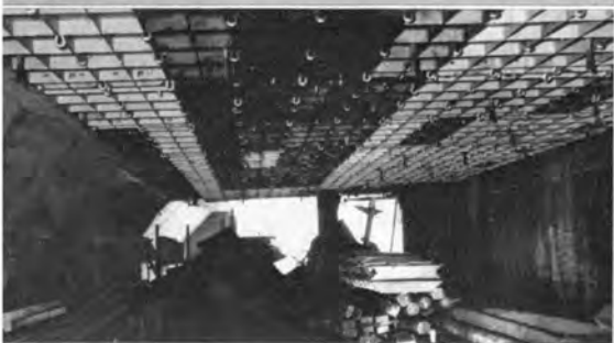
↑ 沈埋函内部(上床コンクリート打ち) (昭和39年 2月)
