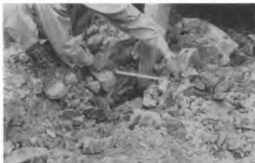
写真-3 リッパによる碎岩の状況
