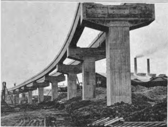
↑羽田空港周道路桁架設完了 (昭和39年1-4月)
