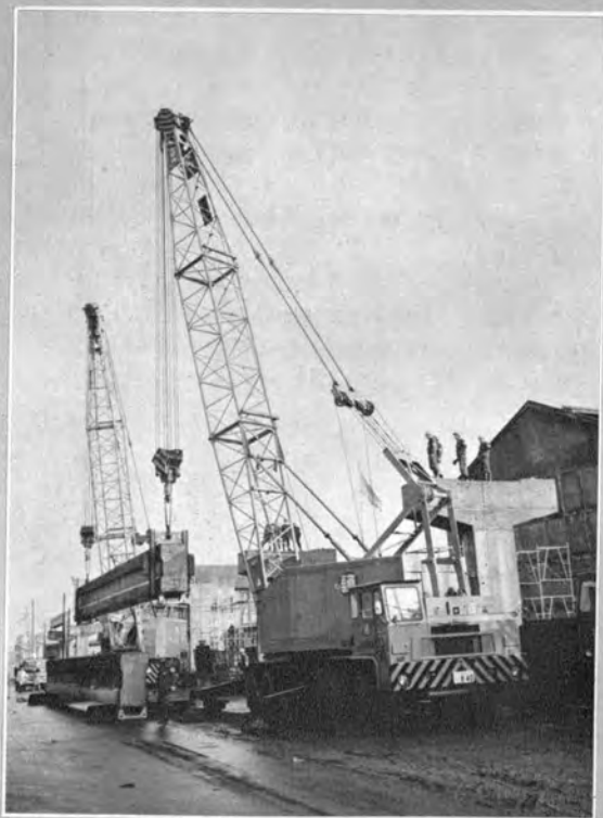
↑日立F210トラッククレーンによる桁架設 (昭和39年2月)
