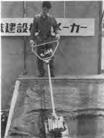
写真-8 MVCP ポータブル万能 転圧機(三笠産業)
