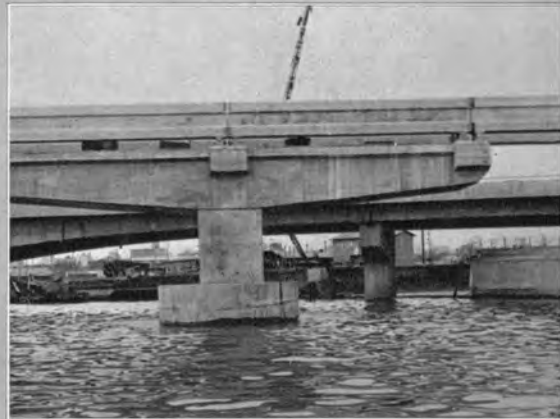
↑ディビダーク橋梁桁架設完了 (昭和39年3月)
