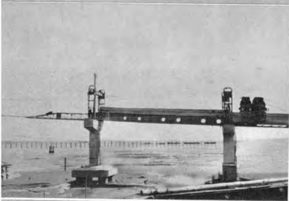
↑桁架設中 (昭和39年4月)
