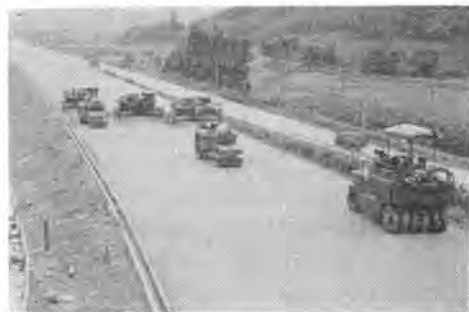
写真-3 雁隊をなして舗設作業中のアグリゲートスプレッダ
