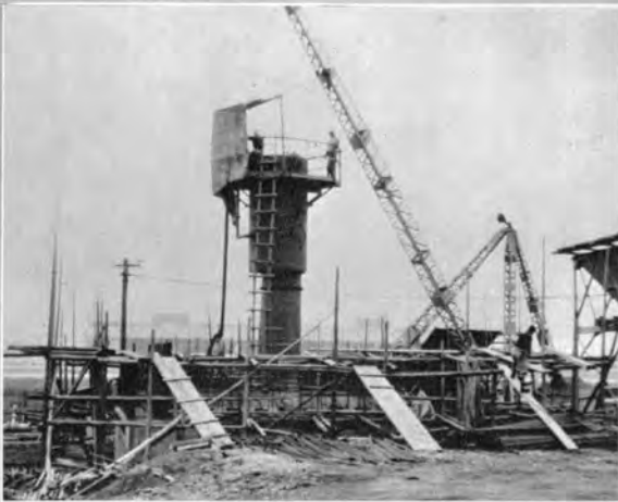
↑空港誘導路際にシールド組立用ケーソンを沈下施工中 (昭和38年5月)
