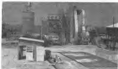
セダラピッドH-20、全自動バッチプラント60-80t/時2基が彦根地区にて稼動中
