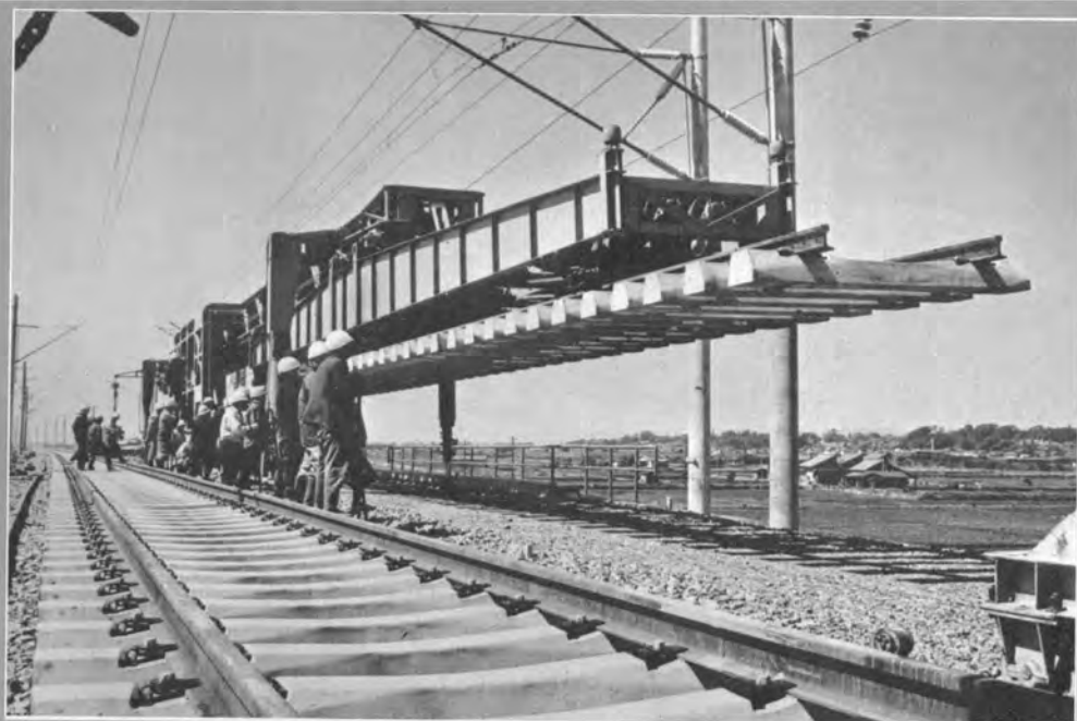
← 組立てた軌道 を布設する プッル車
