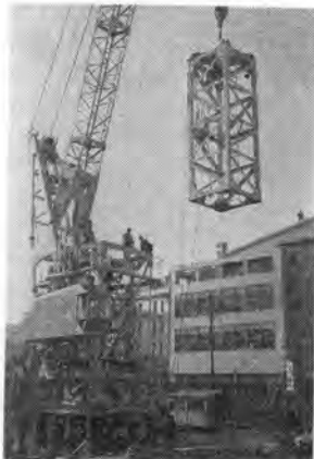
写真-6 OT 型タワークレーンの上部継足によるクライミング作業状況 (小川製作所)
