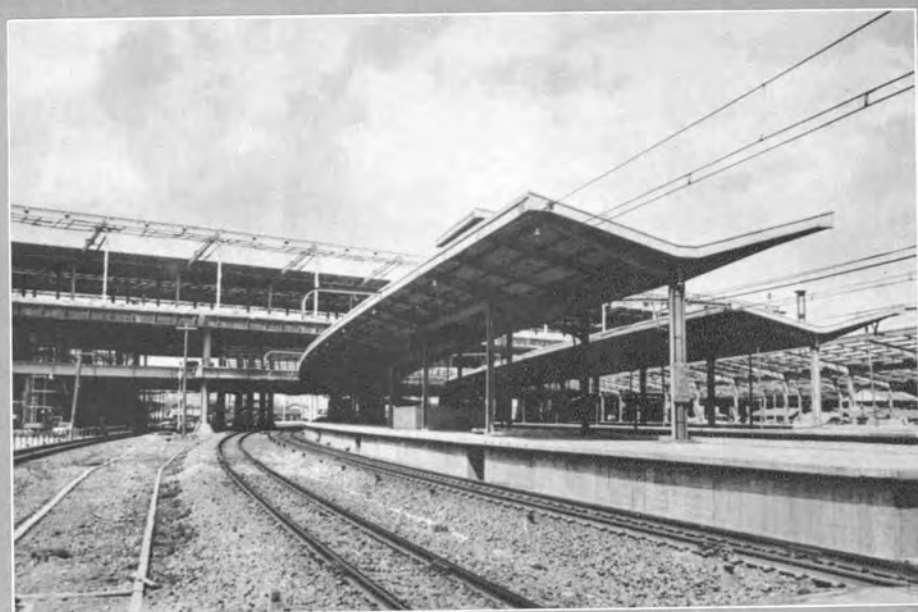
→ 後方は新大阪駅、 前面は現東海道線
