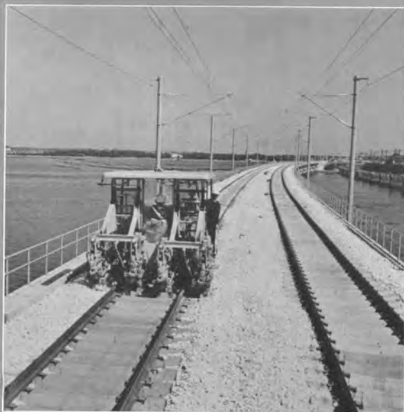
↑道床締め用 ジャクソンバ イプレータ
