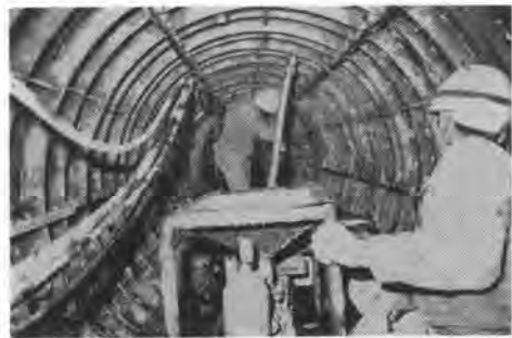
写真-5 裏込め注入中
