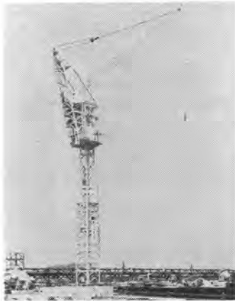
写真-9 KTK 120 W 型タワー クレーン (呉造船所)
