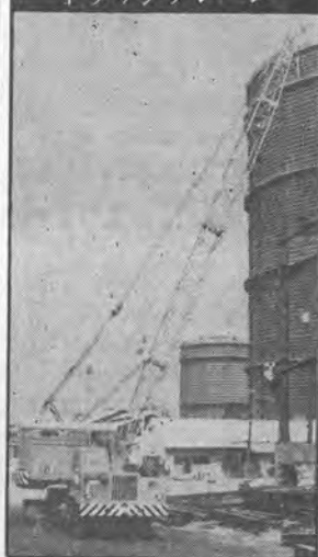
トラッククレーン
