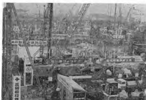
写真-7 林立するクレーンブームとくい打やぐら
