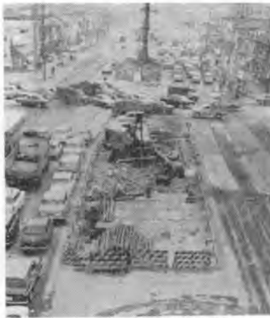
写真-1 工事現場状況
