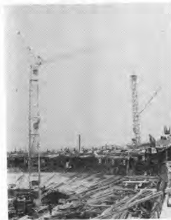
写真-2 561型パイネクレーン (住友機械工業)
