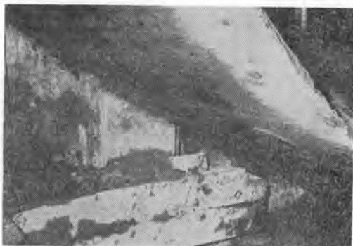
写真-7 シールドが終点の壁を力強く突き破った所
