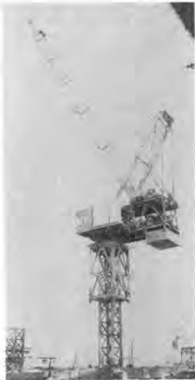
写真-10 UK 125 型タワー クレーン (浦賀重工)
