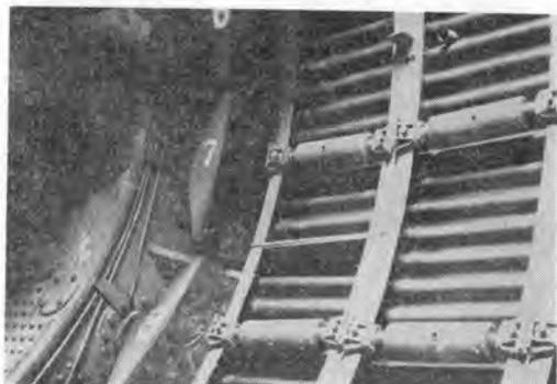
写真-10 セグメント組立完了
