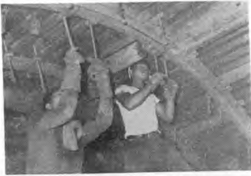
写真-11 押上げ鉄板用ボルト取付中
