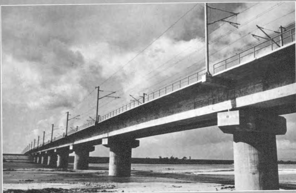
← 矢作川橋りょう
