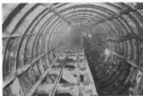
写真-4 セグメント組立終了
