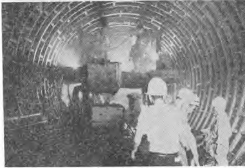
写真-4 掘削ずり出しトロ
