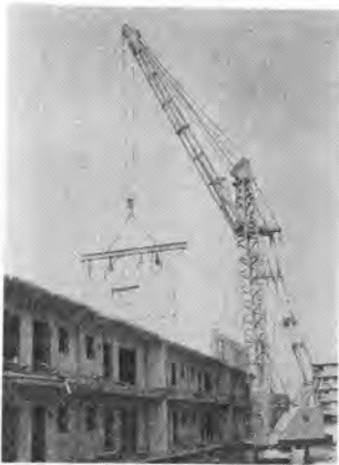
写真-4 50 TC タワークローラークレーン (石川島播磨重工)
