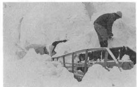
写真-5 雪におおわれたコンベヤ
