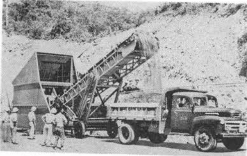
写真-11 コンベヤローダ (石川島播磨重工製)
