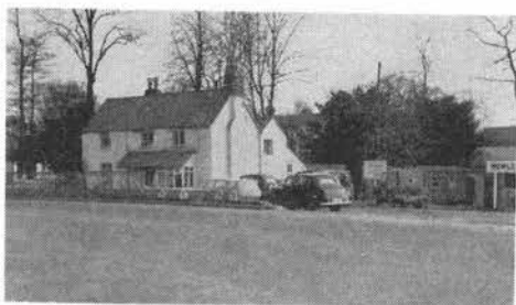
写真-2 事務所 既存の建物らしいがコントラクターがすべて準備する
