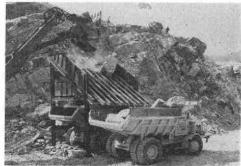
写真-2 岩掘削選別状況
