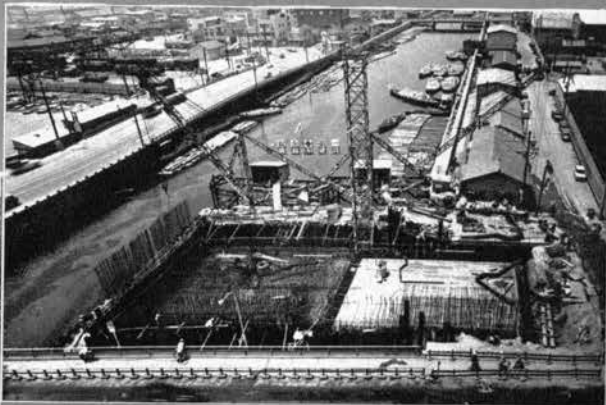
↑ 3号線道頓堀川のケーソン工事状況
