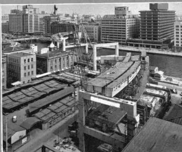
→ 堂島川をクロノイド曲線で渡る1号線の2階および3階桁架設状況(昭和38年6月末)
