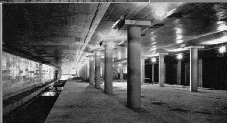
← 最後の仕上げを待つばかりの3号線西難波駅ホーム
