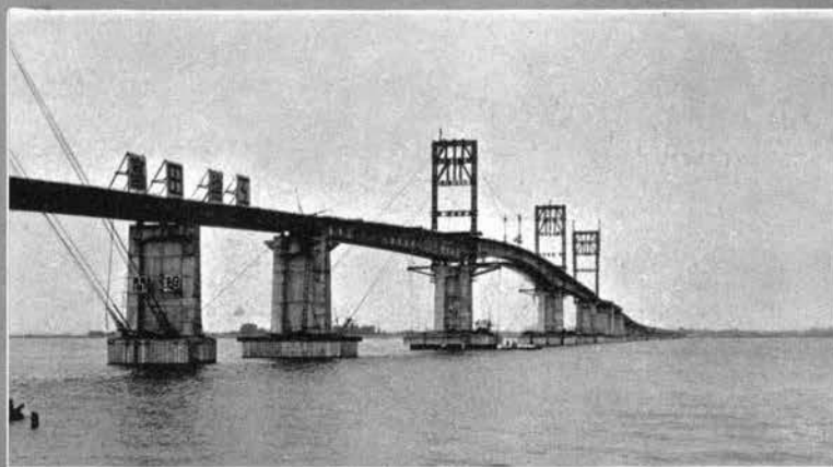
← 琵琶湖大橋の上部工架設状況
