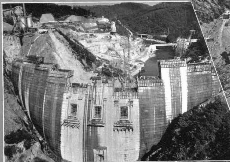
↑ 80%コンクリート打設すむ (昭和38年7月)
