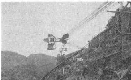
写真-4 ブライドル式ケーブルクレーンの移動機構 (越原鉄工所)
