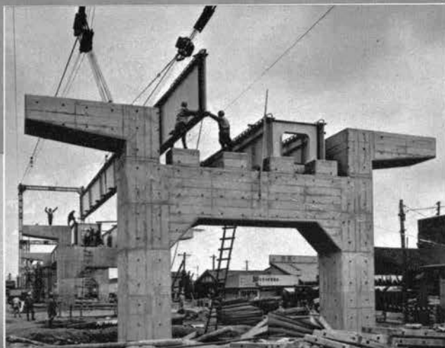
↑ 大阪市高速鉄道1号線南方付近の桁架設状況 (昭和39年3月)
