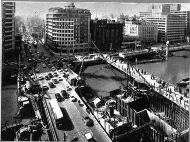
← 大阪市高速鉄道3号線渡辺橋付近の フローティング潜函構築状況
