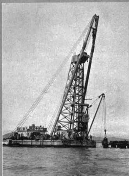
↑ 基礎工事に用くくい打船
