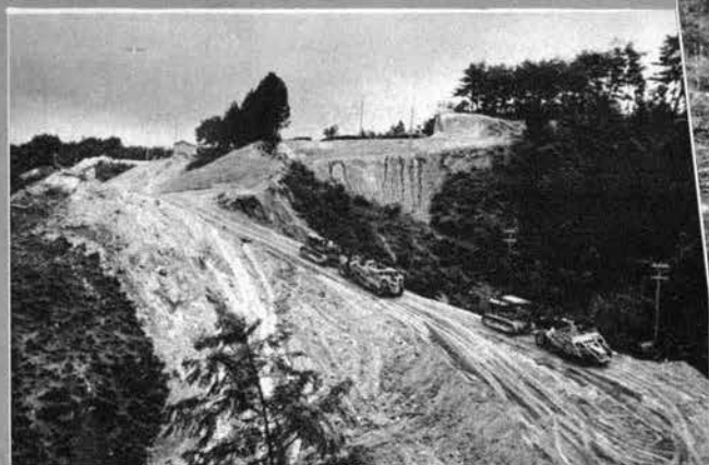
↑ 盛土工30mにおよぶハイバンク個所のスクレーバ作業
