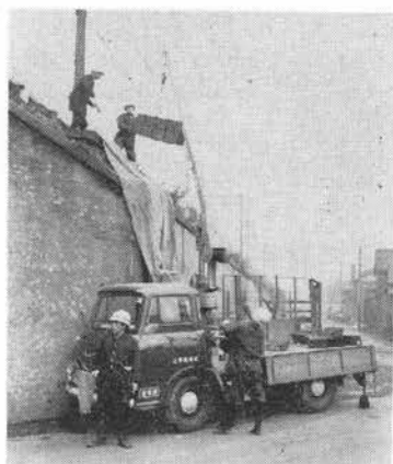
写真-1 鉄道保線作業に使用中の共栄ユニック U-100
