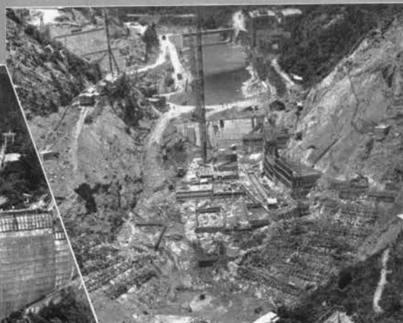
↑ コンクリート打設を開始して間もなくのダムサイト (昭和37年5月)
