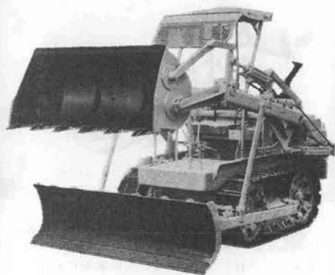
■トレンチャを装備して 溝掘り作業中のCT2
