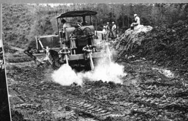
↑ 岩盤掘削に活躍するリップドーザ
