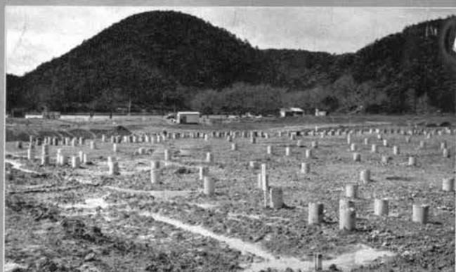
↑ 大会議場基礎くい打込み完了状況
