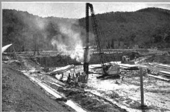
↑ 管理棟基礎くい打状況
