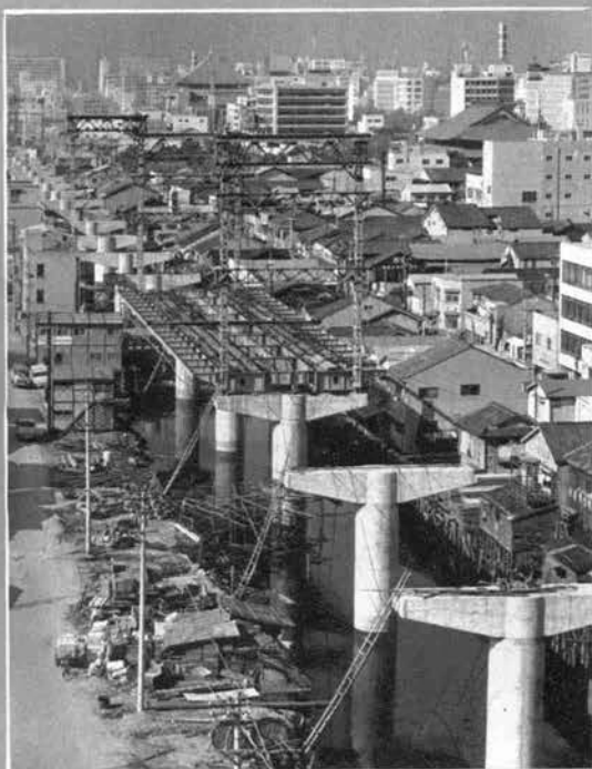
↑ 西横堀川の上に施工中の大阪1号線
