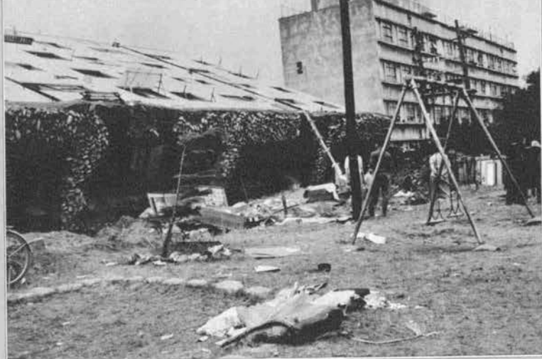
↑川岸町県営アパート転倒棟 向う側2号棟は半地下式で被害少なく、この地下室と 屋上に強震計があって記録が取れている。
