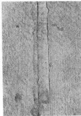
写真-4(b) 過硫化ビッチ目地構成物でシールされた継目
