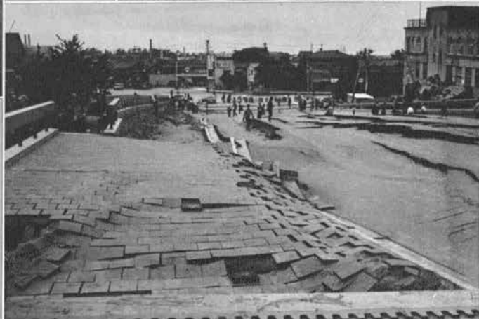
↑ 昭和大橋左岸取付道路横の白山小学校の不等沈下 左側教室と右側体育館との渡り廊下の被害状況
