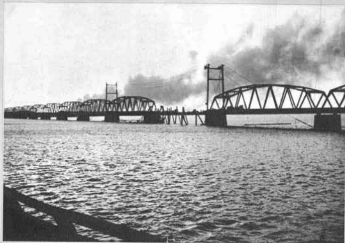
↑ 阿賀野川河口に建設中の新松浜橋の被害(旧松浜橋(木橋流失)上から)上弦材が未完成のスパンが落下しており、その他のスパンが被害を受けている。先方の黒煙は昭和石油の火事である
