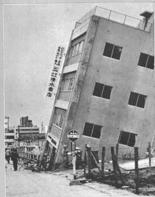
↑明石町1丁目のビル被害 不等沈下極めて大きい
