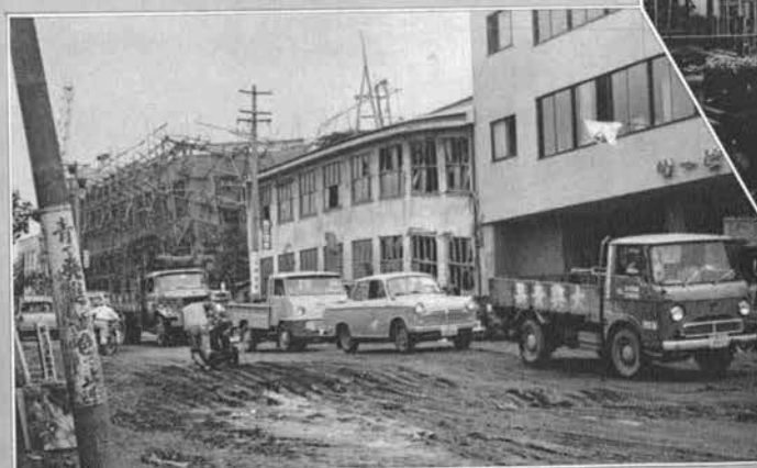
↑明石町1丁目のビル被害 不等沈下極めて大きい
