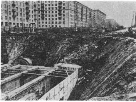
写真-6 オープンカット駅構築組立式セグメント工法 左側にキープ型シールド機が貫通して顔を出している
