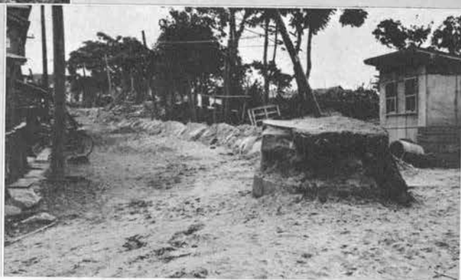
↑ 松浜町における埋設管の浮上 地盤は沈下し、管やマンホールは浮上したということである。
