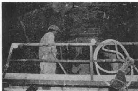
写真-3 目地詰作業台と目地詰機械
