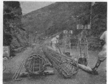
写真-4 加工組立済の鉄筋
