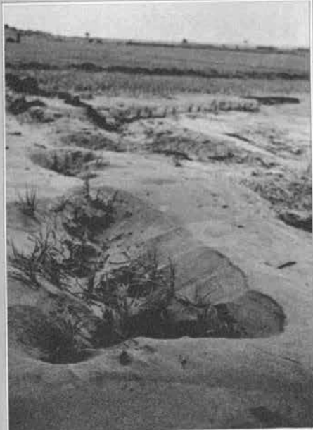
↑水田内の亀裂と土砂の噴出 旧河床に沿って亀裂が入ることが 多いようである。
