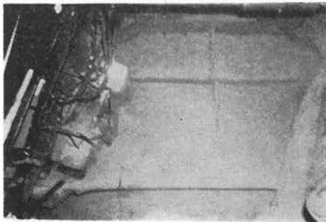
写真-1 ジュグリフスキー線地下鉄工事中の棚式シールドの前進による砂の流入状況
