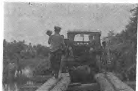
写真-5 危い橋を渡る。このようにして路側にはクリークが続く(ヤナ・ナタウイ間にて)
