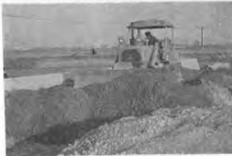
写真-1 盛土工事施工
