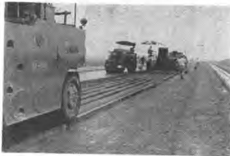
写真-5 ソイルアスファルト舗設
