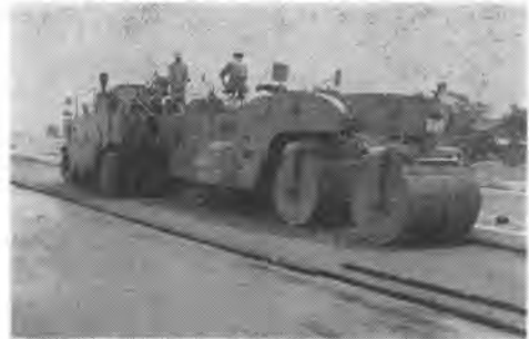
写真-7 密粒度型アスファルトコンクリート舗設
