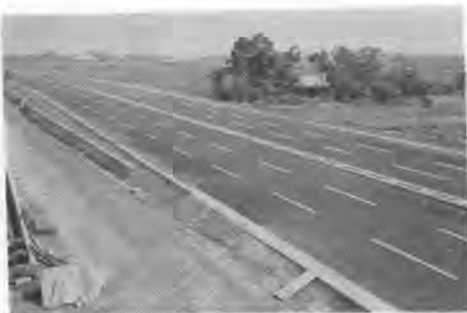
写真—9 一宮市丹陽町地内舗装完成
