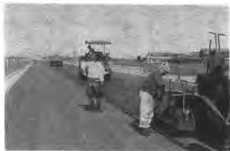
写真—8 滑り止め舗設
