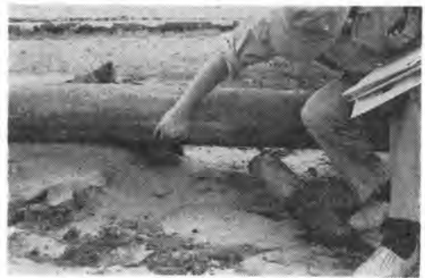
写真-3 地中への分岐管の切断
