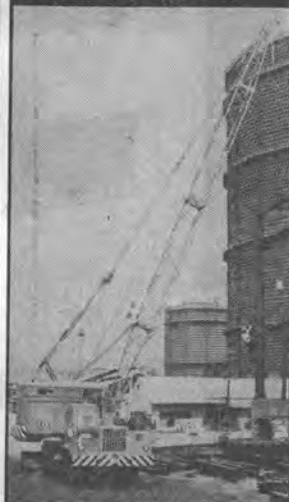
トラッククレーン
