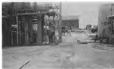
写真-1 ある石油プラントの震害
