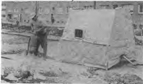
写真-2 Sound tent に入れられたコンプレッサと砕岩機
