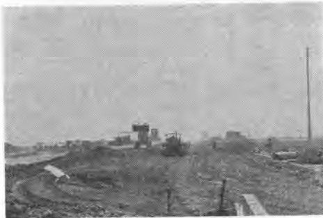
写真-2 盛土工事施工
