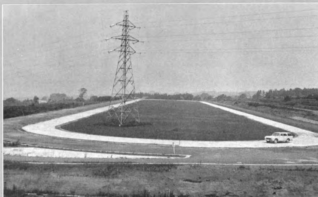
↑ テストコース全景 (東方より西方を望む) 建設機械の走行・けん引試験用テストコースで、1周 700m、直線部 300m、 内側は幅 5m の舗装道路、外側は幅 7.5m の土道である。
