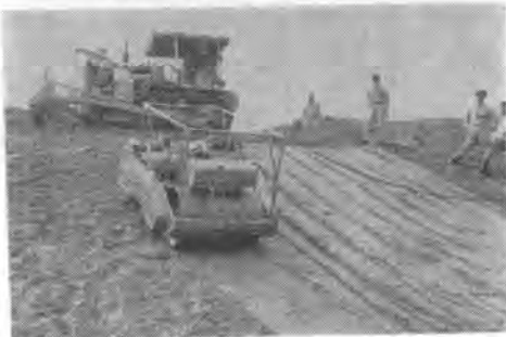
写真-3 淀川左支川現場
