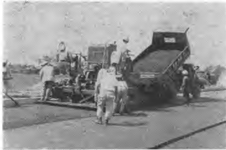
写真-6 粗粒度型アスファルトコンクリート舗設
