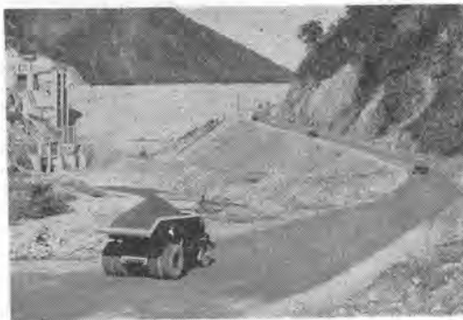
写真-10 運搬道路状況
