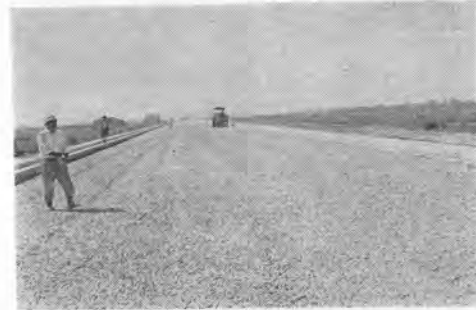
写真-4 クラッシュラン(上層路盤)
