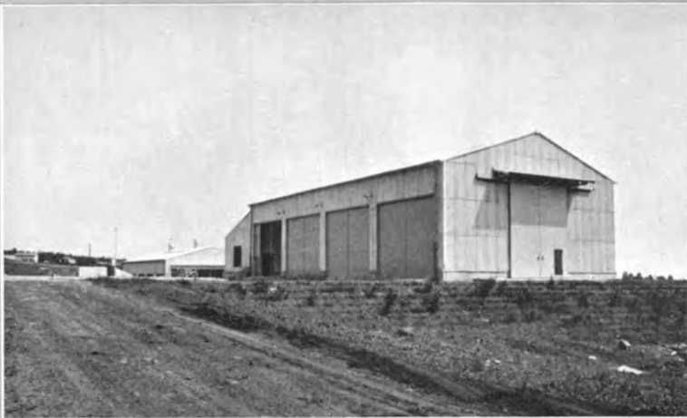
↑ 格納庫 (鉄骨スレート, 330m 2 )
