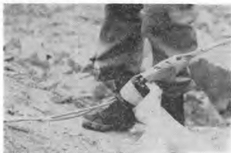
写真-4 Slurry 用ブースタ
