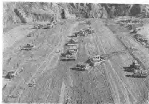
写真-9 土質しゃ水壁盛立状況
