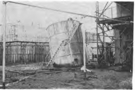
写真-2c 小型タンクの震害
