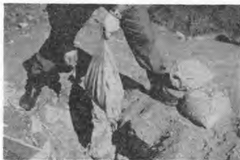
写真-3 Slurry 装薬中
