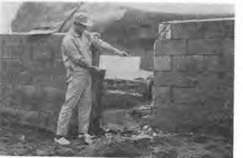
写真-5 地割れに沿った防油堤の切断
