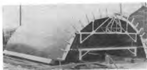
写真-7 上部半断面用ノンテレスコピック形 スチールフォーム
