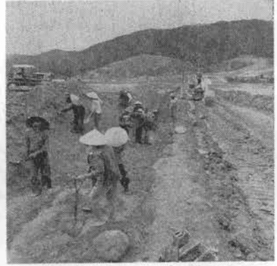
写真-7 シートパイル側面盛土転圧
