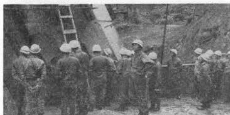
写真-3 金山ダム堤体基部の工事現場を見学する会員
