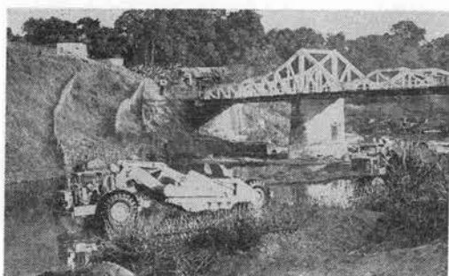
写真-2 立派な橋りようがあるけれども自重36tのスクレーバの通過は許されず河床横断の一コマ
