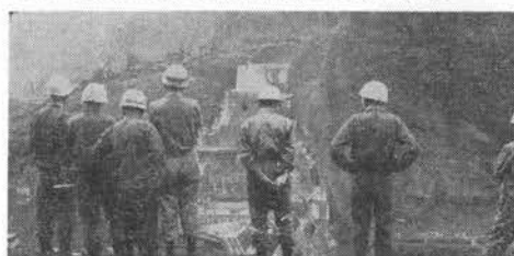
写真-4 金山ダム堤体コンクリート打込みを見学する会員
