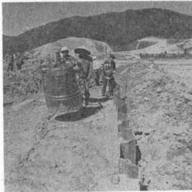
写真-6 シートパイル側面盛土転圧
