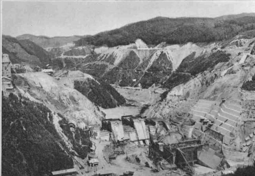
←ダム全景 (下流側から望む) (コンクリート打設20万m 3 ) (昭和38.4.1)
