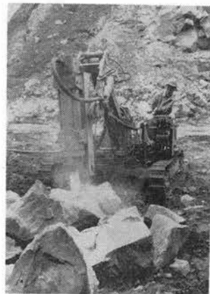
写真-3 小割り作業中のクローラ・ブレイカ
