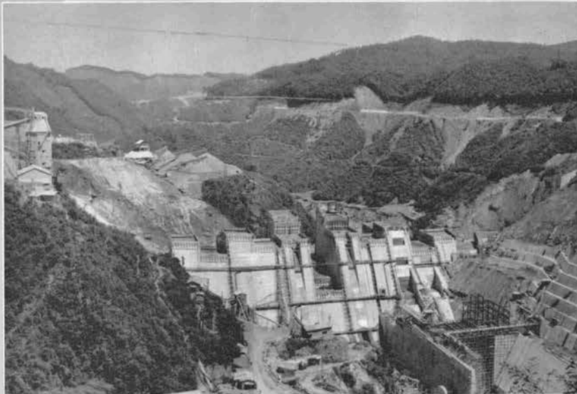
← ダム全景 (コンクリート打設50万m 3 ) (昭和38.9.1)
