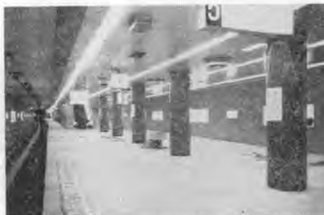
写真-2 完成した銀座駅ホーム
