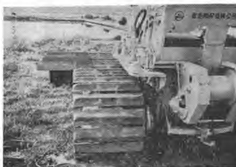
写真-11 アングル延長シューの取付け
