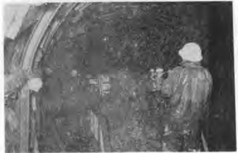
写真-7 先進導坑のずり積み
