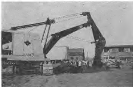
写真-2 LS-78 ショベルクレーン
