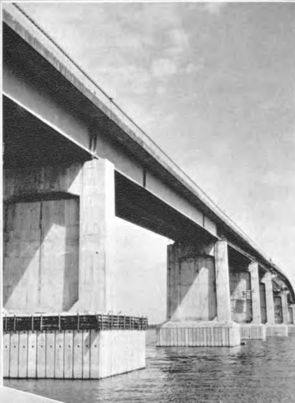
↑橋脚フーチングより下には銅管が見えないようにPC版のスカートが施工されてゆく。
