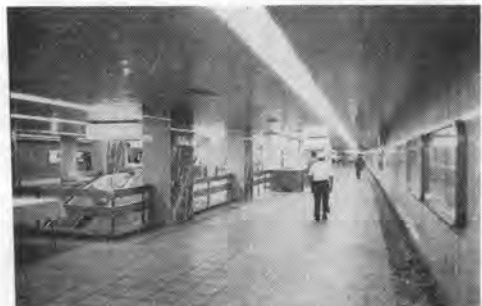
写真-3 完成した地下歩道（銀座駅地下1階付近）
