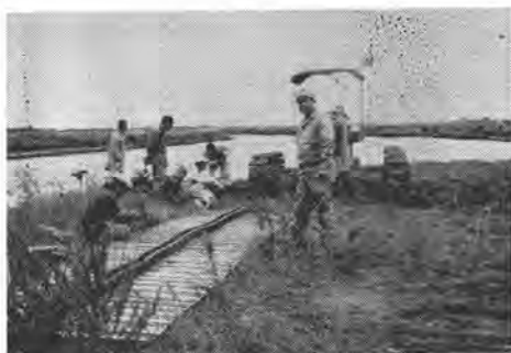
写真-10 超広幅履帯とはき替え作業
