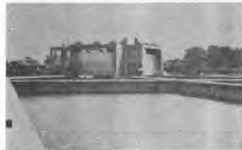
写真-4 たん水した沈砂池
