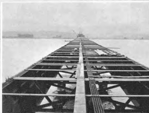
↑合成桁は殆んど架設を終わる。遠くに中央部箱桁架設用の塔柱が立てられている。
