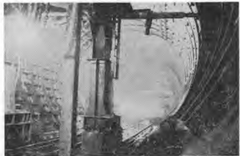
写真-5 シールド工法によるセグメント組立状況
