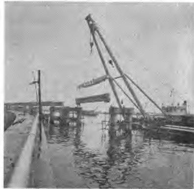
写真-10 起重機船による桁架設
