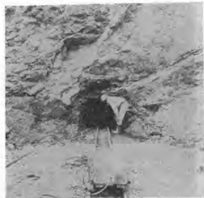
写真-2.1 坑道大発破の坑道掘り
