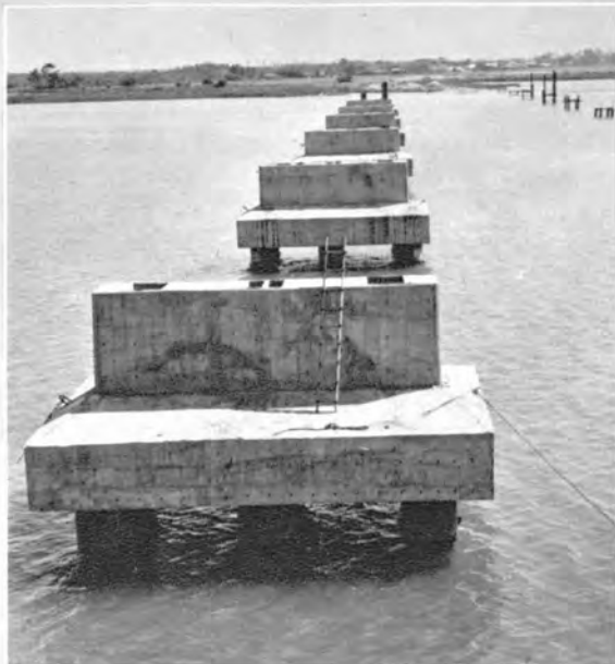
↑合成桁部の橋脚が着々とでき上ってゆく。
