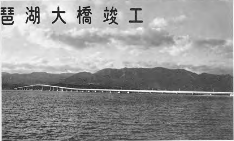
↑ 全く竣工した琵琶湖大橋の全景 対岸の山々は比良の山々である。
