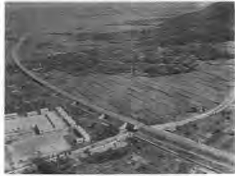
写真-4 関ヶ原付近の完成路盤
