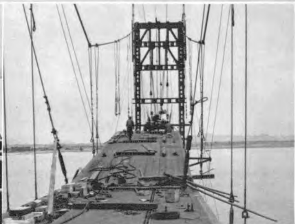
↑中央箱桁部サイドスパン95mのケーブルエレクション。すべてケーブルで行ない台風期までに中央は閉合しなければならない。
