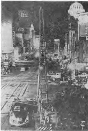
写真-5 銀座付近の工事状況(1)(アースドリルによる鉄くい建込作業)
