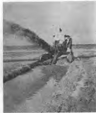
写真-14 作業中のヨークデッチャ(ヘドロ地盤上)
