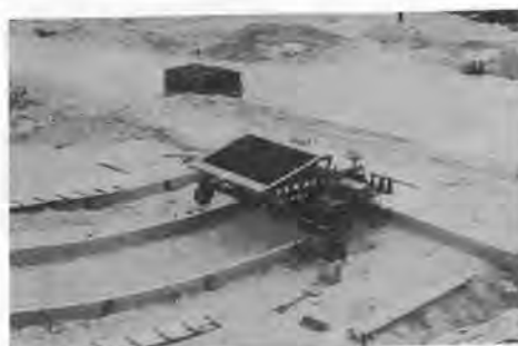
写真-3 法面コンクリートフィニッシャ
