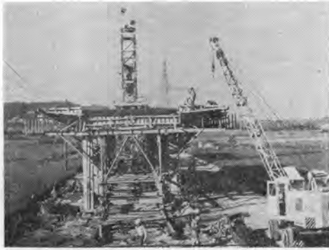
写真-5 高電高架橋の移動式支保工
