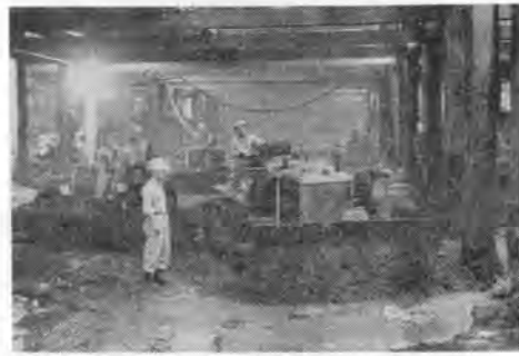
写真-6 銀座付近の工事状況(2)(ブルドーザによる掘削作業)
