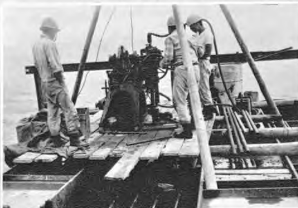
↑ 架橋地点の地質調査が数多く実施された。
