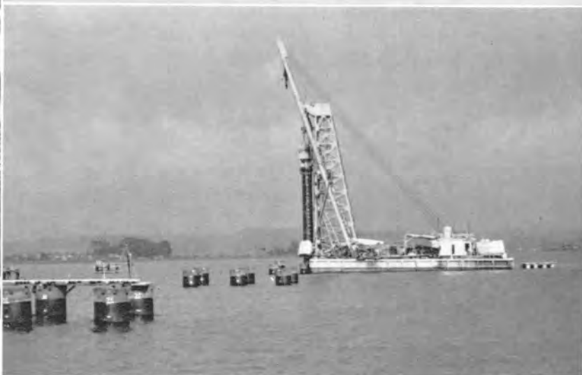
↑くい打船が次々と移動し能率的に くい打作業は進む。
