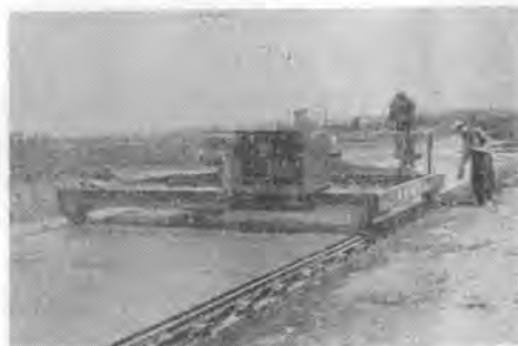
写真-2 縦方向仕上機の一例
