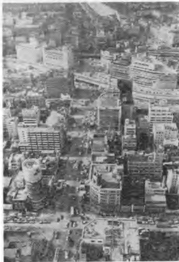
写真-1 日比谷線の全線開通とメトロセンターの完成を目指して工事中の銀座通り
