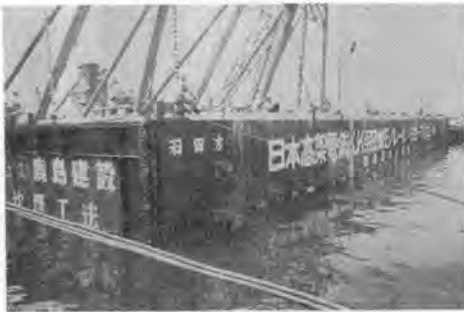
写真-4 沈埋函施工状況
