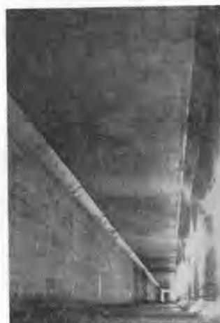
写真-3 朝霞水路内部
