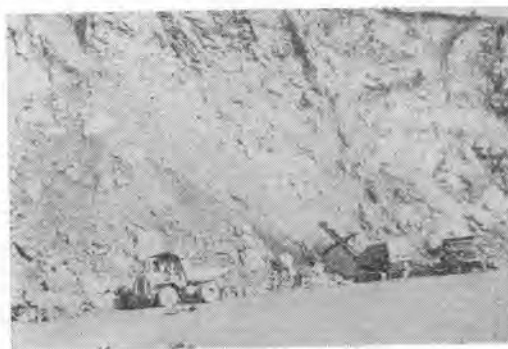
写真—3 トラック積込み
