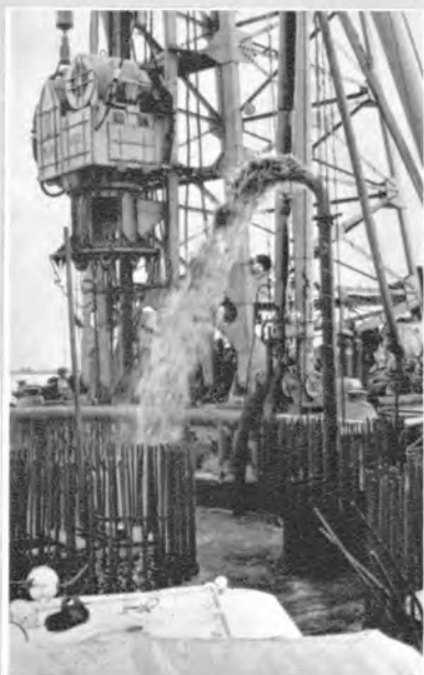
↑打込まれた大径鋼管くいは ジェットポンプによって中の土 砂が排出される。
