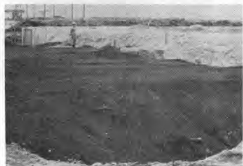
写真-2 路床材料搬入転圧中
