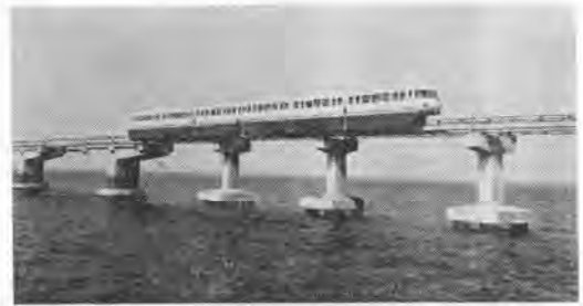
写真—1 羽田線モノレール完成状況
