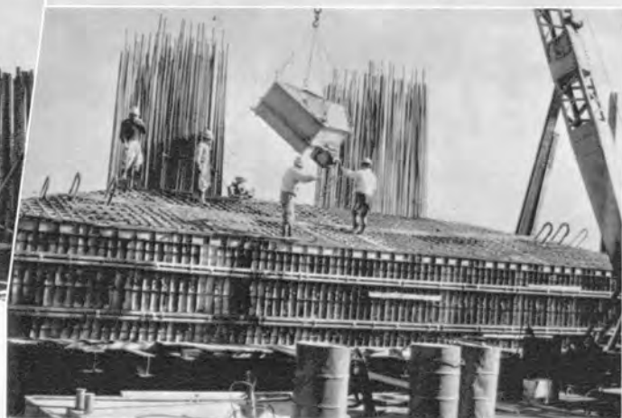
↓橋脚のコンクリートが打設される。
