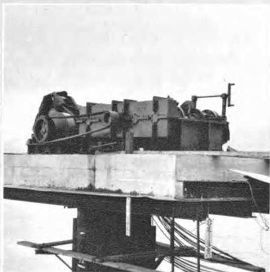
↑大径鋼管基礎の強制振動試験
