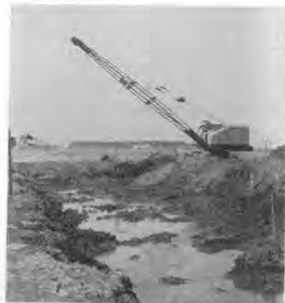
写真-1 埋立地掘削中のドラグライン
