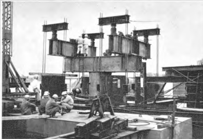
↑日本では初めての 大径鋼管基礎であり大々的 に荷重試験が実施された。 (鉛直載荷試験)
