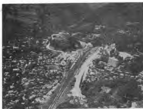
写真-2 丹那トンネル付近
