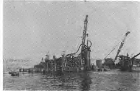
(a) 基礎施工状況
