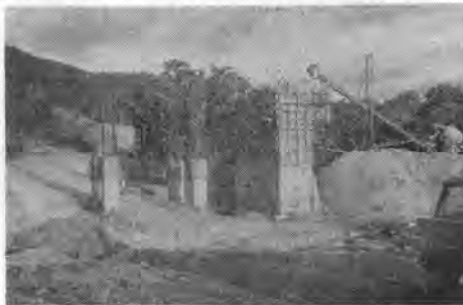
写真-6 彦根付近の橋台コンクリート打ち
