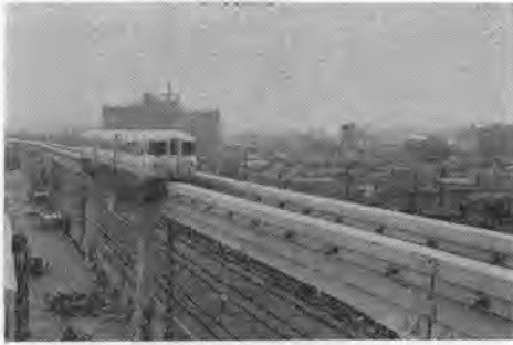
写真-7 国鉄沿い鋼軌道桁
