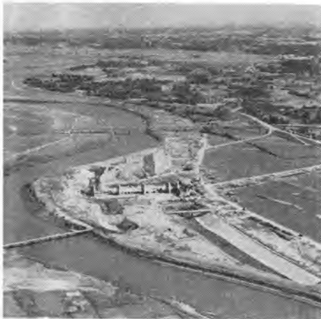
写真-1 荒川取水堰工事
