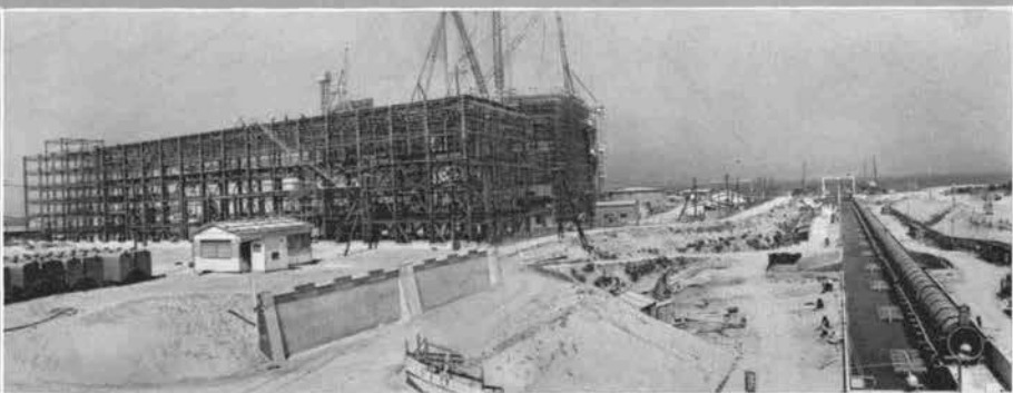
↑37年3月 この発電所の心臓部ともいえる原子炉圧力容器のつり込みが6個に輪切りされた底の部分から始まった。
