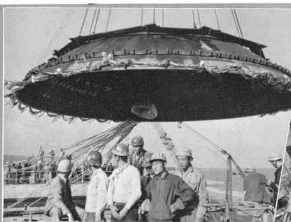
37年11月 原子炉压力容器最後の上の部分がつり込まれている。これで压力容器は直径18.34m、厚さ8cmから9.2cmの完全な球形となった。
