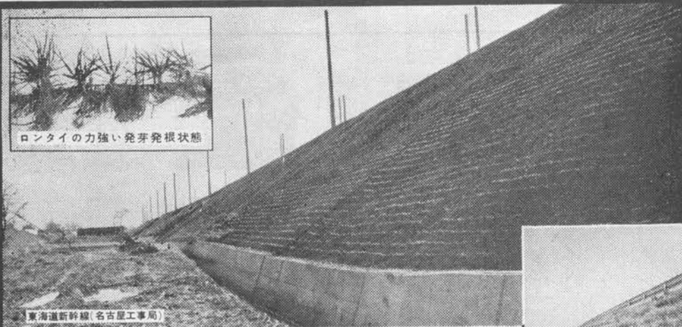
東海道新幹線(名古屋工区)
