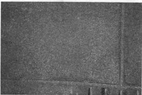
写真-5 スチールセグメント被覆吹付け
