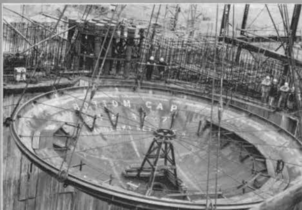
↑37年3月 この発電所の心臓部ともいえる原子炉圧力容器のつり込みが6個に輪切りされた底の部分から始まった。
