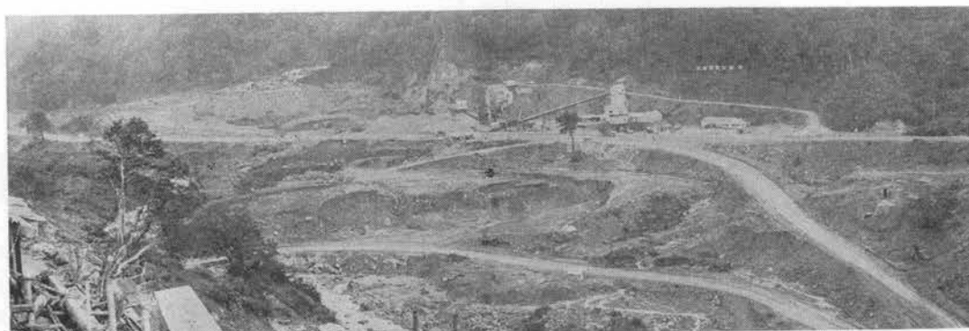
写真-6 右岸から盛立材料運搬高速道路ならびにふるい分けプラント混合設備を望む(38年9月)
