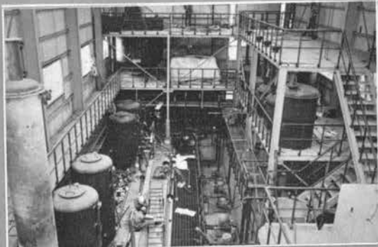
↑39年10月 放射性廃液処理建物内部。この建物で放射能によって汚れた諸機器を洗浄した雑廃液や、クーリング・ポンドから出る水を処理し、安全な水とする。
