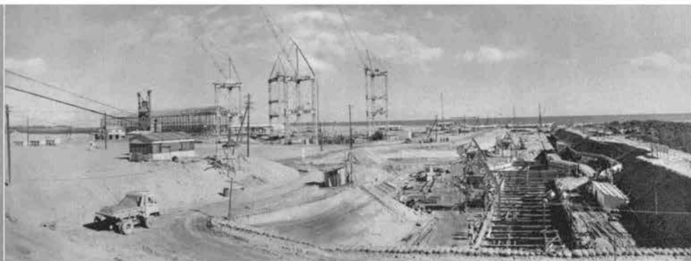
← 36年1月 中央デリックの林立するところが炉心部、右手は冷却用水路の掘削工事、右の鉄骨骨組は熱交換器組立工場。
