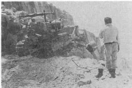
写真-7 岩石蹴落し作業状況
