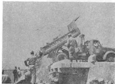
写真-11 岩壁荷卸台からダンプトラックによる石運給への積込み状況
