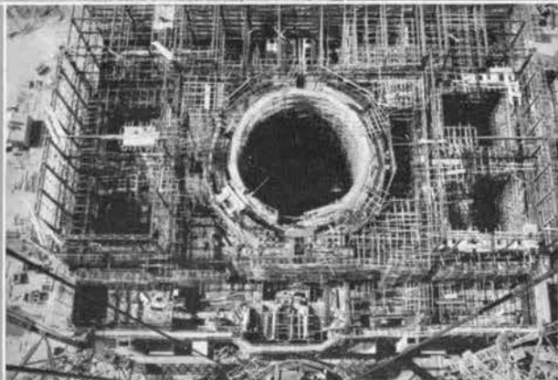
↑37年1月 原子炉建物を上部から見る。鉄骨が組まれ足場がおかれている。まんまの丸い穴が原子炉圧力容器の置かれるところ。その左右二つずつの四角い穴が熱交換器のおかれるところである。
