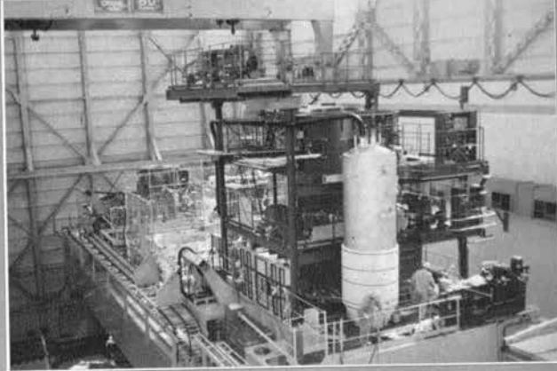
↑39年9月 原子炉建物最上部では燃料交換機の組立が行なわれている。
