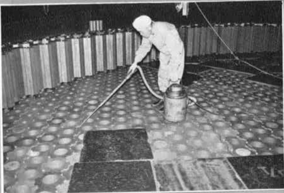
↑39年6月 炉心内の黒鉛減速材の積み込み作業。耐震性を考えての六角模様が見えている。一段約3,000個、計10段積まれる。炉心内部は汚れをさらうので、このように掃除機で常に清浄を保っている。この減速材の中に燃料棒や制御棒が入られる。
