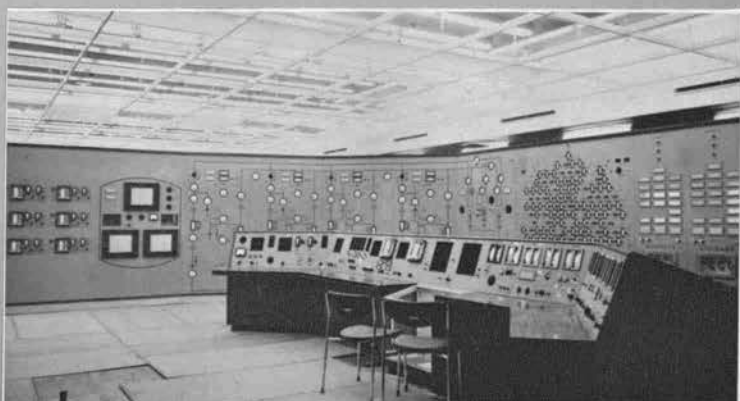
39年6月 原子炉建物内の中央制御室、各計測器の据え付けが行なわれている。
