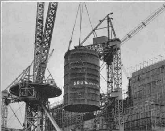
↑37年6月 原子炉建物のコンクリート打も進み、熱交換器のミドル・セクションのつり込みが行なわれている。
