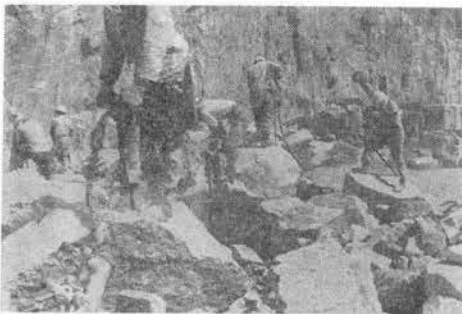
写真-9 ハンドハンマによる小割用さく岩状況
