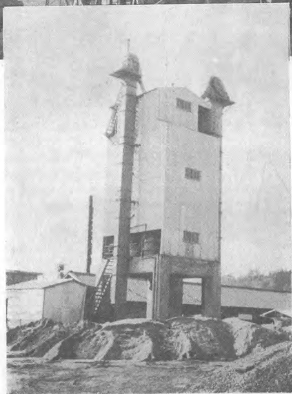
0.6m 3 \times 2型自動式バッチャープラント
