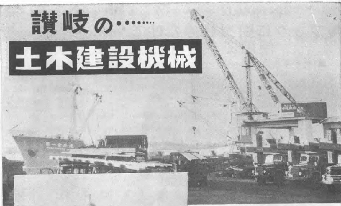
10 \frac{t}{5} t \times 9 \frac{M}{18} M 三脚デリック
