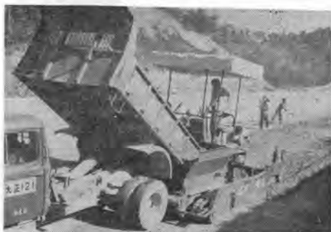
写真-3 アグリゲートスプレッダによる中央混合の路盤材敷均し
