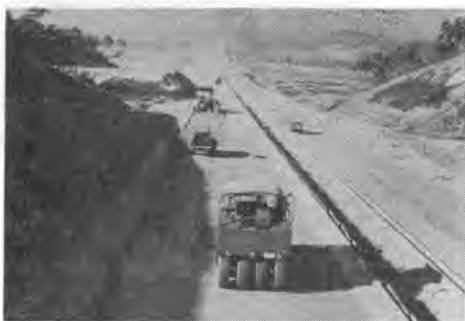
写真-4 タイヤローラによる粒度調整路盤材の転圧
