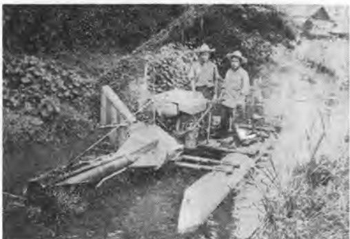
写真-2-㉒ 作業中の小水路改修用掘削機
