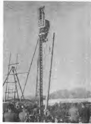
写真-4 くい打機の打込み作業試験
