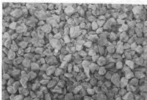
写真-5 主骨材を敷均した状況
