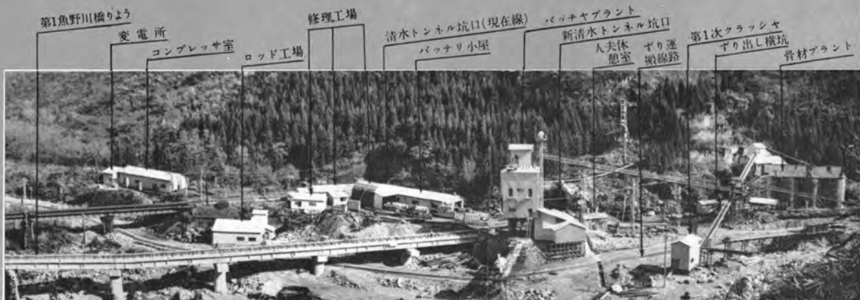
工 区 坑 外 設 備 全 景
