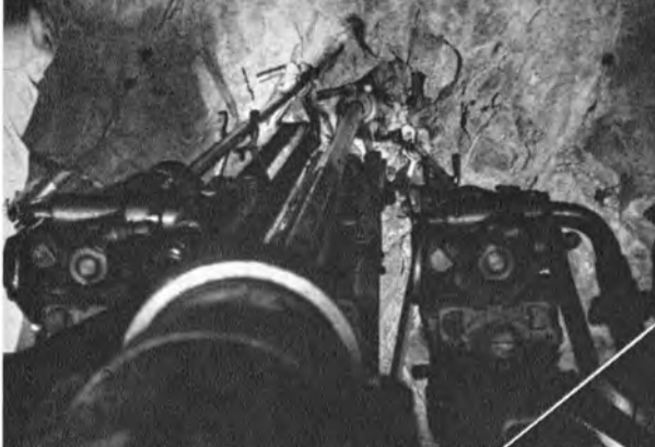
↑ 第 3 工 区 (土樽方) 大口徑さく岩機DH-143によるバ ーンホールのさく孔 (ビットゲー ジ 127mm)
