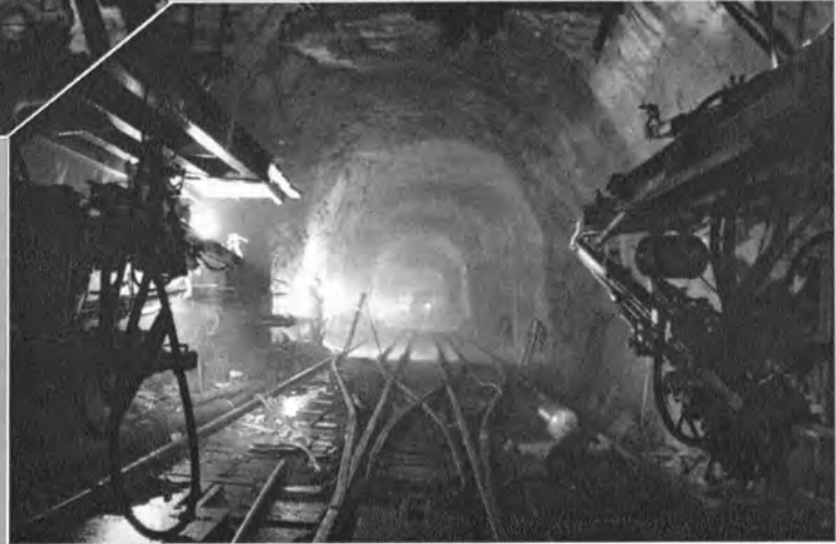
第 3 工 区 (土樽方) → スライディングフロア (L=107m)
