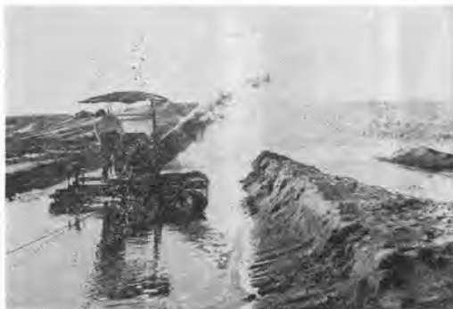
写真-2-㉑ 作業中の小水路改修用掘削機
