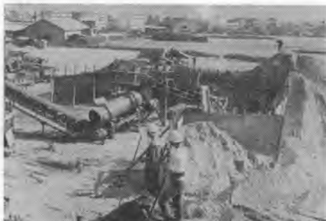
写真—2 ドラムミキサで混合されたものがベルトコンベヤで運搬車に積込まれる
