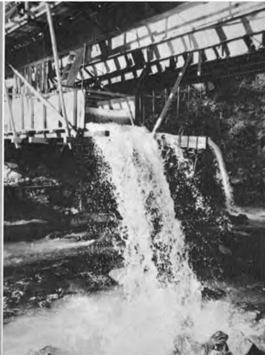
第2工区 (土合口) 斜坑口からの排水 約20m 3 /min
