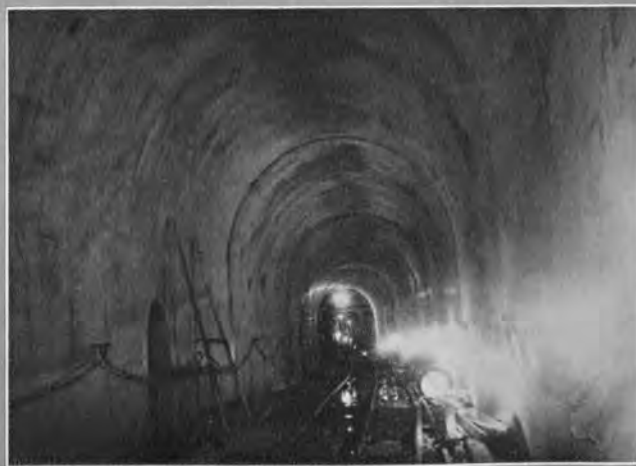
↑第1工区（湯楡曾方） コンクリート覆工完了
