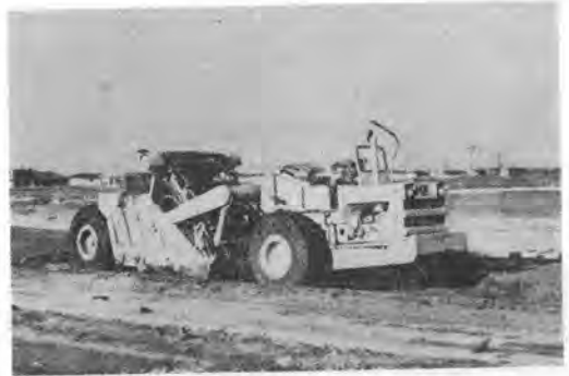
写真-1 エレベータリングスクレーパ
