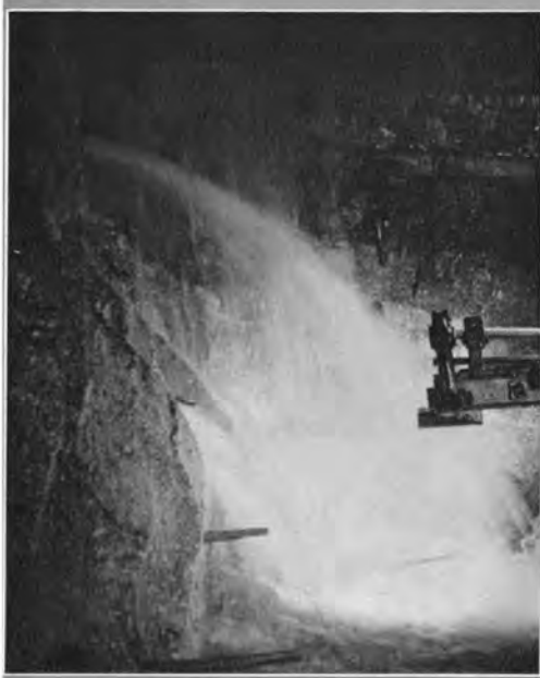
← 第2工区 さく孔切羽から噴出する湧水
