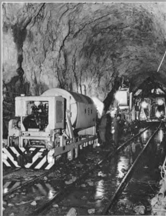
↑第1工区（湯楡曾方） コンクリートポンプ 石川島PK 206型によるコンクリート打設作業
