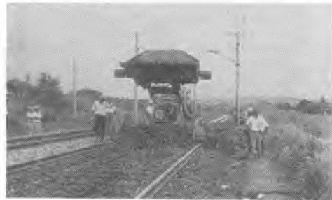
写真-6 作業中のコンベヤ付ドーザ
