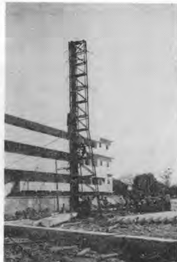
写真-3 手製のくい打ち機でプレキャストコンクリートくいを打っている
