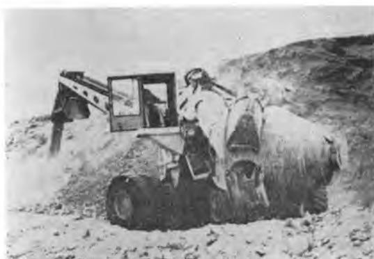
写真-2 Mechanical Excavators 社製 500 yd 3 /hr・タイヤ式・コーン型ホイールエキスカベータ
