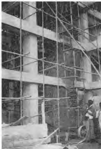
写真-2 本年初めて東パキスタンに現われたパイプの足場
