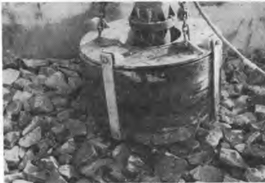
写真-4 陸上における割石層の締固め均し作業
