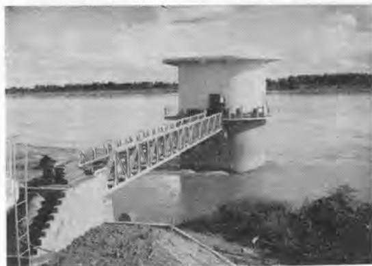
写真-2 ビニンチャン市水道取水塔（ラオス） 久保田水道（株）、三菱商事（株）共同施工
