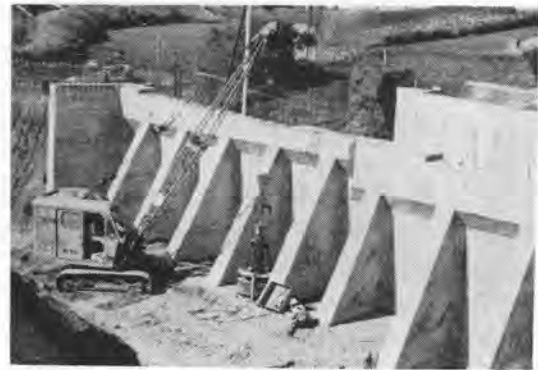
写真-3 裏込め砂の締固め作業
