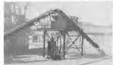
簡易アスファルト乳剤常温混合プラント (実用新案出願No.920) 型式 H.P.A (能力9-12t/H)
