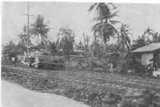
写真-5 パシコッタ〜ナゴムバトム間道路建設(タイ) 日タイ建設(株)、西松建設(株)共同施工
