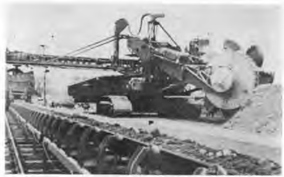
写真-3 Orovilleダム工事におけるホイール エキスカベータ (McDowell 社製)
