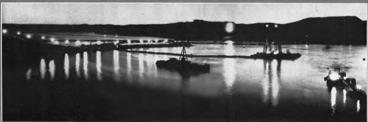
↑ 堤体工事夜景（初期）
