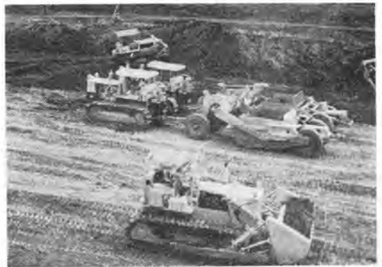
写真-1 愛鷹試験盛土で施工中の NTK-6 バケットドーザ
