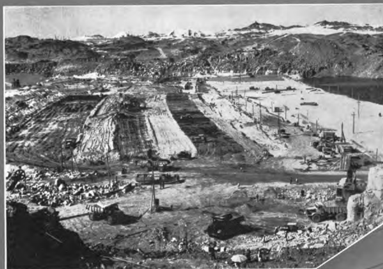
↑堤体中央部の盛立
