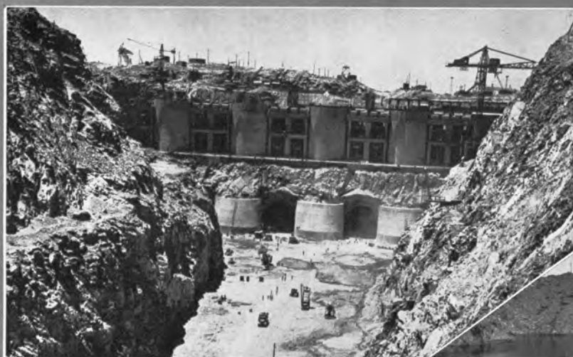
↑取水口および上流部水路 トンネル入口が上部と下部に分れている。
