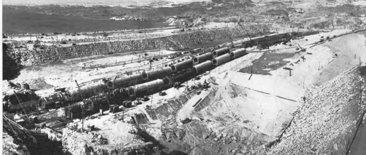
↑アスワンハイダム地点全景 左方が上流、左側はギャラリーの工事、
