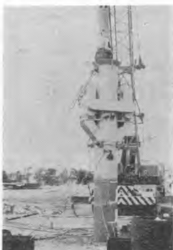
写真-1 三菱パイプロハンマで打込中
