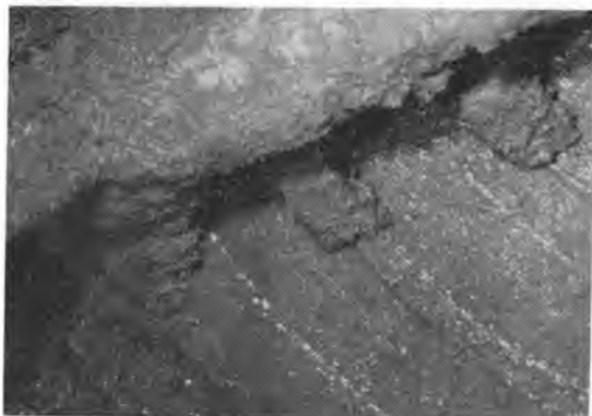
写真-4 3.05 mφ 機械化シールドによる掘削状況
