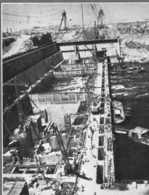
↑発電所工事の現況 右方が下流
