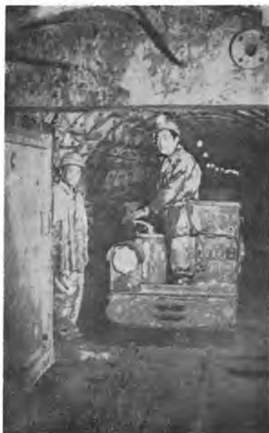
写真-2 エアロック扉付近
