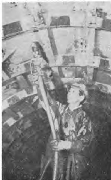
写真-3 裏込め注入ホース取付け
