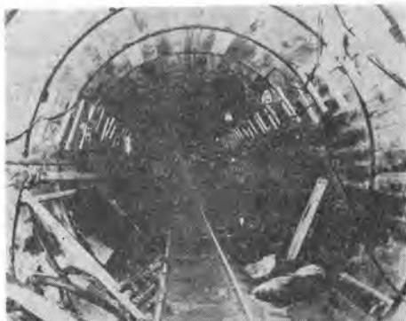
写真—3 トンネル内部 シールド型わく組立て状況
