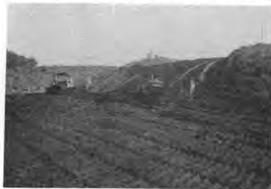
写真-1 横断方向転圧状況および敷ならし
