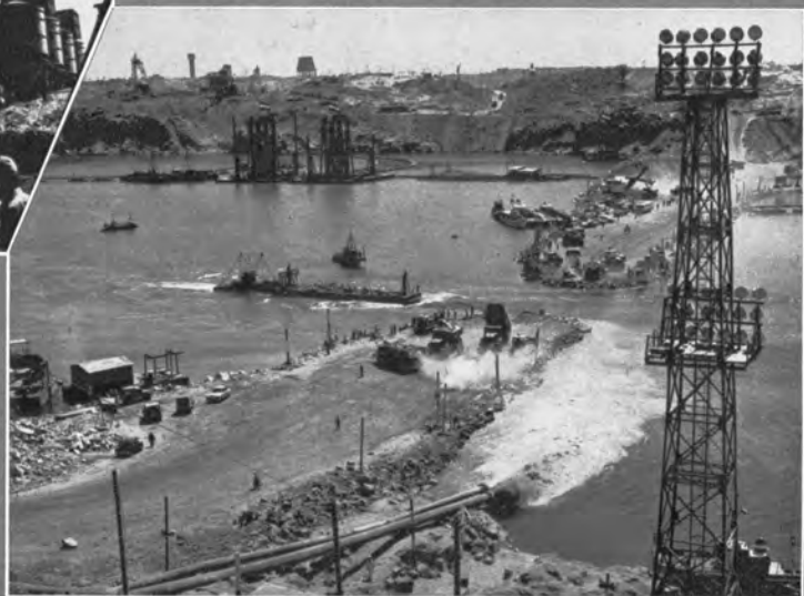
→ ナイル本流締切工事 左側上部はパイプレーションプラント
