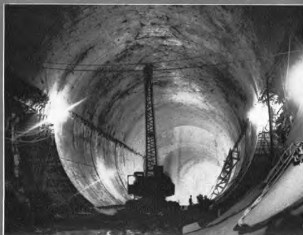
← 発電用水路トンネル内部 延長 282m, 内径 15m コンクリートライニング厚 1m
