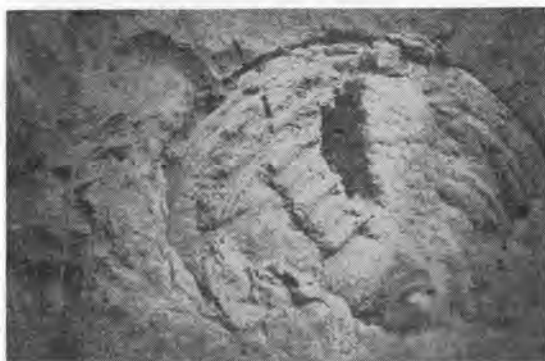
写真-2 IHI 1号機完全機械化シールドによる掘削状況
