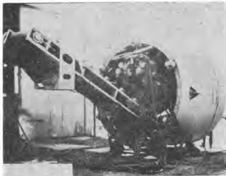
写真—2 9 ft 直径トンネル掘削機 トンネル型わく組立て用の後部防護機械筒を取りはずした状況，推進用シリンダ，2組の油圧モータ付
