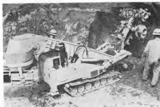
写真-1 川崎 KSE 15 型スクリーエクスキャバータ
