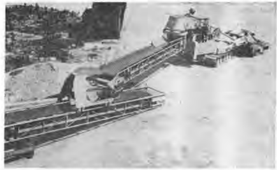
写真-2 排土用ベルトコンベヤ
