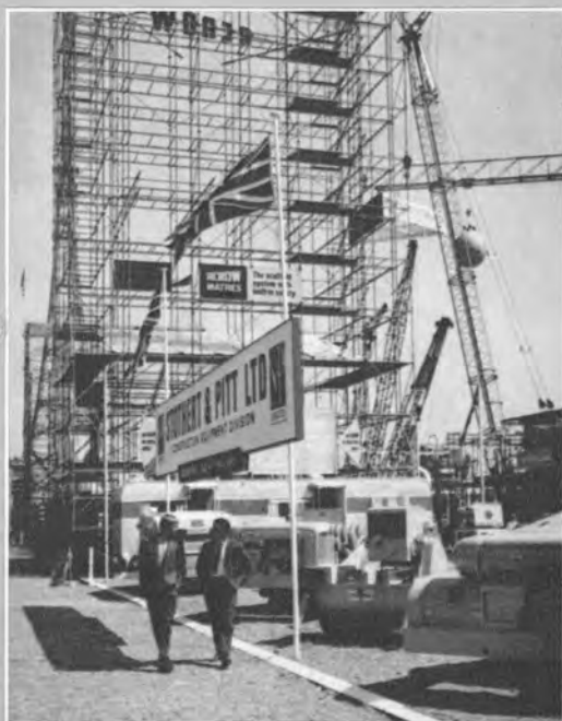
↑会場入口付近の風景 後方はアクロウの鋼製足場
