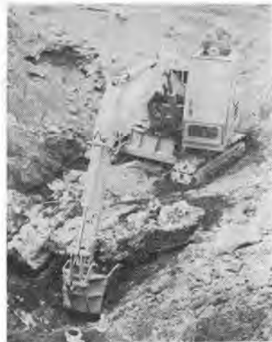
写真-2 作業中の日立 UH 03 油圧ショベル
