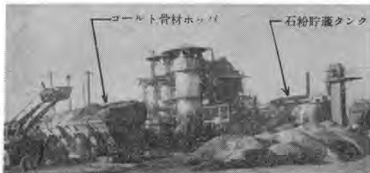
写真-2-1 骨材集積地からコールドホッパへ搬入
