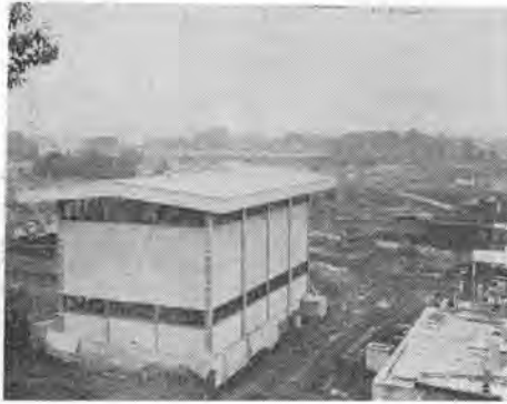
写真-2 原水連絡仮設ポンプ場
