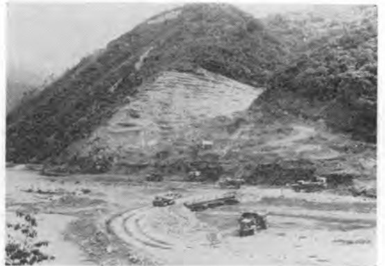
写真-2 ダム上流左岸掘削状況(表土はぎ)
