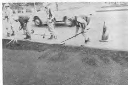
写真-3-3 縦ジョイント施工(板レーキ, 加熱コテ仕上げ作業)
