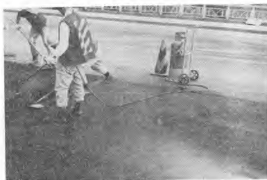
写真-3-2 横ジョイント施工(プロバシバーナ, 加熱コテ仕上げ作業, アスモルタル仕上げ)
