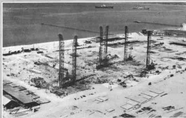
↑ プライ火力発電所建設現場 (1965年3月撮影)
