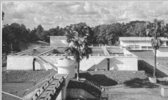
↑ ビエンチャン市水道浄水場全景(取水塔上屋より)
