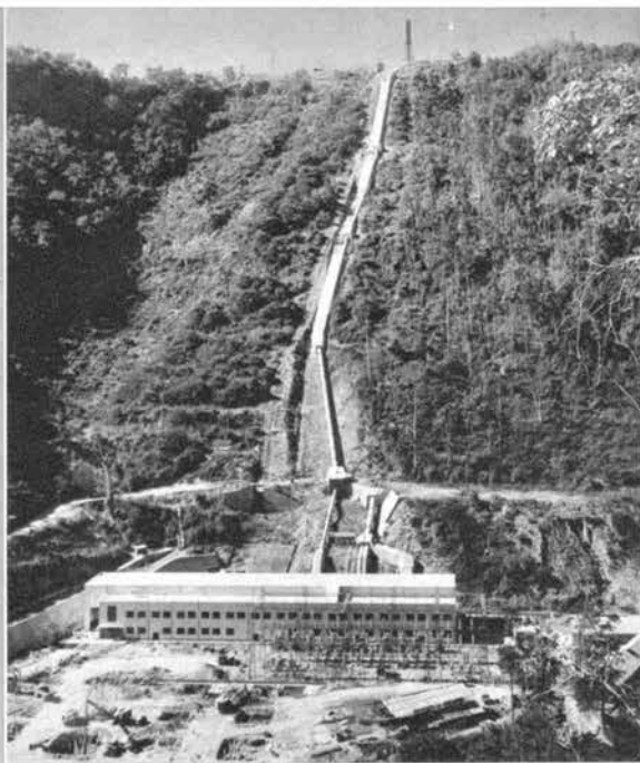
↑ バルチャン第2水力発電所全景
