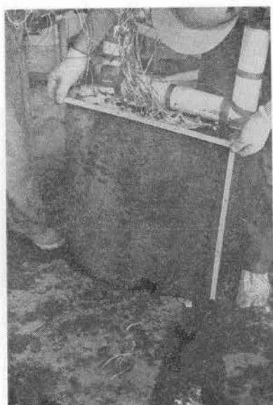
写真-1 連続型凍結管による土砂の凍結状況
