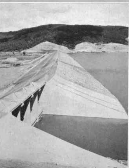
↑ 完成直前のダム(1963年9月)
