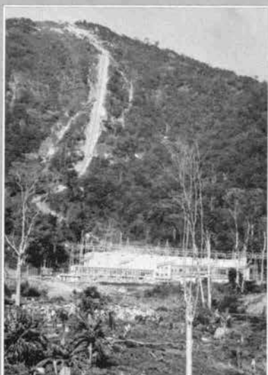
↑ 鉄管路と発電所建物
