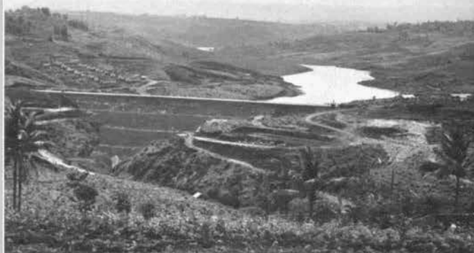
↑ 完成したコッファダム
