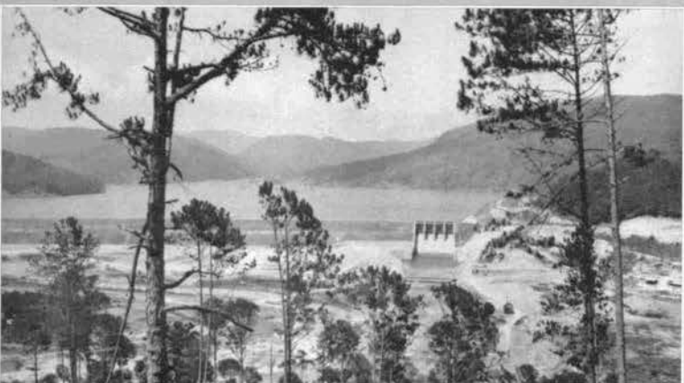
↑ 完成したダムおよび余水吐
