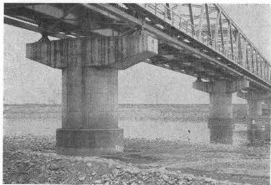
写真-3 橋りょうのけた下空頭は洪水に対し十分安全に構築されている
