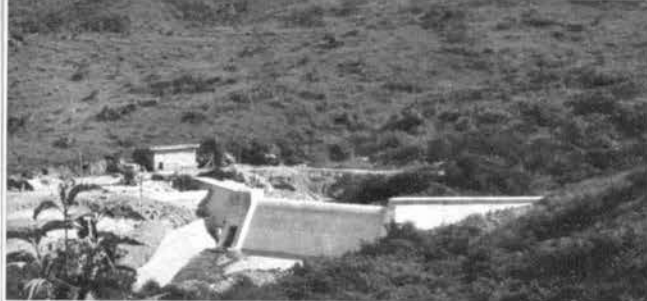
↑ 取水口 ○C の完成状況
