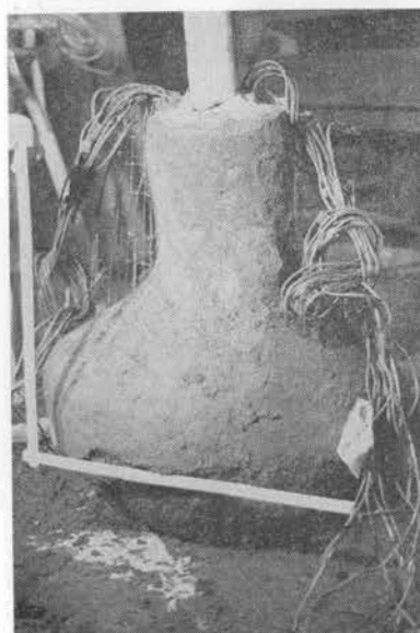
写真-2 直接放出型凍結管による土砂の凍結状況
