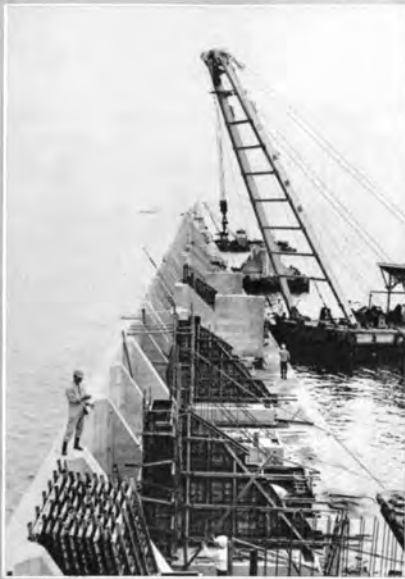
鍋田部土砂堤における 鋼矢板打込み
