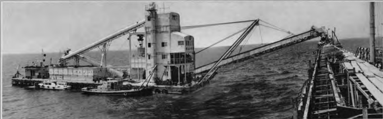
↑コンクリート混合船による ケーソン上の擁壁コンクリート打設状況
