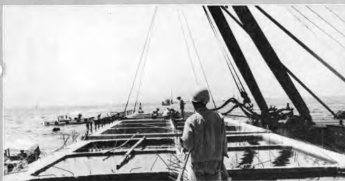
↑ケーソン据付け状況の検査
