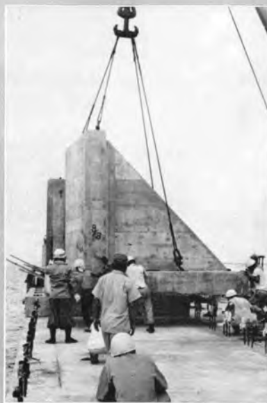
左 開口部用プレキャスト擁壁製作中 中 開口部におけるプレキャスト擁壁据付け作業 右 鍋田部土砂堤におけるポンプ船による盛土
