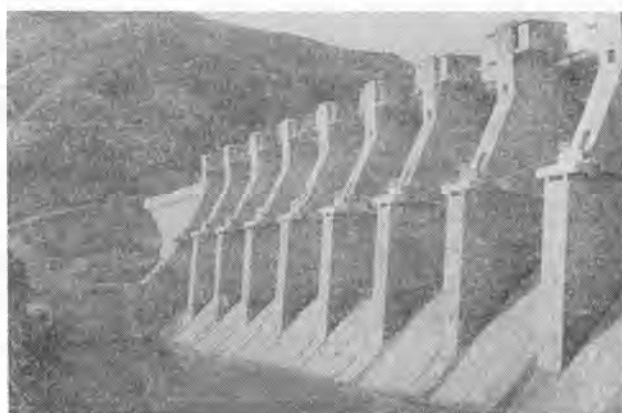
写真-3 春川水力発電所ダム(高さ40 m、幅435 m)
