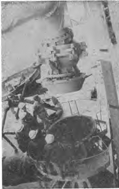
写真-2 海上管とサンドキャリア積込み管との接続部
