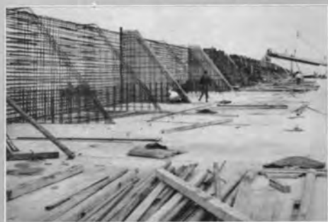
↓ケーソン上の擁壁 コンクリート鉄筋組立て
