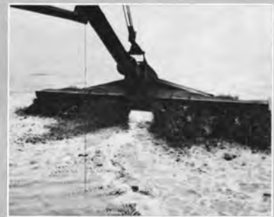
↑ 砂まき船による敷砂 (鋼 215 t ディーゼル 220HP 410m 3 /hr)
