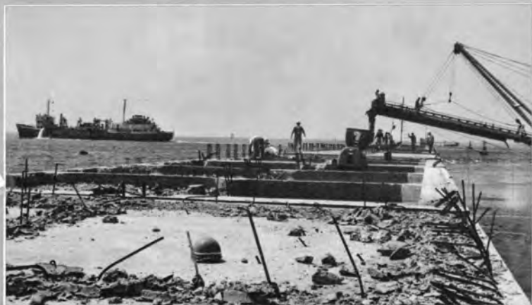
↑ケーソン据付け状況の検査
