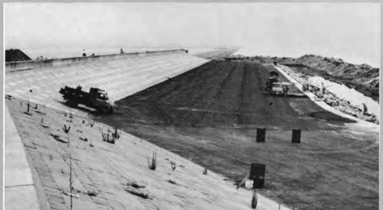
↑ 鍋田堤と干拓堤防との取付部の のり面保護およびアスファルト舗装
