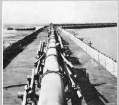
左 開口部用プレキャスト擁壁製作中 中 開口部におけるプレキャスト擁壁据付け作業 右 鍋田部土砂堤におけるポンプ船による盛土
