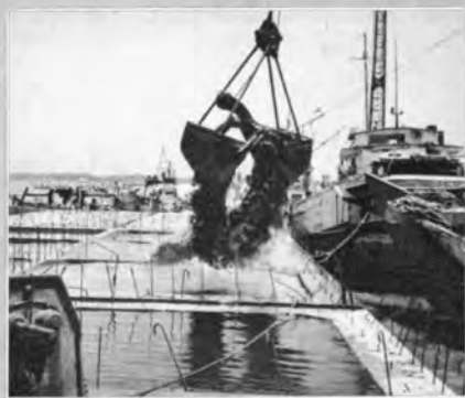
↑ガット船によるケーソンへの砂中詰め
