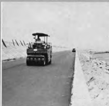
↓ 鍋田部土砂堤における背面 アスファルト舗装作業
