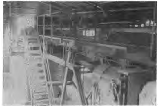
写真-4 電気式緊張装置のついたヘッド部
