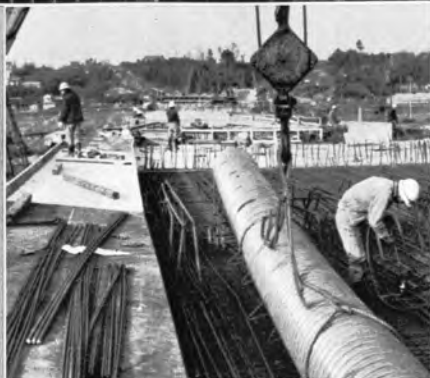
→ 穴あきスラブの円筒型 わくと鉄筋の組立て
