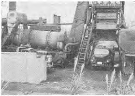
写真-5 アスファルトプラント
