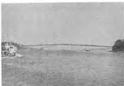
写真-4 第3号橋全景
