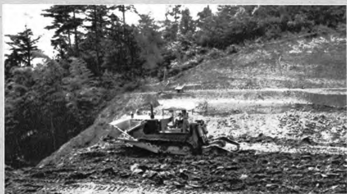
↑リッパによる掘削
