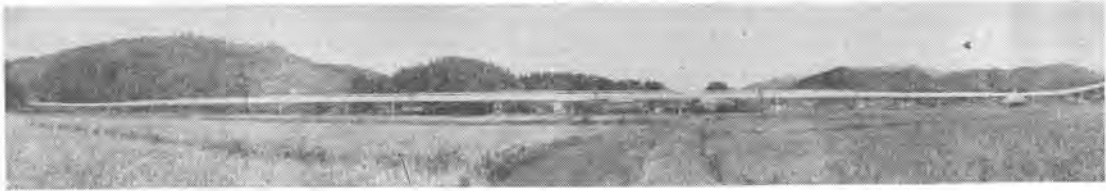
写真-1 No. ベルトコンベヤの一部
