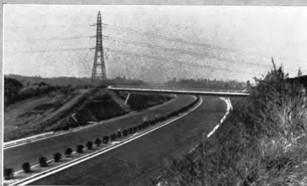
↑完了した表層 (アスファルトコンクリート4cm)
