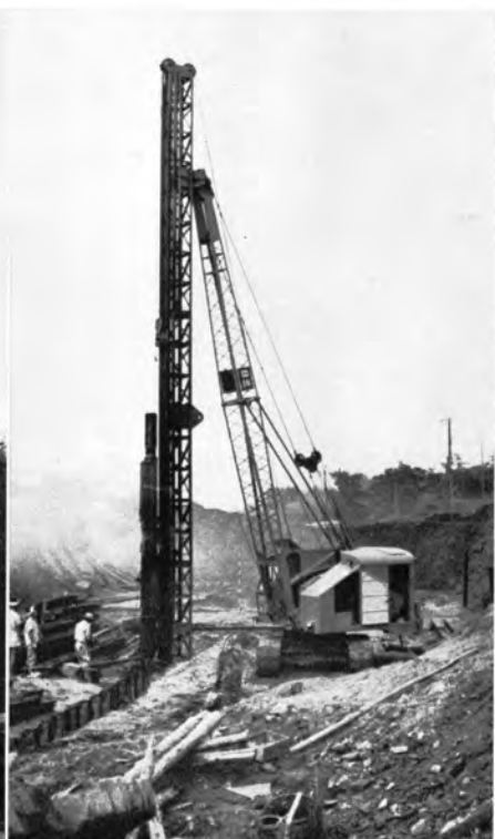
↑鋼矢板を打込む ディーゼルパイルハンマ
