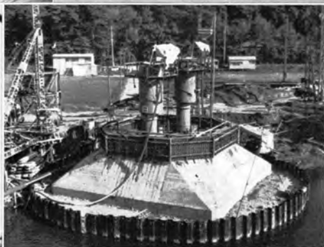
↑ 長径間橋りょう基礎として 施工されているニューマチックケーソン
