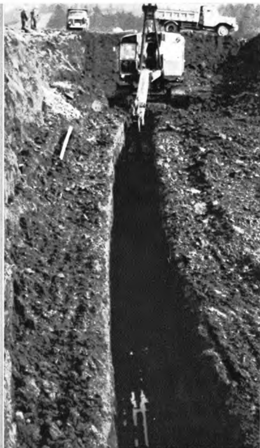
↑掘削搬土に先立ち地山の含水比を低下させるためにトレンチカットを行なっているドラグショベル
