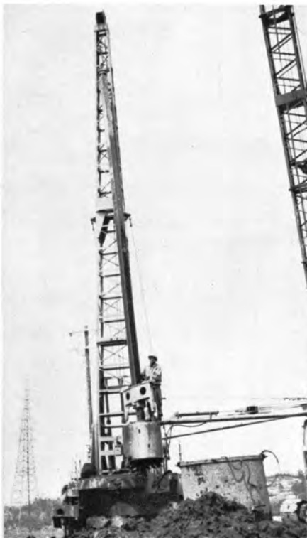
↑現場打ちコンクリートぐい施工のため 軟弱平地を掘削しているアースドリル
