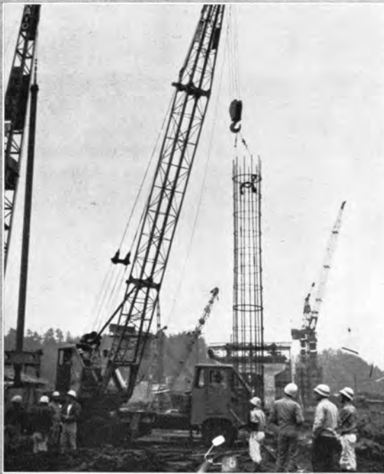
↑ぐいの鉄筋建込みや資材の 運搬に大活躍するクレーンの群
