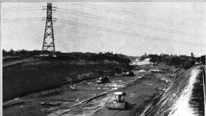
↑搬入された山砂による路床の築造
