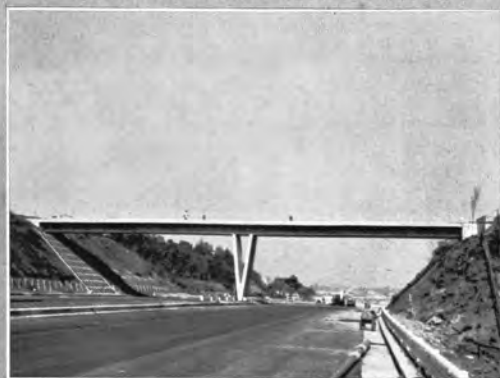
↑ 完成したV形橋脚の跨道橋
