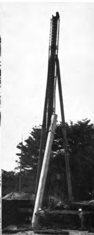
↑既製コンクリートぐいを 打込むデルマック
