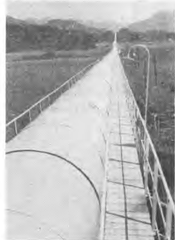
写真-2 ベルトコンベヤの一部
