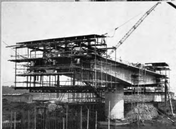
↑ フォールパワーゲンで施工されている ディバダグ工法のPC橋(鶴見川橋りょう)
