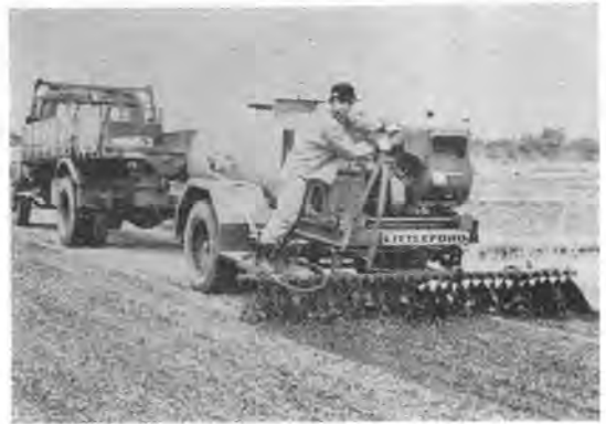
写真-1 ディストリビュータ作業状況
