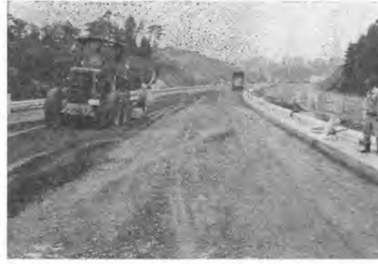
写真-4 下層路盤工
