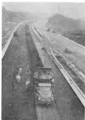
写真-6 表層舗設工
