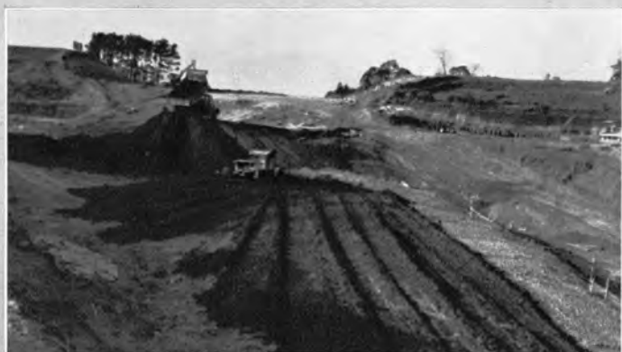
↑ダンプトラックで運搬されたロームをうすくまき出しているブルドーザ
