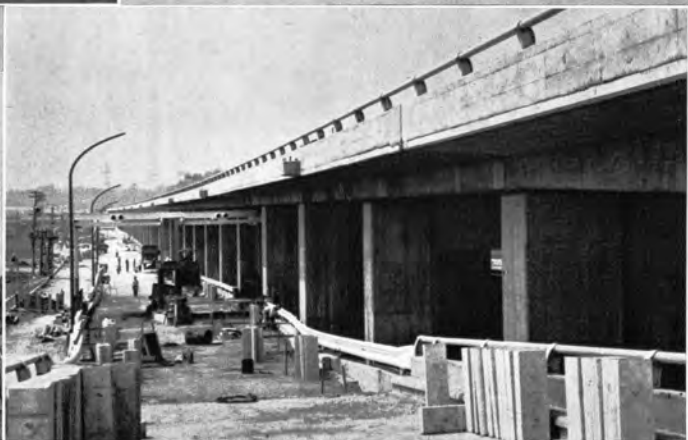
↑ 完成した穴あきスラブの高架橋(川崎高架橋)
