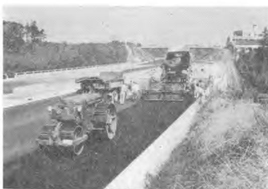
写真-7 表層舗設工
