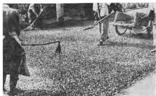
写真-3 カチオン乳剤散布後、ただちに第2層の碎石の敷きならし
