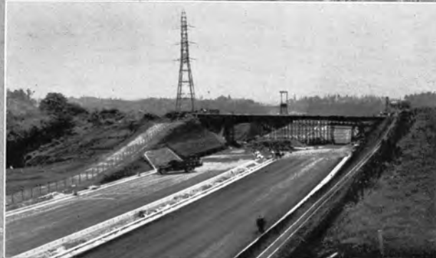
↑完了した上層路盤 (上層路盤は鉱滓または山砂をアスファルトで安定処理し2層に分けて厚さ10cmに仕上げる)
