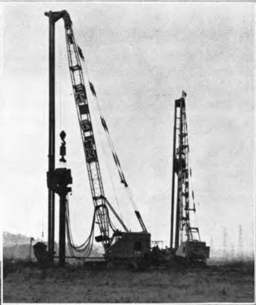
↑軟弱地盤の盛土基礎としてサンド パイルを施工しているパイロパ イルハンマとクローラクレーン
