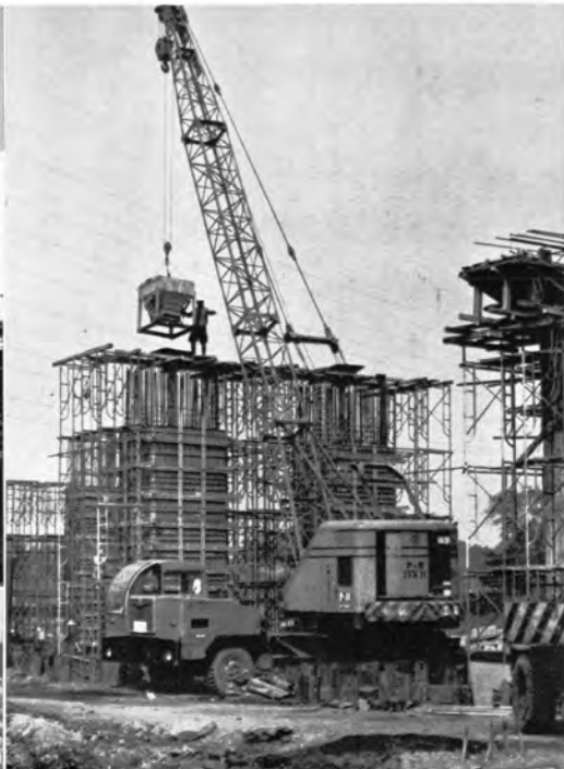
↑ トラッククレーンによる 高い橋脚のコンクリート打設作業
