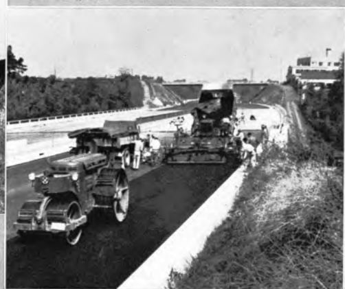
↑基層 (アスファルト コンクリート6cm) の舗設作業
