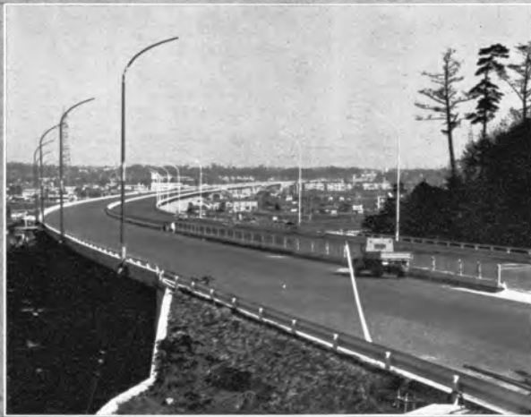
↑完成間近い川崎高架橋
