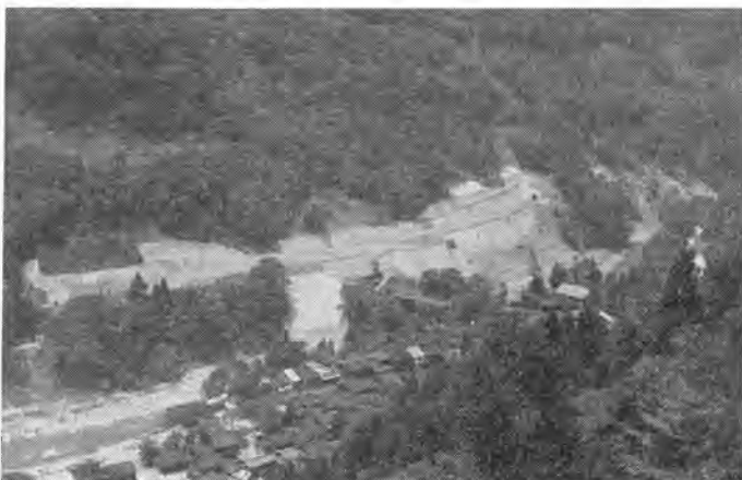
写真-2 神岡線茂住停車場付近
