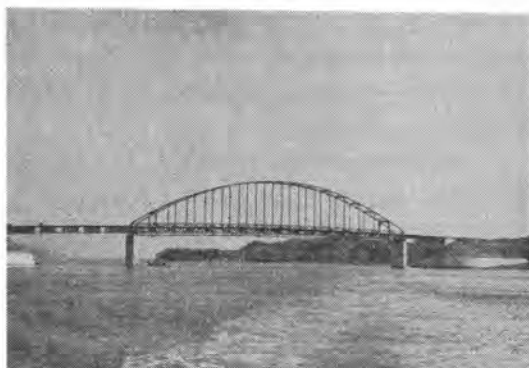
写真-3 第2号橋全景
