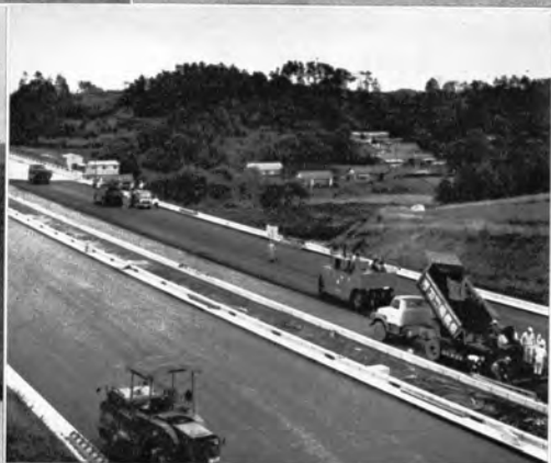
↑上層路盤を舗設するフィニッシャ、 絶え間なく転圧するタイヤローラと 三軸ローラ
