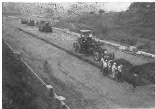
写真-3 下層路盤工
