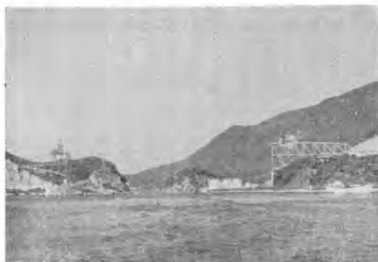
写真-1 工事中の第1号橋
