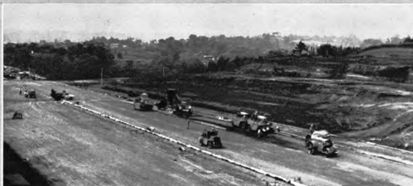
↑搬入された山砂による路床の築造
