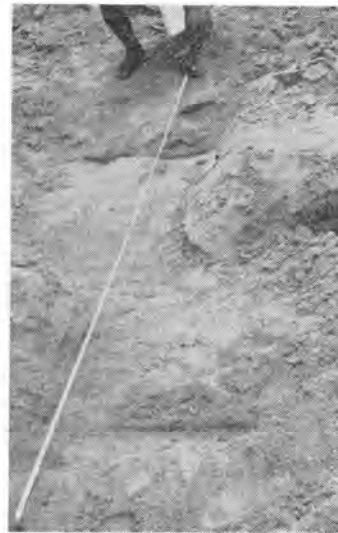
写真一2 3本掛け作業によるリッピング破砕状況
