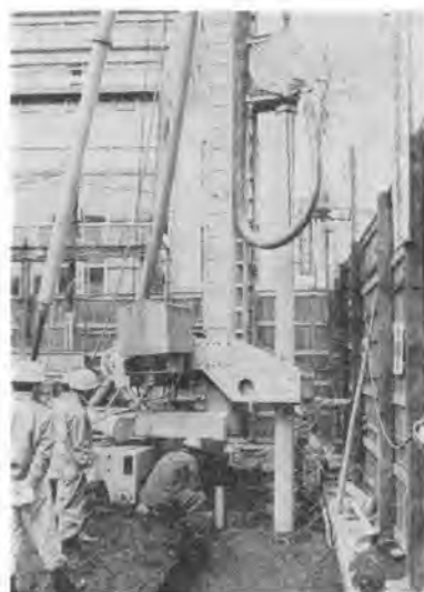
写真-3 施工中のプレボーリング機械
