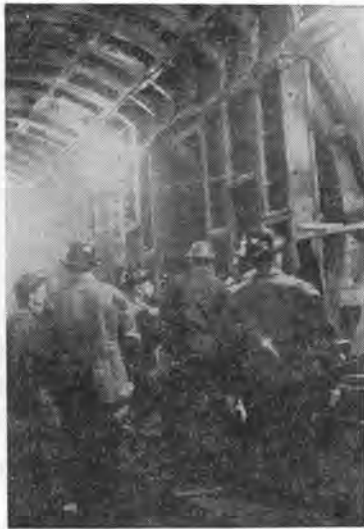
写真-3 レニングラード において目下建設 工事中の駅部に相 当する部分で、写 真-1のような構 造に完成される。
