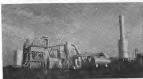
写真-1 三菱 120t/hr アスファルトプラント
