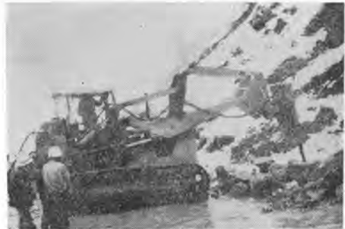
写真-1 作業中のストロングブレーカ KOK S-800 型全景
