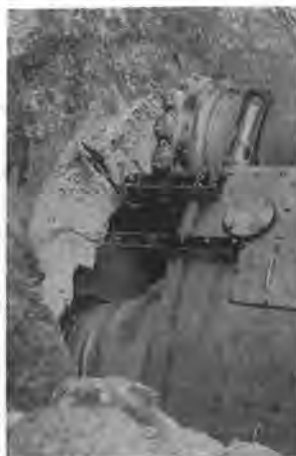
写真-10 坑口切付状況
