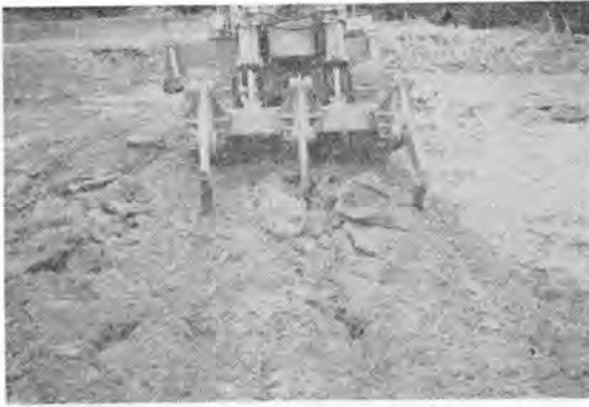
写真-3 1本掛けリッピング作業
