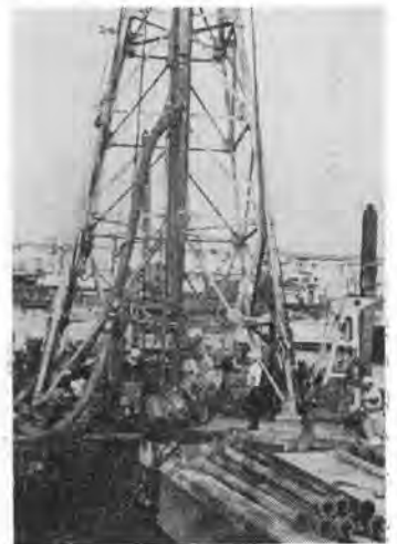
写真-1 ケーシング打込みが終わり、ユンボビットによる掘削開始直前
