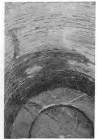
写真-8 切削されたトンネル内部 (切羽と天井壁)
