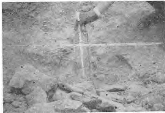
写真-4 1本掛け作業によるリッピング破碎状況
