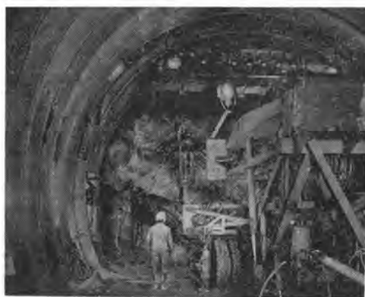
写真-10 スイス国道2号線パレグトンネル切羽全景 トラックマウントジャンボにより発破切削、 パワーユニットは上端に格納し、前面はし ゃ閉板で防護してある。
