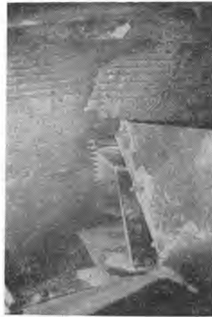
写真-5 摩耗によるビットの交換は 100 m ごとに行なわれる。カッタにより切削された刃跡、手前に見えるのはパケットの先端部である。
