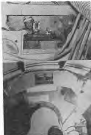
写真-12 (上) セットした測量機械 (下) シールドに取付けた特殊目盛板
