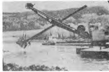
写真—1 しゅんせつ作業
