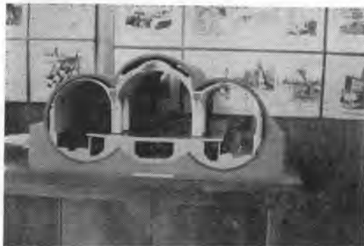
写真1 地下鉄駅部建設にシールドを所要間隔に並列して掘進し、中間部はルーフシールド方式を採用した新工法である。
