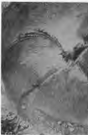
写真-9 内側カッタにより切削された切羽
