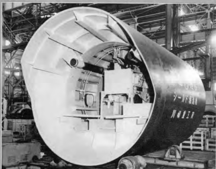
← 外径 3,300mmφ×長さ 4,650mm 手掘式シールド
