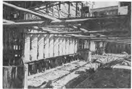
写真-4 ビル現場における完成したプレウォール
