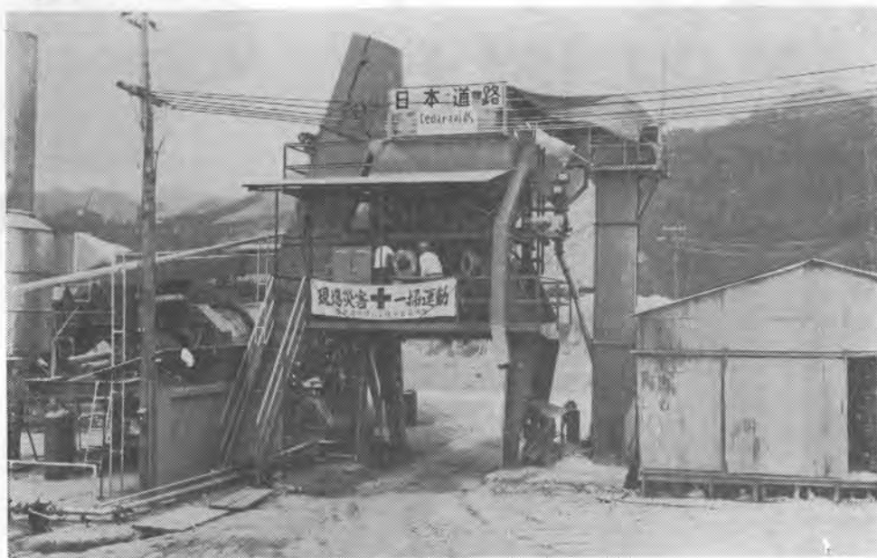
▲ セダラピッドH-20, 全自動バッチプラント60~80t/時 及6422-Pドライヤーが亀山地区にて稼動中
