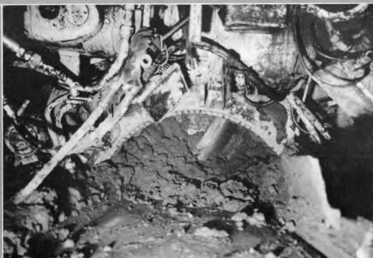
↑掘削土砂の排出状況
