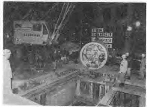
写真-4 夜間施工によるシールド取卸し作業
