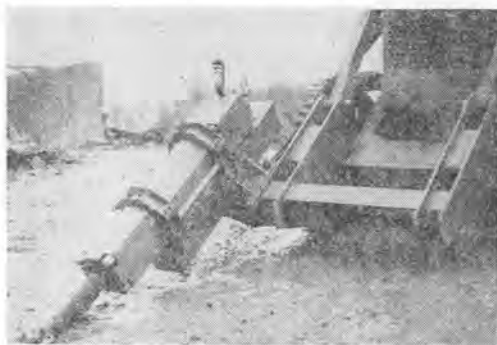
写真-2 取付け状態
