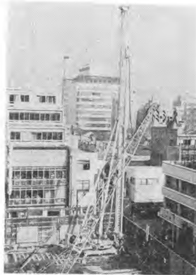
写真-2 プレボーリング機械全景
