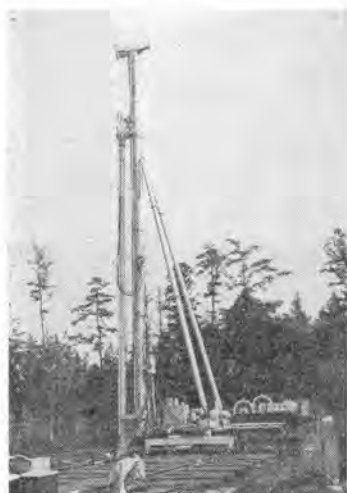
写真-5 実験中の新型プレボーリング機械全景
