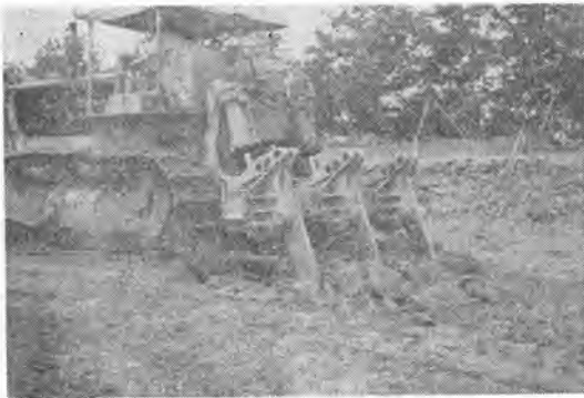
写真一1 3本掛けリッピング作業
