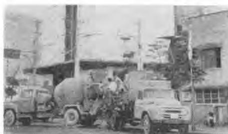
写真-1 市街地での打設現場
