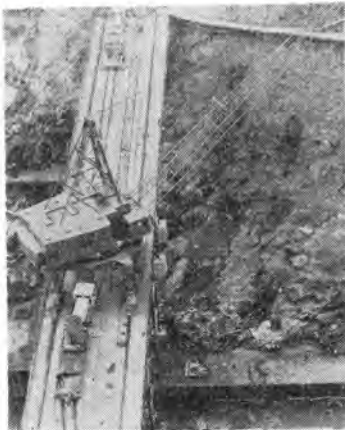
写真-3 ジブクレーンによる打設 (下流側トレSSL)
