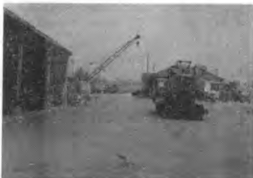
写真-3 建設部永登浦機械工場 (P & H トラッククレーンがみえる)
