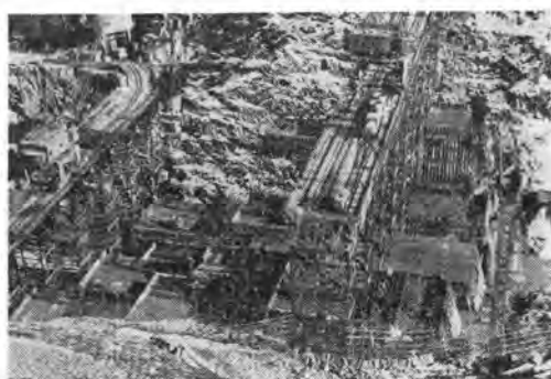
写真-4 打設中の下久保ダム (41年1月5日) 左岸上部ダムサイトから本体下部を見る (打設約 60,000 m 3 )
