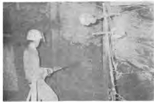
写真-8 吉岡調査斜坑のコンクリート吹付状況
