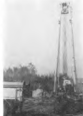
写真-1 ヴィルト社のエアリフトドリル L10 掘削作業中
