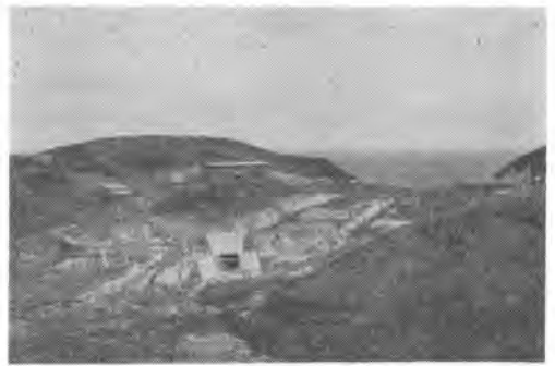
写真-2 本州方竜飛現場全景
