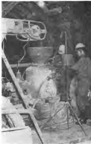
写真-7 吉岡調査斜坑のコンクリート吹付機
