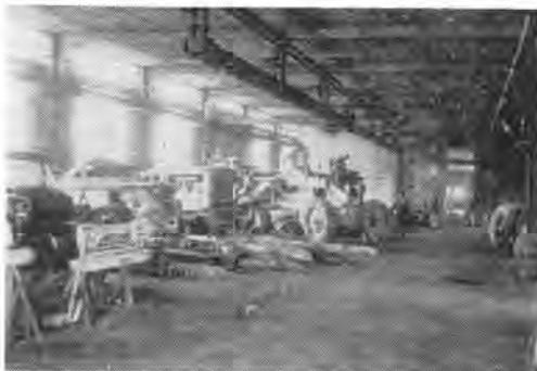
写真-2 建設部機械工場(分解組立工場)
