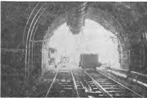
写真-4 吉岡調査斜坑坑口付近
