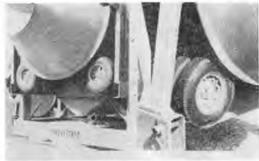
写真-1 コンクリートミキサの摩擦車駆動 (p. 422 Bild 2)
