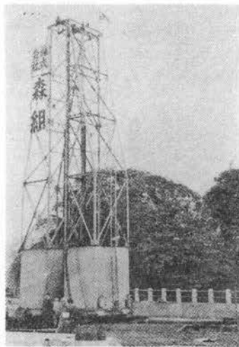
写真-9 森式圧入工法
