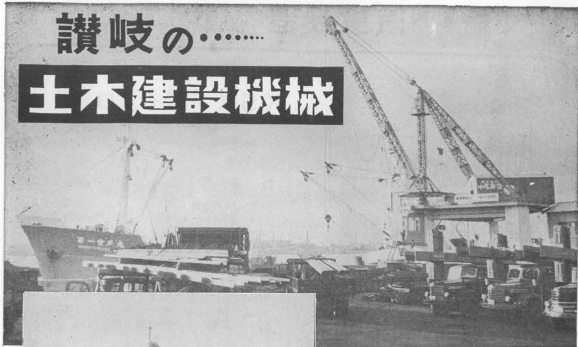
10\frac{t}{5t} \times 9M/18M 三脚デリック
