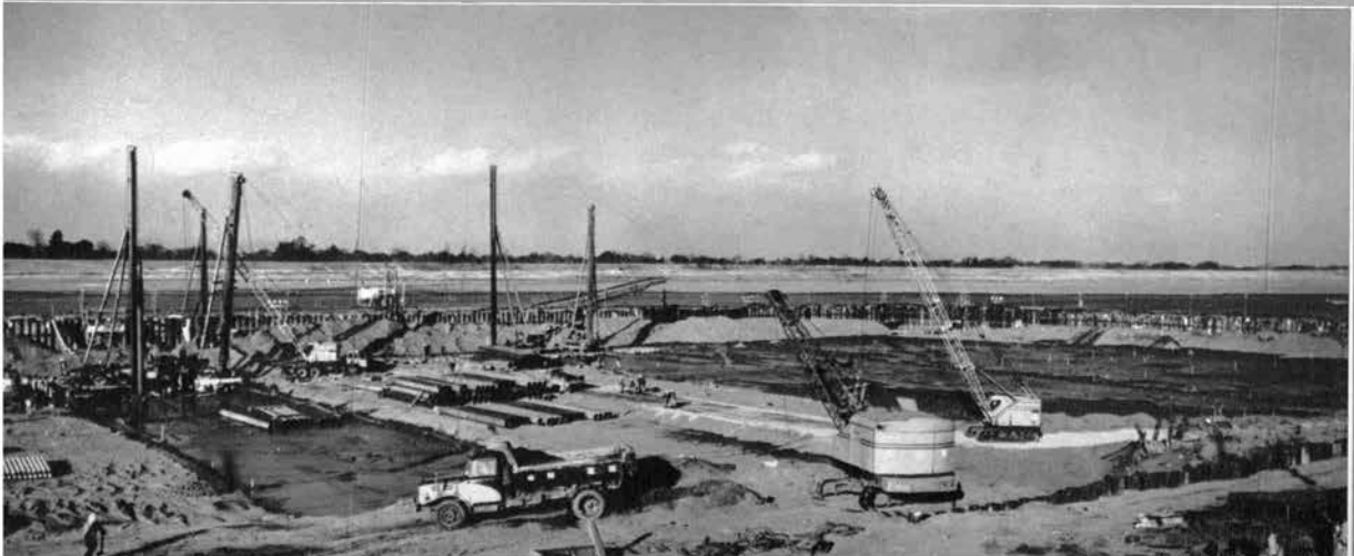
利根大堰工事第1期締切 ↓ 長さ330m 幅150m
