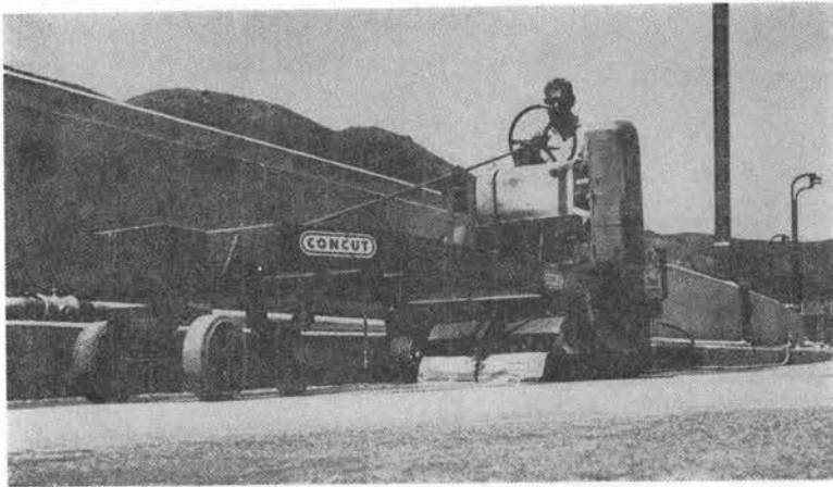
写真-1 バンブカッタによる路面研削作業
