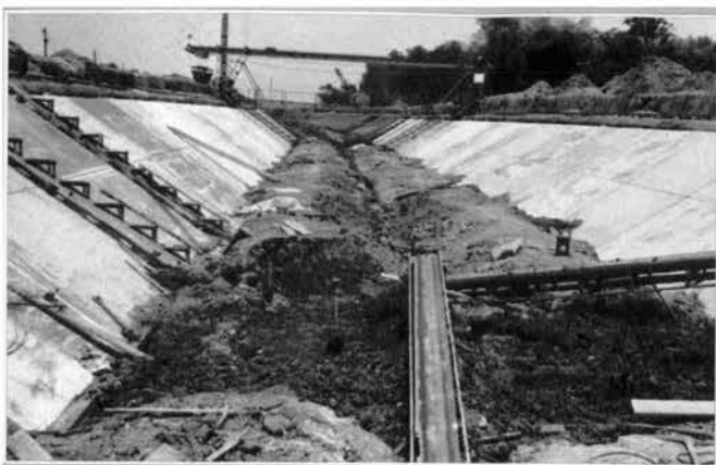
↑ 工事中の武蔵水路
