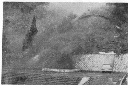
写真-9 八井谷トンネル自然換気測定 立坑吐出口における坑内発煙筒によるテストの煙の流出状況
