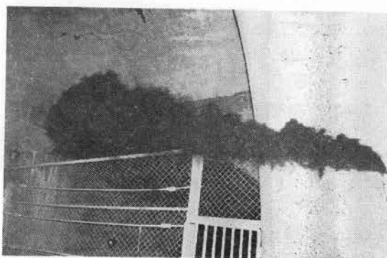
写真-10 八井谷トンネル自然換気測定 発煙筒による坑内立坑接合部における立坑への吹込み観察
