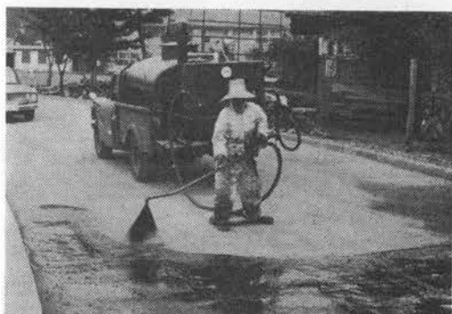
ローリー型アスファルトエンジンプレヤー 1500ℓ
