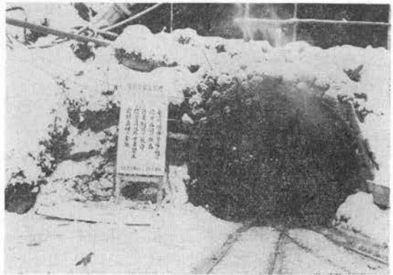
写真-2 函館本線納内～伊訥間 神居ずい道(4,540m)坑口付近
