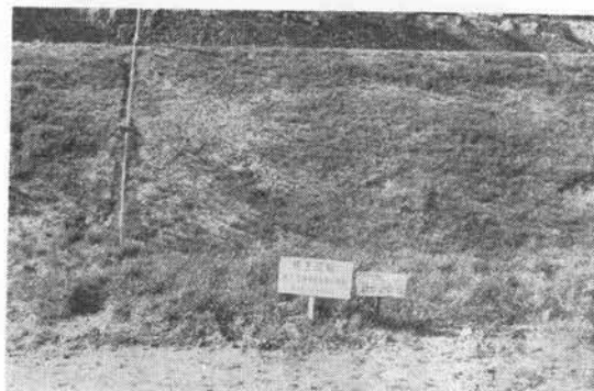
写真-12 泉北地区機械化施工計画 のり面保護工のテストフィールドの一部
