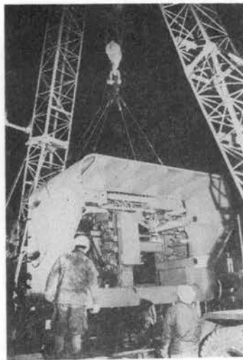
写真-22 AT-304型 矩形シールド掘進機
