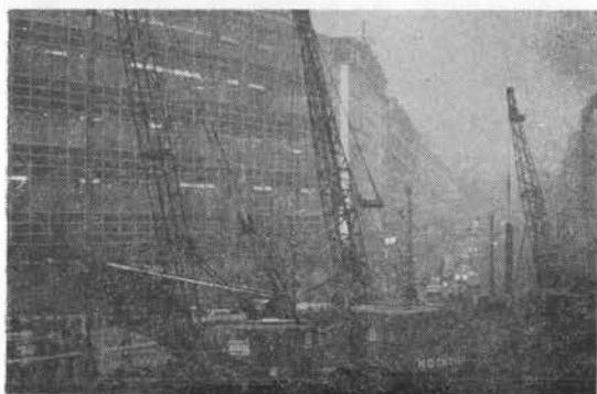
写真-2 フランクフルトの地下鉄中央駅工事の泥水工法現場
