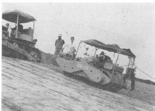
写真-15 ダイハツ振動のり面締固め機
