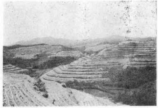
写真-3 多良岳地区階段工
