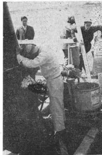
写真—4 半自動溶接による継手試験
