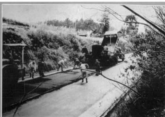
↑表層アスファルトコンクリート 5 cmを舗設中
