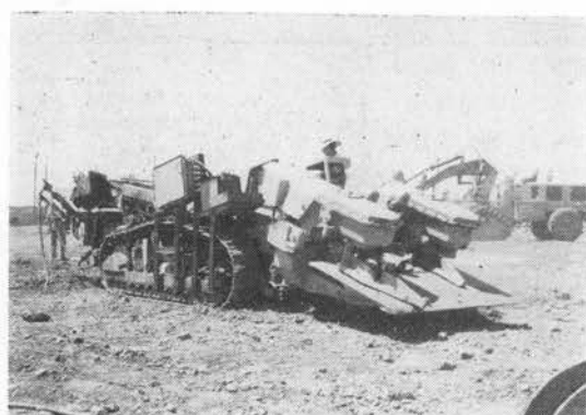
写真-3 斜坑用大型岩石積込み機 ギャザリングローダ
