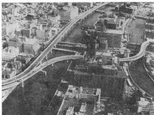
写真-3 大阪1号線中之島付近
