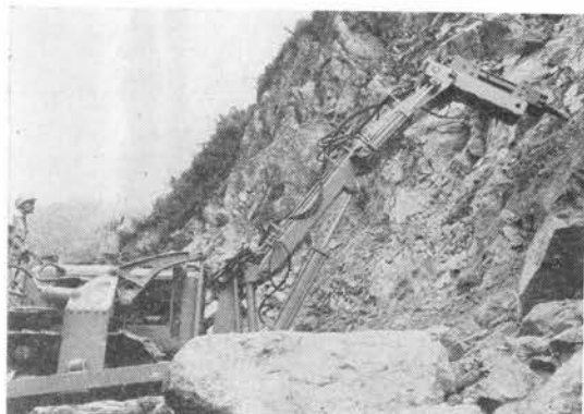
写真-14 プルドーザをベースマシンとしたトラクタブレーカ
