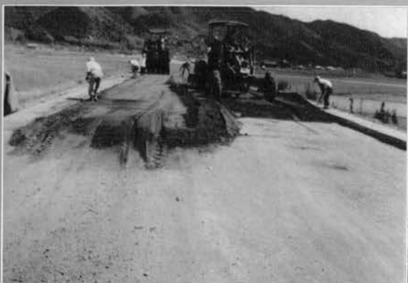
↑ソイルセメント舗設中
