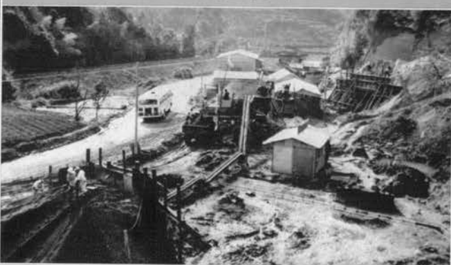
← シラス台地をブルドーザにより カット，敷きならし中 (水俣地区)
