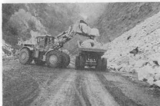
写真-1 キャタピラーホイールローダ988型 22t ダンプに積込み作業
