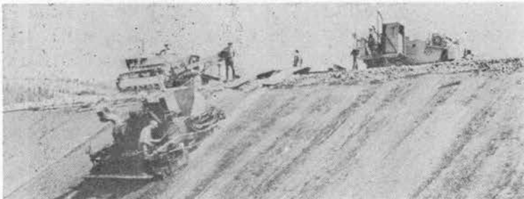
写真-1 舗設作業
