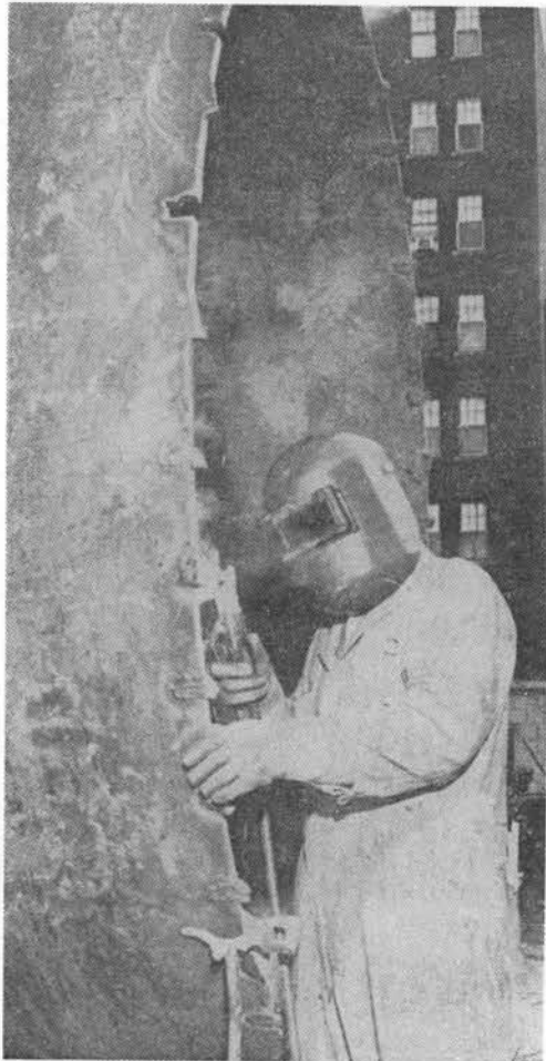
写真-1 炭素鋼の鋸歯状の切刃溶接
