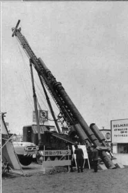
↑45°傾斜まで可能な斜くい打ち機
