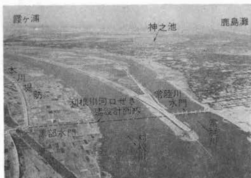
写真-1 利根川河口ぜき建設予定地
