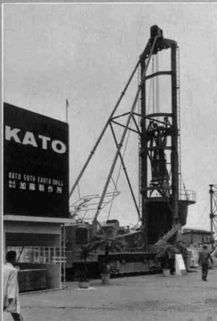
↑掘削径2 mの大型アースドリル
