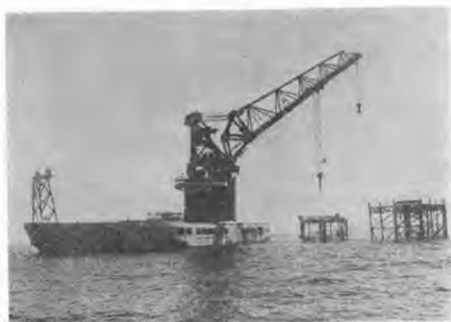
写真-1 自走式起重機船による置やぐら設置
