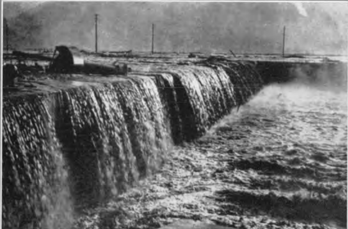
↑津波の被害状況 (大船渡港1万t岸壁)
