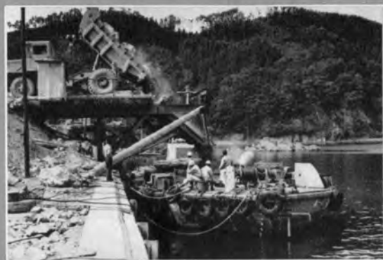
↑ 石運船への捨石積み込み状況 (22.5t積みタンブトラック)
