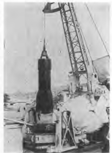
写真-4 砕岩ビット現場作業(BT-2型)
