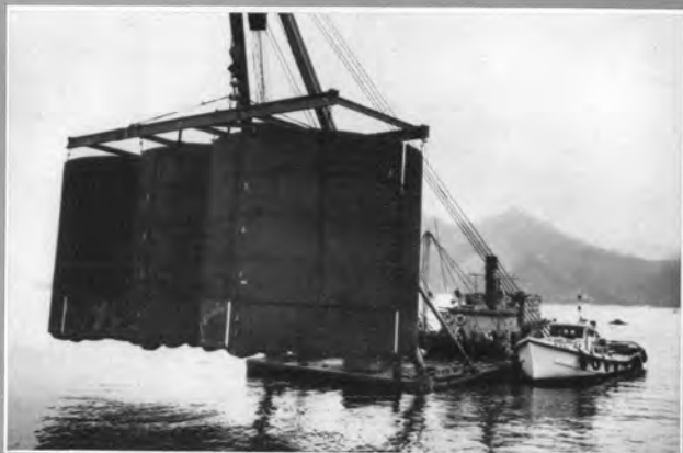
↑50tつり起重機による鋼セル据付け作業
