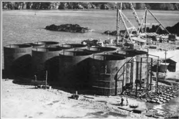
↑鋼セル製作状況
