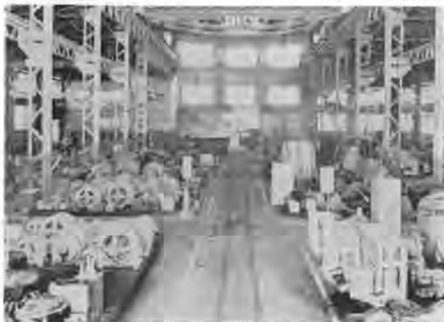
写真-1 東京機械工場第1工場内部
