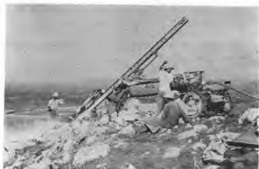
写真-4 傾斜せん孔中のクローラドリル
