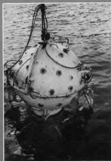
← 潜水函による捨石投入状況の調査
