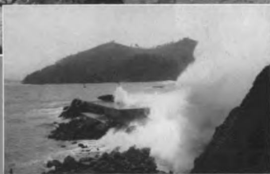
↑工事現場に打寄せる大波
