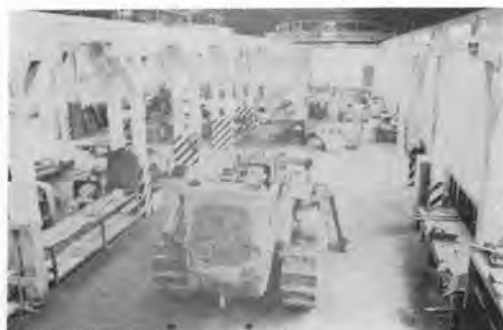
写真-2 東京機械工場第3工場内部
