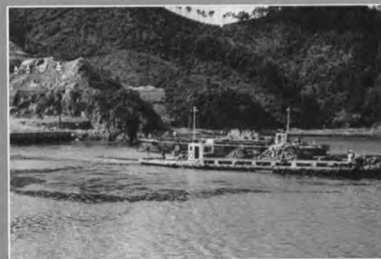
↑ 底開式石運船による捨石運搬
