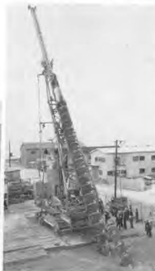
写真-2 斜くい打機 (呉一メンク MR 60)
