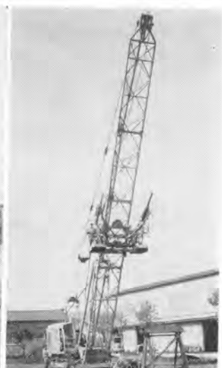
写真-3 高所岩壁掘削機
