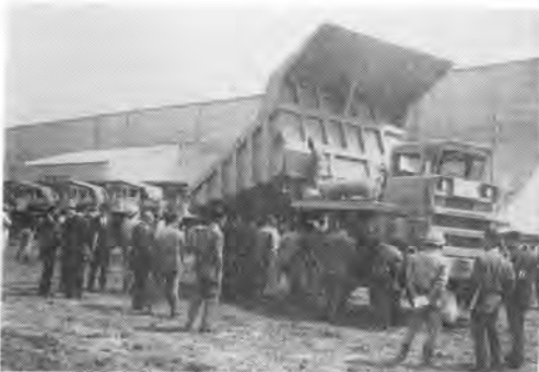
写真-1 リヤダンプトラック (ル・ターナモデル 30)
