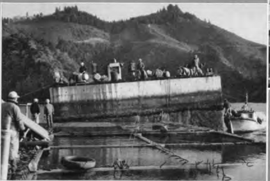
↑ケーソンの据付け状況
