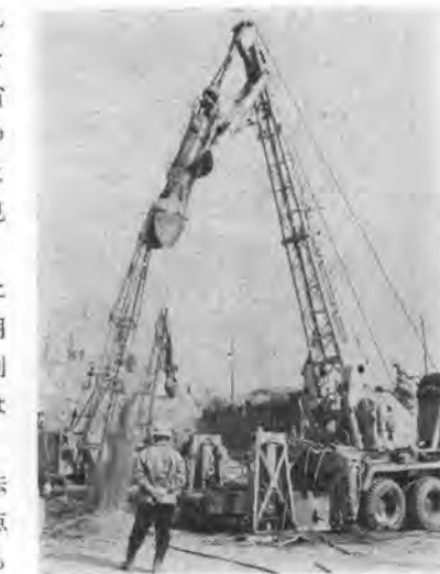
写真-3 大阪市水道局豊野浄水場本館新築工事 (BT-2 型による作業現場)
