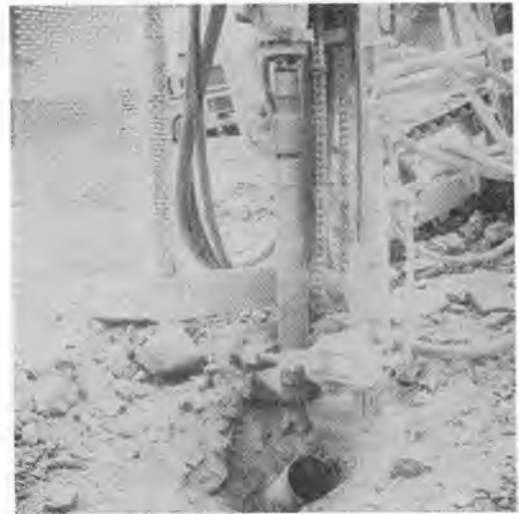
写真-1 ダウンザホールドリルの使用状況
