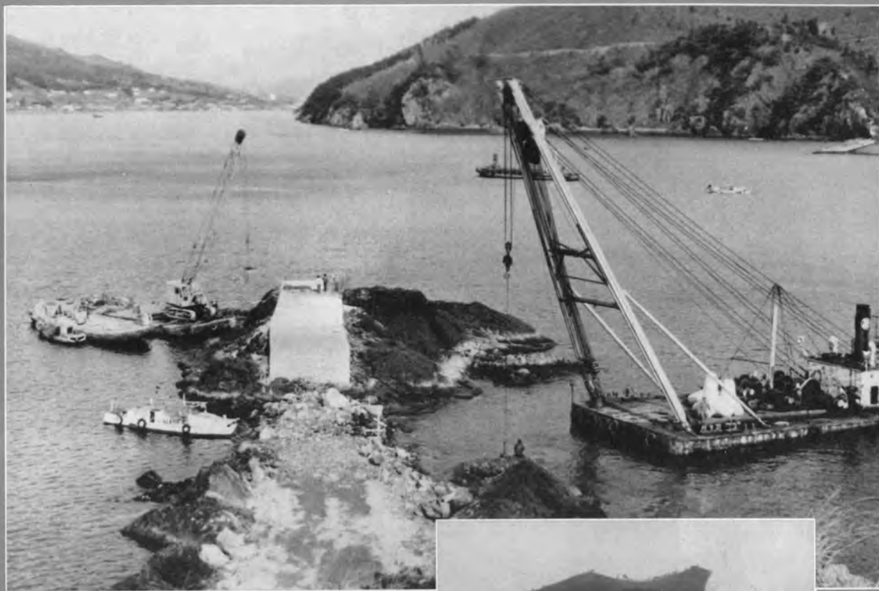
↑長磯側取付部における テトラポット（8t）据付け作業
