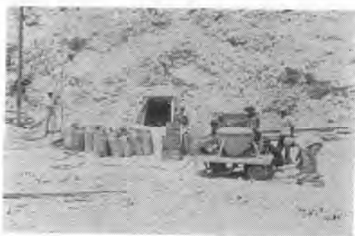
写真-2 AN-FOのチャージャによる坑道発破方式の装薬準備
