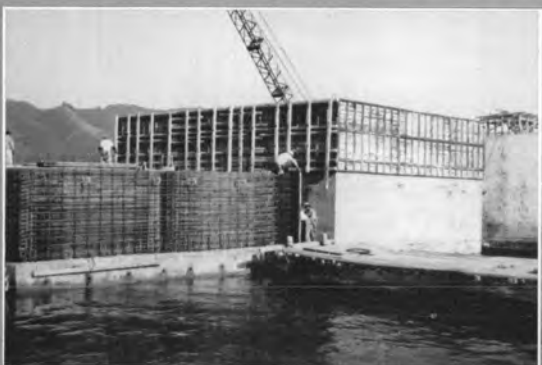
↑大船渡におけるケーソン継足し作業
