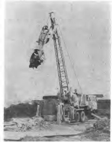
写真-1 三菱ベント BT-2 型による掘削状況
