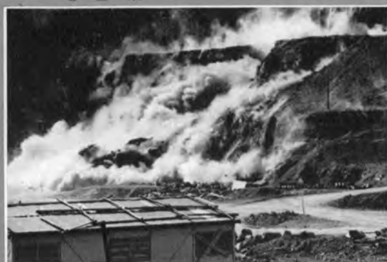
↑ 原石山の坑道式発破による捨石採取
