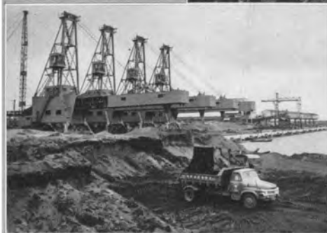
↑ 先方に見える石炭積出しロータほぼ完成 手前はトラクタショベルによる上層部分の掘削作業(昭和37年)
