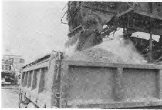
写真-6 ミキサからダンブに積込む
