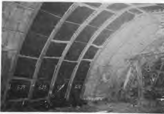
写真-4 張り上がったビニールシート
