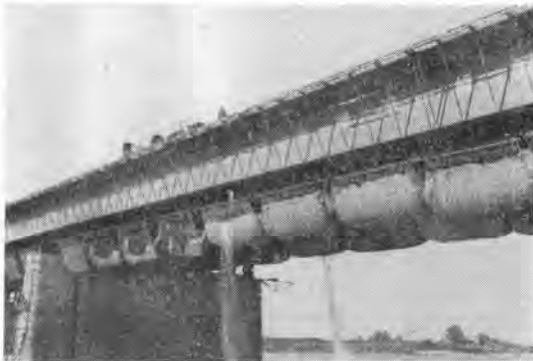
写真-1 名神木曾川橋における水荷重使用の床版打設
