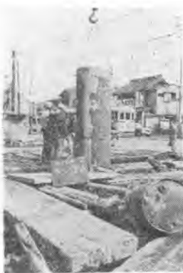
写真-4 ケーシング建込み
