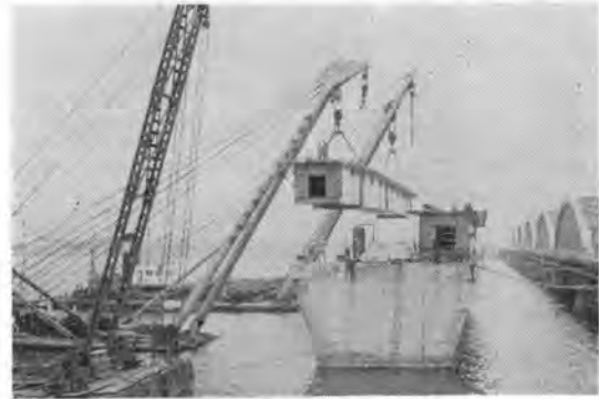
写真-6 架設中の新伝法大橋
