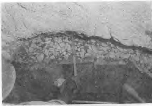
写真-8 凍土壁と松板間に碎石を詰める
