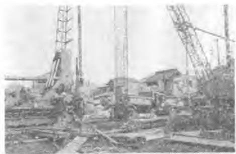
写真-6 鉄筋建込み
