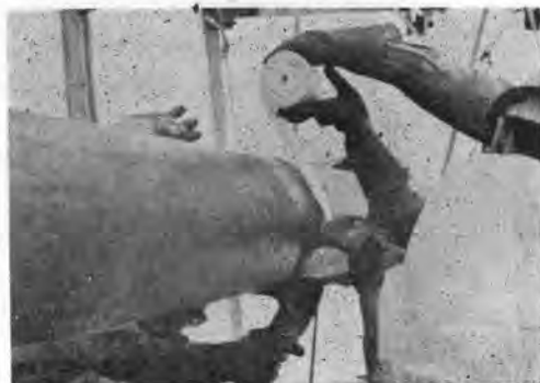
写真-2 テープ状のガラス布巻付け
