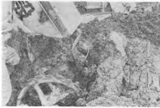
写真-5 ペケットローダによるロームの積込み
