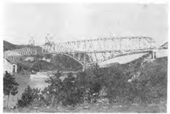
写真-2 天草橋1号のキャンチレバー架設
