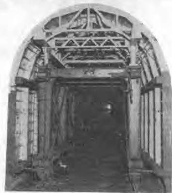
写真は国鉄新清水隧道工事用 スチールフォーム
