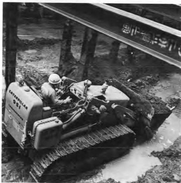
●名古屋で地下鉄金山駅の新設工事に実力発揮… 水谷建材(株)様の951ローダ
