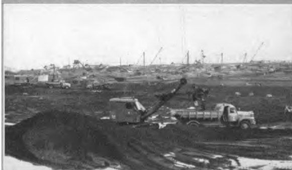
↑ 商港区上層部分の掘削運搬捨土 遠方に雑貨岸壁の矢板打込み中のやぐらが見える。
