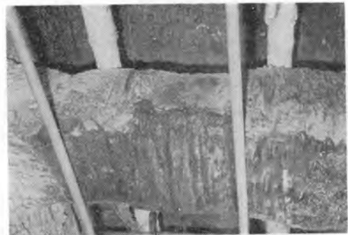
写真-6 凍土ビーム (白く見えるのが凍結管)
