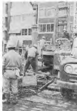
写真-7 トレミー管建込み
