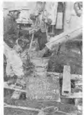
写真-8 コンクリート打設
