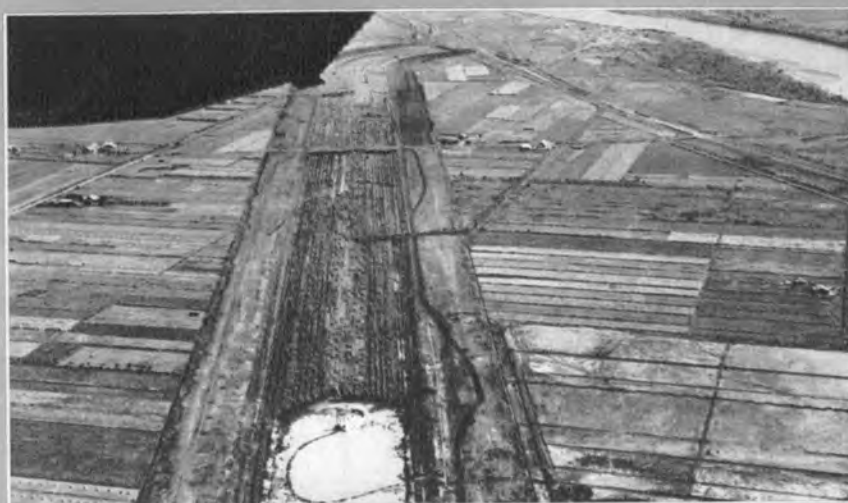
↑篠津運河掘削工事：表土をエキスカベータで掘削後ポンプ船掘削が進んでいる。右上方は石狩川
