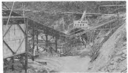
写真-4 第3工区坑口
