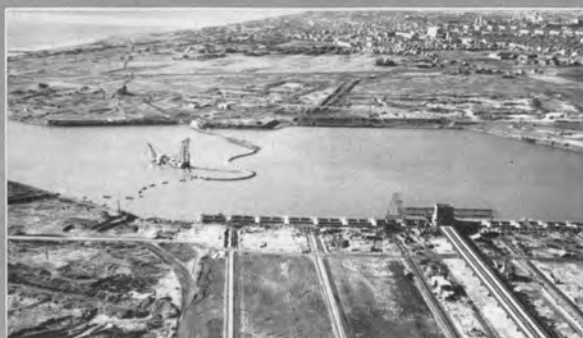
↑ 商港区下層部のポンプ船によるしゅんせつ作業 手前に荷役施設建設中の石炭積出岸壁が見える。(昭和37年)
