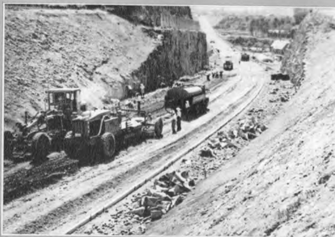
↑ ウッドロッドミキサによる混合作業 (札幌—定山溪間篠舞、この区間は昭和38年完了)
