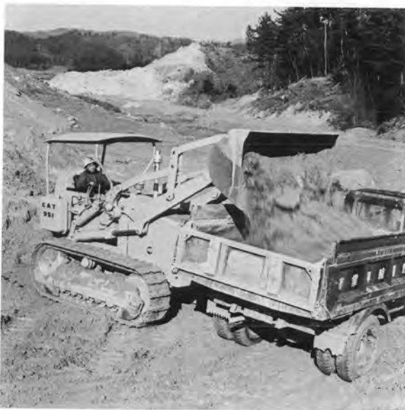
●東名高速道路岡崎地区の建設工事で活躍中の (資)鈴野屋商店様の951ローダ
