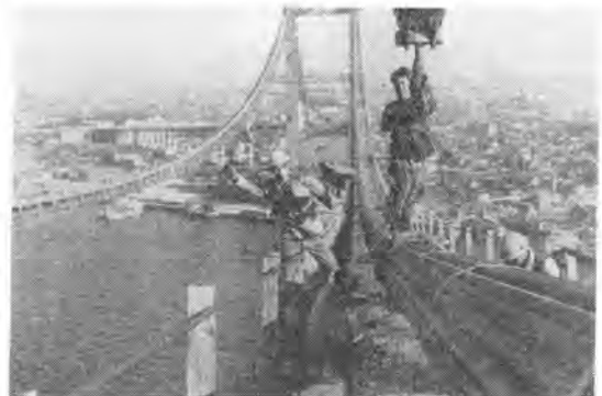
写真-3 ケーブルバンドの取付けとボルトの締付け
