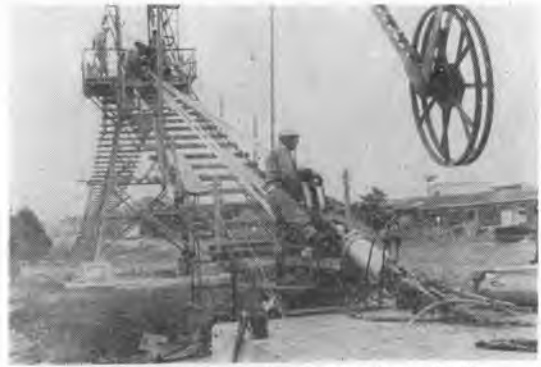
写真-5 平行線ケーブルのエアスピニング実験
