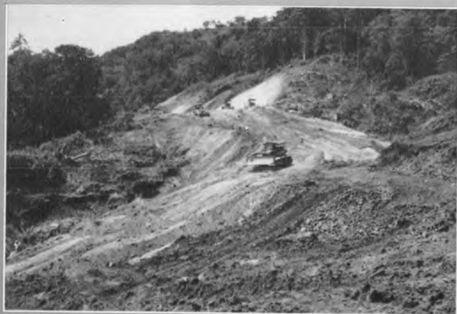
↑ 中山峠頂上付近の土工作业 北海道の山岳地帯は施工期間が非常に短いので作業は昼夜をわかず集中的に行なわれる。
