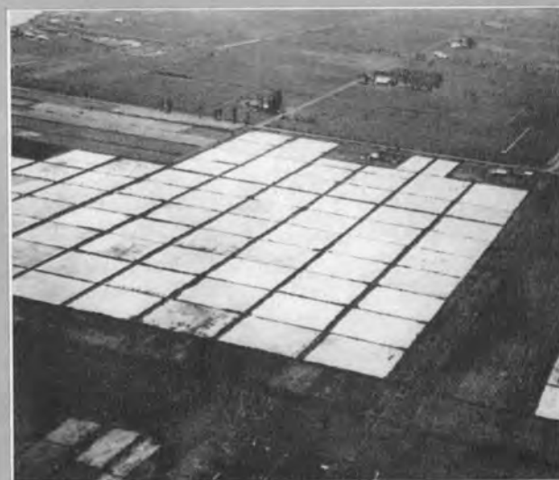
↑篠津運河掘削工事：ポンプ船で掘削し、濃縮排泥溝ハイトロシールポンプで圃場へ送泥客土する。
