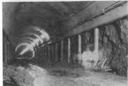
写真-3 コンクリート支柱による片押し掘削
