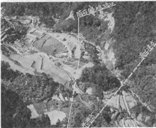
写真-3 筒石斜坑坑口付近 (第3工区)
