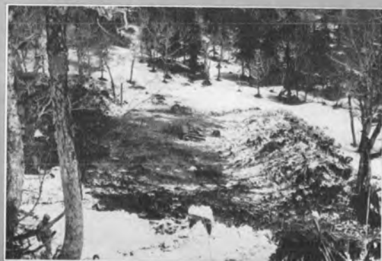
↑ 中山峠頂上付近の除雪作業
