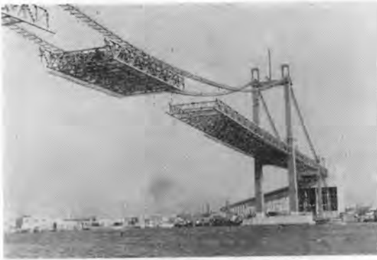
写真-4 補剛トラスの架設進む
